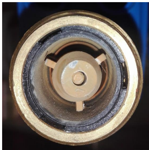
Ilustración 49. Estado de la válvula antirretorno del contador con ID 21
