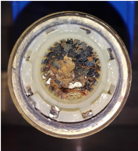
Ilustración 47. Estado del filtro del contador con ID 12
