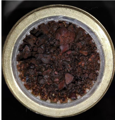
Ilustración 83. Estado del filtro del contador con ID 74
