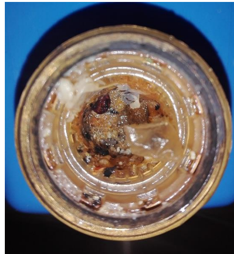
Ilustración 48. Estado del filtro del contador con ID 16
