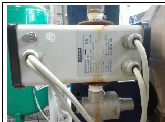
Ilustración 32. Sensor de Siemens (Modelo: SITRANS FM Medio. Tipo:911/F5)
