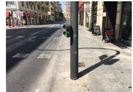
IMAGEN 4. Paso de peatones en la calle de la Paz regulado con semáforo. Ausencia de señalización táctil
