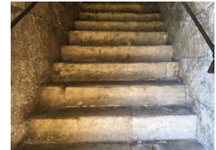
IMAGEN 26. Segundo tramo de la ESCALERA 3
