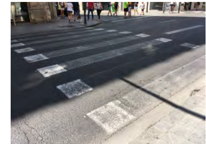
IMAGEN 5. Señalización con pintura únicamente en los límites del vado
