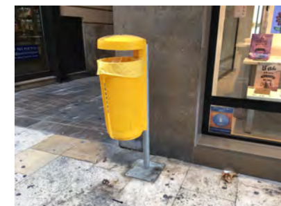
IMAGEN 14. Este modelo de papelera no cumple la altura de la boca ni la proyección al suelo. Además está ubicado en línea de fachada
