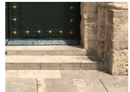
IMAGEN 2. Vista de los peldaños que forman el Acceso 1-2
