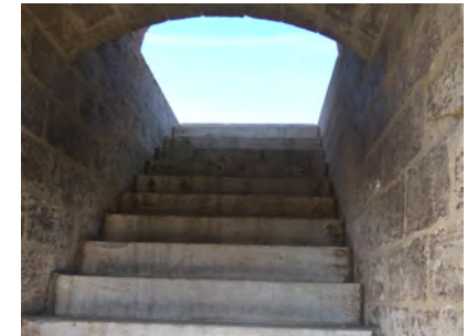
IMAGEN 31. Llegada a planta Terrazas por ESCALERA 5 sin pasamanos
