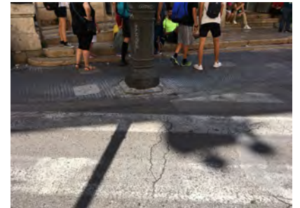
IMAGEN 13. Existencia de mobiliario en medio del itinerario peatonal y falta de señalización de pintura en la calzada
