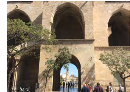
IMAGEN 2. Vista de la parte posterior de las Torres de Serranos
