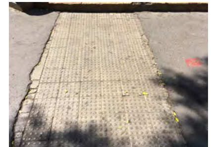
IMAGEN 9. El pavimento táctil llega hasta la línea de acceso al mercado aunque genera resaltes con el pavimento de la acera
