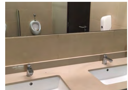
IMAGEN 25. El espejo está demasiado elevado y no tiene inclinación
