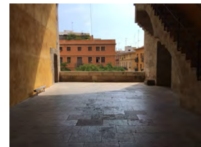
IMAGEN 14. Espacio de la nave lateral donde se accederá por la ESCALERA 3 a la segunda planta
