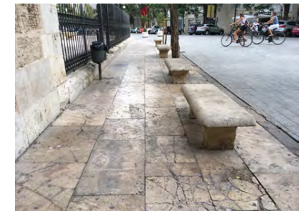
IMAGEN 1. Acera frente a las Torres de Serranos falta de alineación del mobiliario
