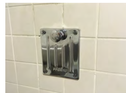
IMAGEN 18. Pulsador de descarga de reducidas dimensiones
