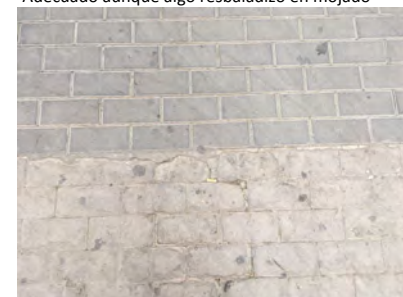
IMAGEN 11. Pavimento de adoquines sin resaltes y con buenas características generales
