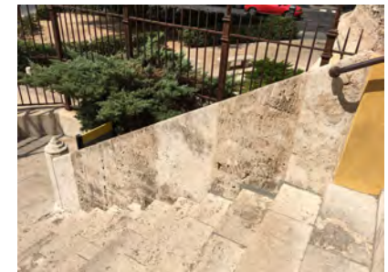
IMAGEN 18. Detalle del pasamanos lateral a una altura; en piedra y metálico
