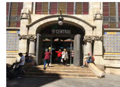
IMAGEN 13. Vista de la escalera de acceso IZQUIERDA 1
