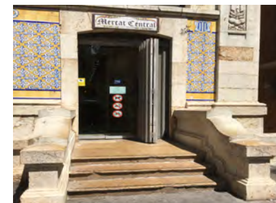
IMAGEN 19. Escalera de ACCESO IZQUIERDA 3. Peldaños con bocel
