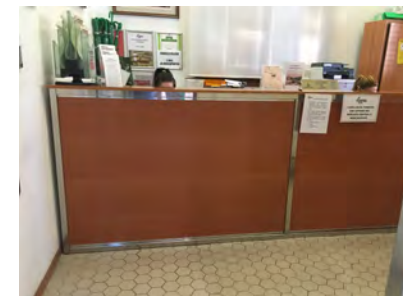
IMAGEN 31. Mostrador de recepción sin espacio reservado PSR
