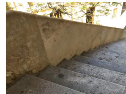
IMAGEN 17. Pasamanos lateral de una sola altura
