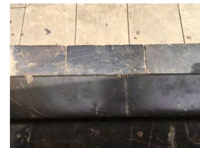
IMAGEN 7. Detalle de los escalones del Acceso 3 y la dificultad para diferenciarlos sin contraste resaltado
