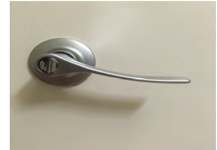
IMAGEN 17. Detalle del cerrojo del aseo de difícil manipulación
