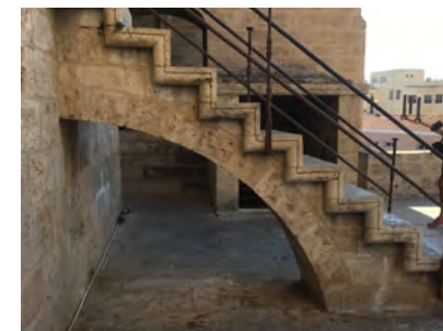
IMAGEN 29. Inicio de ESCALERA 5 que da acceso a la Planta Terrazas
