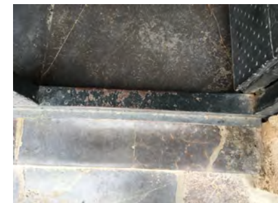
IMAGEN 11. Detalle del ámbito de la puerta de Acceso 4
