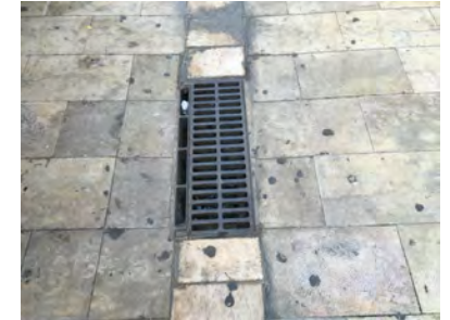
IMAGEN 8. La abertura de los huecos de rejilla es de hasta 0,04m
