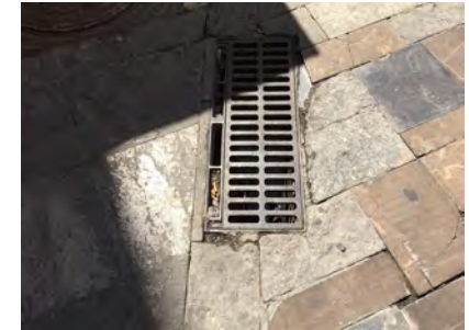
IMAGEN 17. La abertura de los huecos de rejilla es de hasta 0,04m
