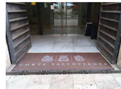
IMAGEN 3. Detalle de la entrada con felpudo no encastrado en el suelo
