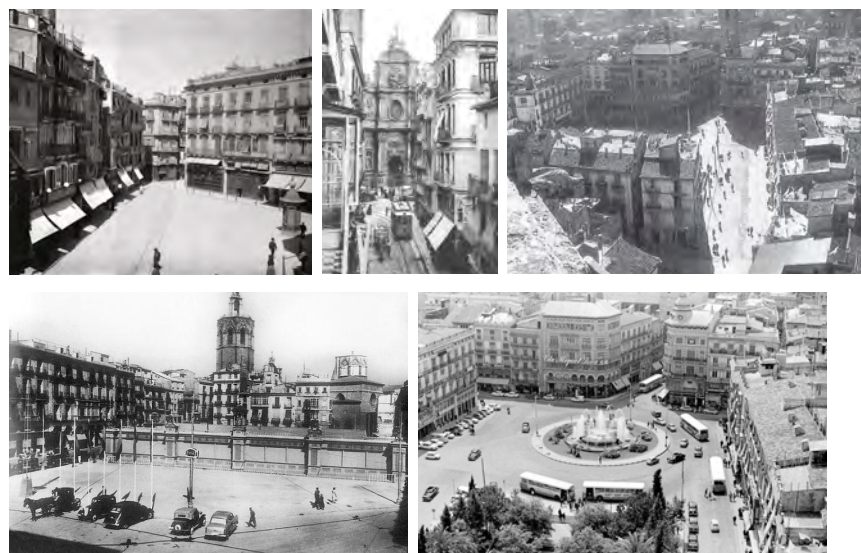
Fig. 35 Evolución de la plaza de la Reina durante los derribos de edificios del siglo XX (Fuente: web: www.jdiezarnal.com )
