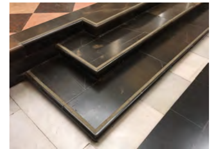
IMAGEN 17. Escalones de subida al altar mayor con contraste señalizador. En algún punto de su perímetro podría diseñarse una rampa
