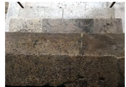
IMAGEN 6. Escalones sin señalización contrastada
