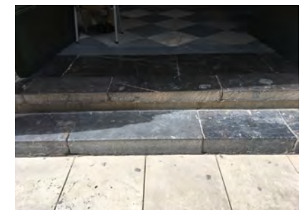
IMAGEN 6. Vista frontal de huellas y contrahuellas de los escalones del acceso
