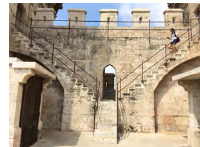
IMAGEN 32. Vista general de ESCALERA 5 que da acceso a la Planta Terrazas
