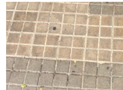
IMAGEN 13. Pavimento de la acera que transcurre previo a la calle Bolsería
