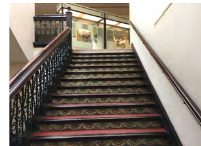
IMAGEN 22. Vista general de la escalera 3 con la tabica contrastada mediante azulejo cerámico
