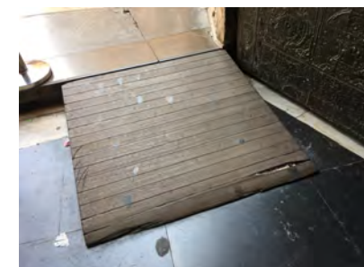
IMAGEN 4. Rampa para salvar el desnivel del peldaño de acceso hacia la zona de visita del Miguelete
