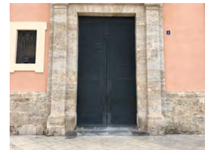
IMAGEN 8. Vista general de la puerta del Acceso 4
