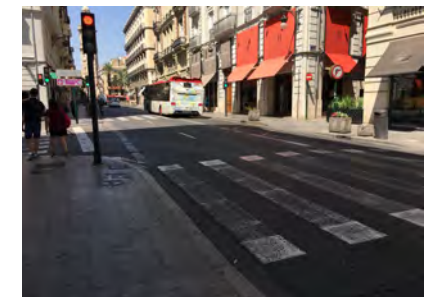
IMAGEN 6. Ausencia de señalización táctil en la acera
