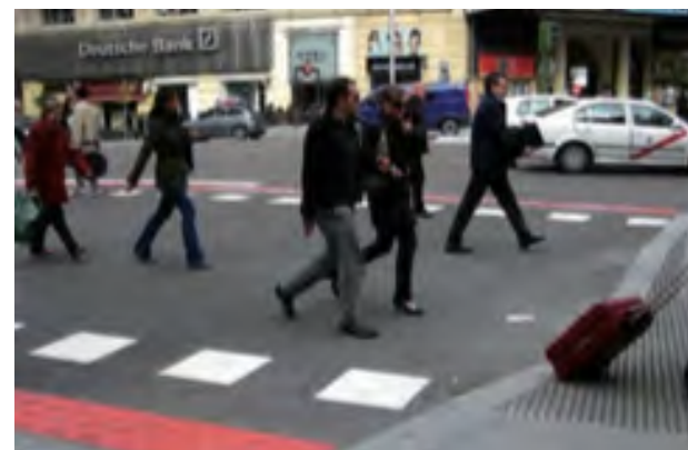
Fig. 76 Pavimentación táctil en vado y límites del paso de peatones (Fuente: FUNDACIÓN ONCE, 2011. Manual de Accesibilidad para Técnicos Municipales . p 288)
