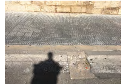
IMAGEN 12. Vista de la señalización táctil en el paso de peatones y la falta de mantenimiento del estado de la calzada
