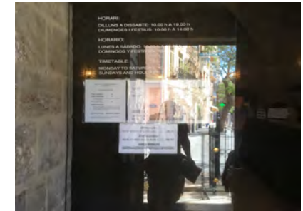
IMAGEN 6. Puerta de vidrio de acceso a recepción sin doble franja contrastada
