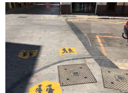
IMAGEN 12. Ausencia de paso de peatones en la calle Quart con la calle Pinzón
