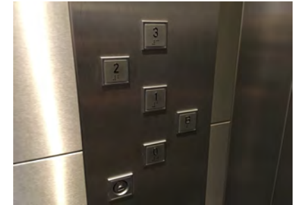
IMAGEN 25. Botones de llamada del interior de la cabina en Braille y altorrelieve
