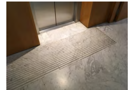
IMAGEN 23. Señalización táctil previa al acceso al ascensor
