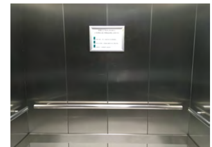
IMAGEN 42. Detalle de la cabina sin espejo enfrente al acceso para facilitar la maniobra de PSR
