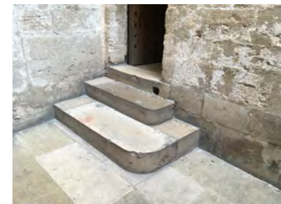
IMAGEN 22. Escalones previos a la entrada a la Torre del Miguelete
