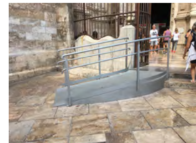
IMAGEN 6. Vista general de la rampa que da acceso a la entrada
