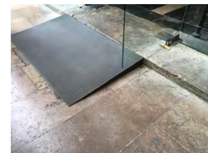
IMAGEN 11. Escalón de acceso desde el jardín a la sala de Contrataciones salvado mediante una rampa
