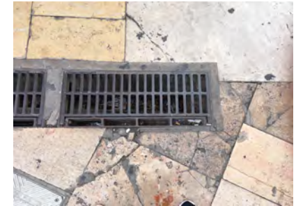
IMAGEN 6. Tapas de registro con abertura de los huecos de rejilla de hasta 0,04m
