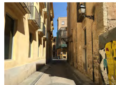
IMAGEN 17. Elementos de iluminación adosados a fachada con altura libre suficiente
