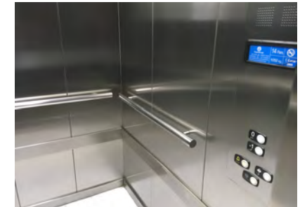
IMAGEN 40. Interior de la cabina del ascensor
