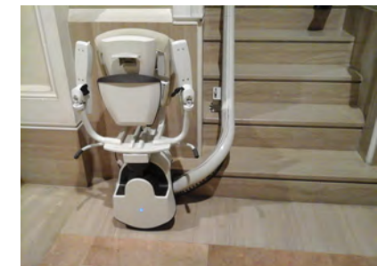
IMAGEN 9. Salva escaleras utilizado para dar acceso a la sala de exposiciones temporales 1
