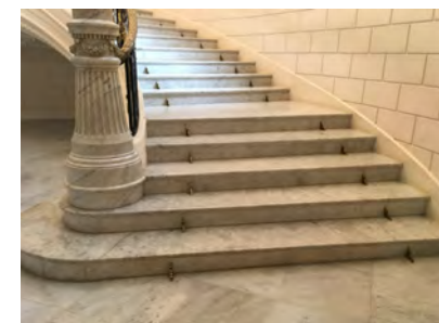
IMAGEN 20. Inicio de la escalera en planta baja
