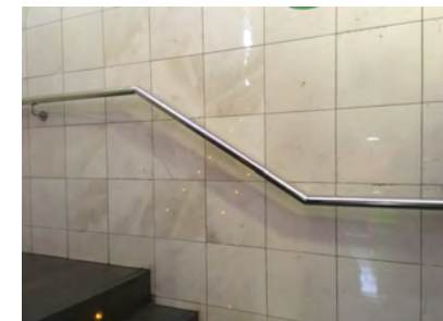
IMAGEN 37. Detalle del pasamanos de una sola altura y continuo
