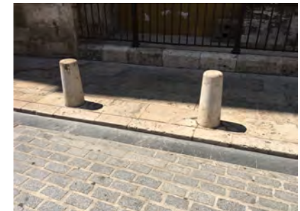
IMAGEN 23. Bolardos junto a las Torres de Quart con dimensiones adecuadas pero sin contraste con el entorno ni en su parte superior
