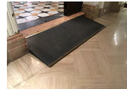
IMAGEN 8. Rampa que resuelve el desnivel generado en la zona del vestíbulo de la escalera principal
