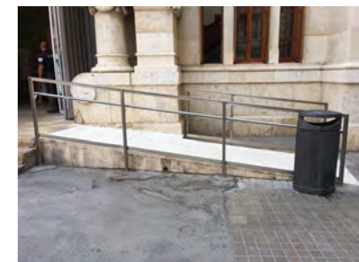
IMAGEN 11. Vista general de la rampa TRASERA DERECHA
