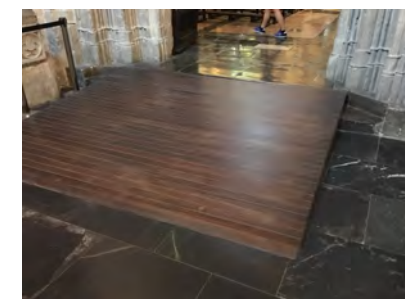
IMAGEN 15. Rampa que salva un escalón para el acceso a la capilla del Santo Cáliz
