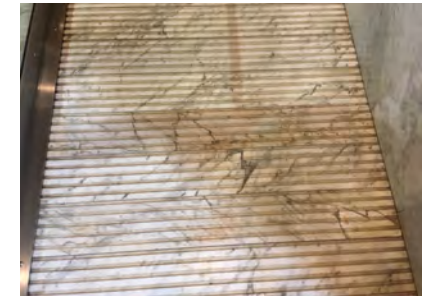
IMAGEN 13. Detalle de las acanaladuras para mejorar la resbaladizidad en el pavimento de la rampa
