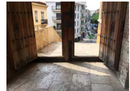
IMAGEN 11. Llegada a Planta 1 desde ESCALERA 2 de Acceso.
