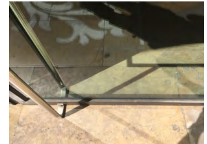
IMAGEN 4. Detalle del ámbito de la puerta de acceso
