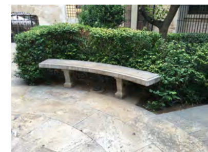
IMAGEN 15. Bancos del jardín no cumplen con los criterios de ergonomía y accesibilidad
