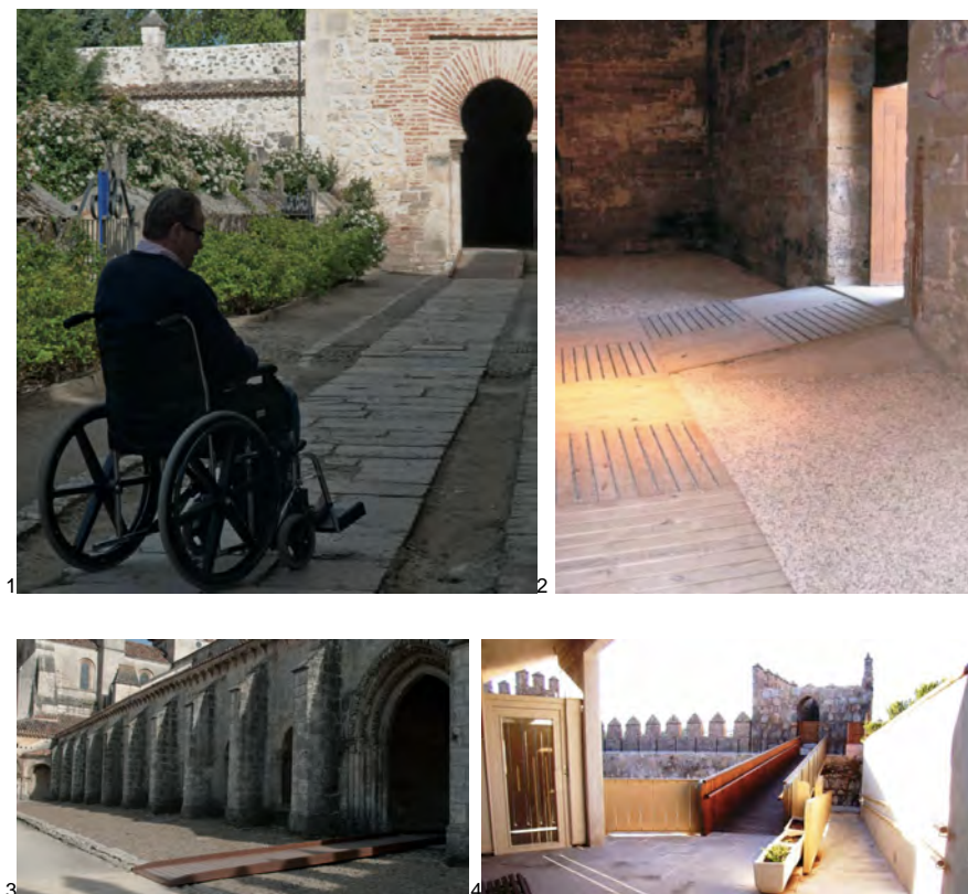
Fig. 64 Soluciones que permiten la circulación y resuelven pavimentos irregulares (Fuente: 1-3-PATRIMONIO NACIONAL. Accesibilidad para personas con movilidad reducida. Monasterio Santa María la Real de la Huelgas , p. 23-27, 2-MINISTERIO DE TURISMO, 2007. Decálogo de Buenas prácticas en Accesibilidad Turística: Destinos y Recursos Culturales y Naturales . Cap. II.4.1, 4- PREDIF. Guía de buenas prácticas en Accesibilidad para los recursos turísticos de las Ciudades Patrimonio de la humanidad . p. 22)
