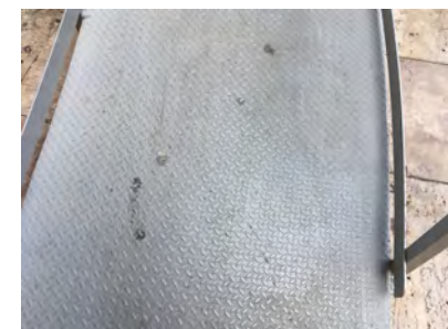
IMAGEN 7. Detalle del pavimento antideslizante
