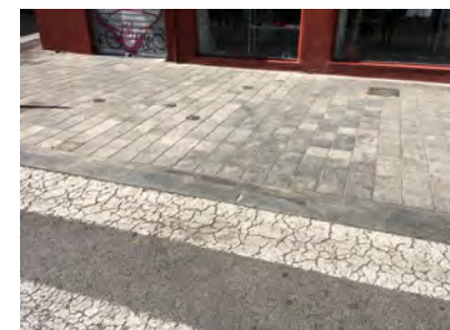
IMAGEN 9. Falta de señalización táctil en la acera recayente a la calle Quart
