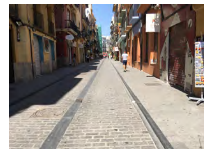
IMAGEN 2. Vista general de la calle Bolsería. Actualmente de uso peatonal mantiene aceras a distinto nivel
