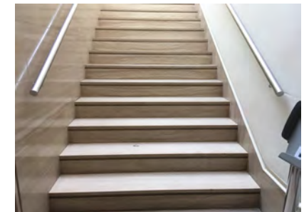
IMAGEN 25. Vista general de la escalera 4 con pasamanos a ambos lados y tabica contrastada mediante hendidura
