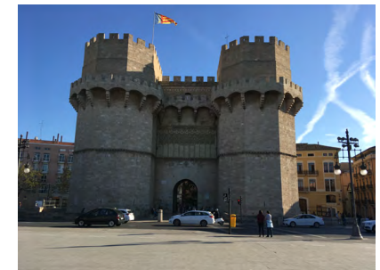
IMAGEN 1. Vista del alzado principal de las Torres de Serranos
