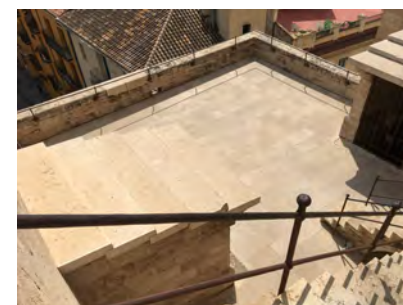
IMAGEN 33. Detalle de la barandilla de ESCALERA 5
