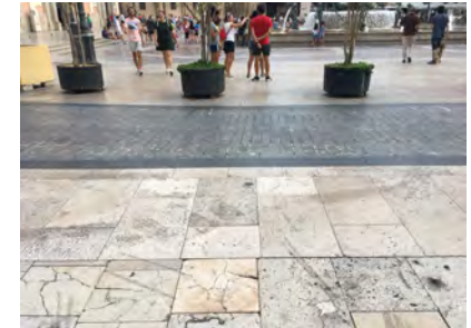
IMAGEN 4. Vista general del paso de peatones de acceso a la Plaza de la Virgen. Inexistencia de pavimentación táctil
