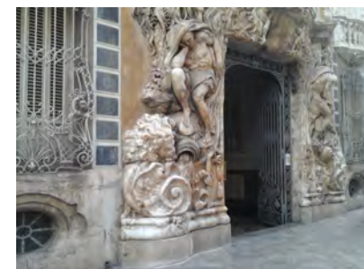
IMAGEN 1. Vista general del acceso principal en la calle de la Cultura
