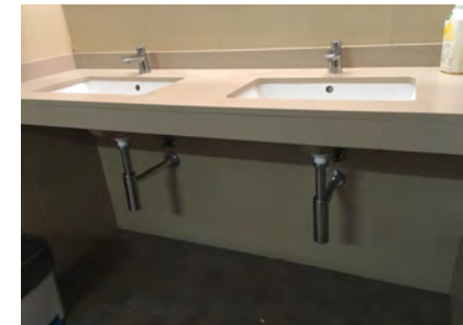
IMAGEN 24. Espacio bajo lavabo para permitir el acercamiento de PSR
