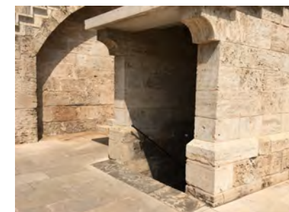
IMAGEN 20. Llegada a Planta 2 a través de la ESCALERA 3
