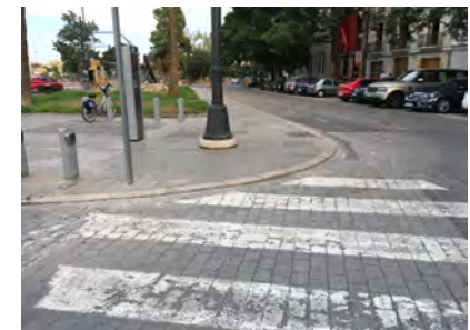
IMAGEN 5. Elementos de señalización e iluminación invaden la proyección del paso de peatones. Ausencia de pavimentación táctil
