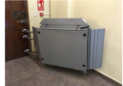
IMAGEN 6. Salva escaleras para el acceso a PSR visto desde el interior del edificio
