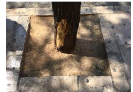
IMAGEN 10. Los alcorques no están protegidos con rejillas
