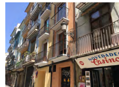
IMAGEN 20. Elementos de iluminación en fachada
