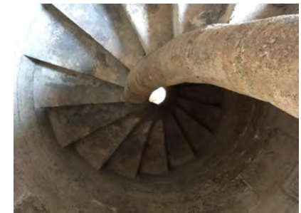
IMAGEN 35. Vista general de la subida por la escalera de caracol a la planta TERRAZAS
