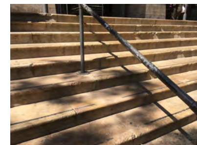
IMAGEN 2. Escalera Principal con escalones con bocel y pasamanos de una altura
