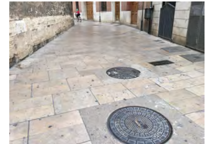
IMAGEN 6. Vista general de las rejillas y tapas de registro en este tramo de la calle Barchilla
