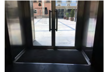
IMAGEN 2. Interior de la puerta de acceso con felpudo encastrado al suelo
