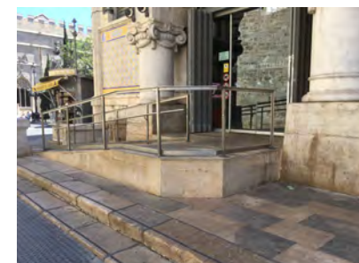
IMAGEN 26. Rampa de acceso DERECHA 2
