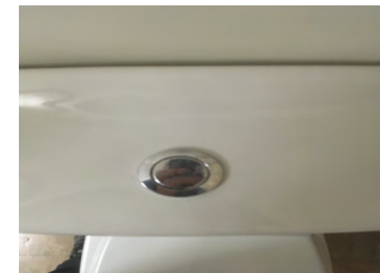
IMAGEN 18. Mecanismo de descarga de difícil accionamiento
