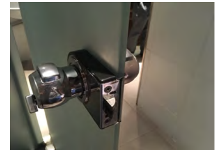
IMAGEN 34. Sistema de cerrojo de difícil manipulación
