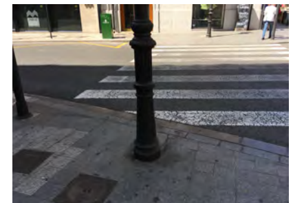
IMAGEN 9. Mobiliario urbano invadiendo el itinerario de cruce del paso de peatones
