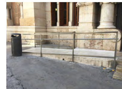
IMAGEN 10. Vista general de la rampa TRASERA IZQUIERDA
