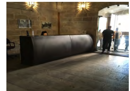
IMAGEN 9. Mostrador de la recepción sin diferenciación de altura
