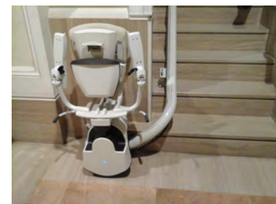
IMAGEN 21. Salva escaleras utilizado como itinerario alternativo a la escalera 2 para personas en silla de ruedas.
