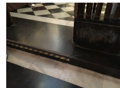
IMAGEN 16. Escalón de acceso a la capilla de San Pedro Apóstol sin rampa pero con contraste señalizador
