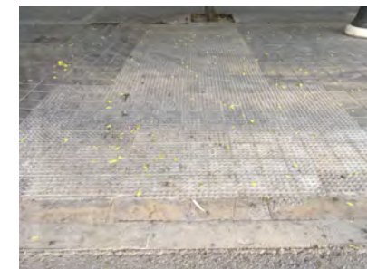
IMAGEN 8. Señalización táctil mediante botones en sentido longitudinal y trnasversal
