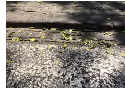
IMAGEN 5. Bordillo existente en e paso de peatones dificultando la movilidad de usuarios de silla de ruedas
