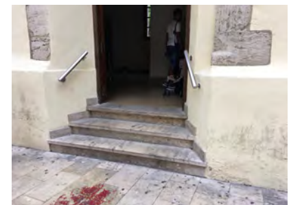
IMAGEN 2. Puerta de entrada general al edificio de la Lonja
