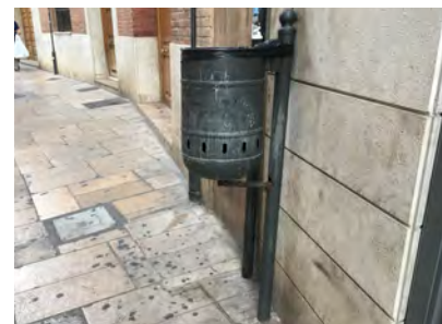
IMAGEN 11. Papelerera no accesible, sin proyección hasta el suelo y ubicada junto a la fachada
