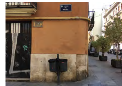
IMAGEN 20. Papeleras adosadas a fachada en vez de línea exterior con el resto de mobiliario. No tiene proyección hasta el suelo
