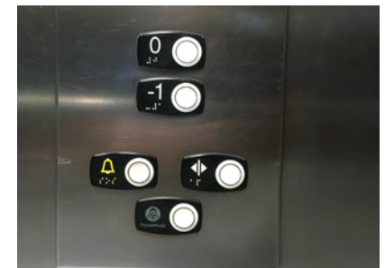
IMAGEN 41. Detalle botonera contrastada en altoparlante y Braille
