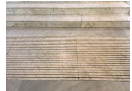
IMAGEN 15. Detalle de la señalización táctil previa a la escalera
