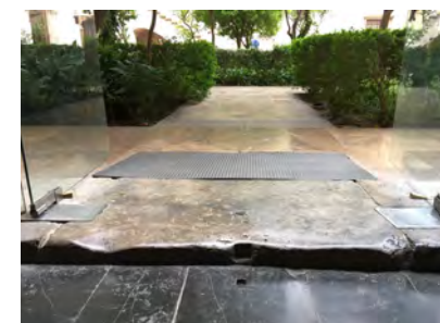
IMAGEN 12. Ausencia de rampa en el otro lado del escalón para el acceso a la sala de Contrataciones
