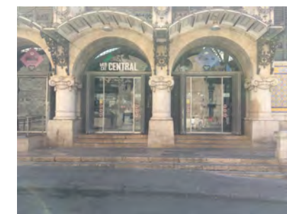
IMAGEN 24. Vista general de la escalera de entrada por el acceso DERECHA 2
