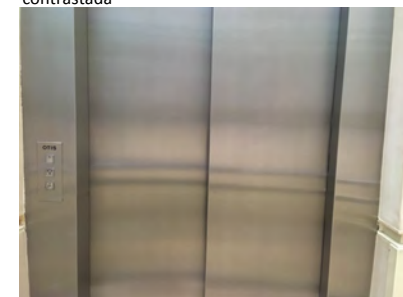
IMAGEN 28. Puerta de acceso al ascensor
