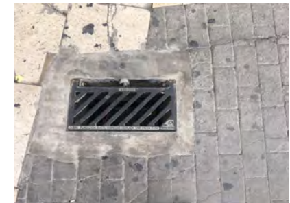
IMAGEN 10. La abertura de los huecos de rejilla es de hasta 0,04m
