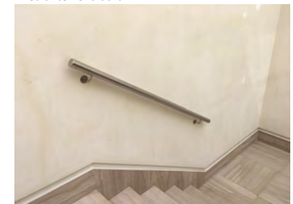
IMAGEN 26. Detalle del pasamanos discontinuo en los rellanos
