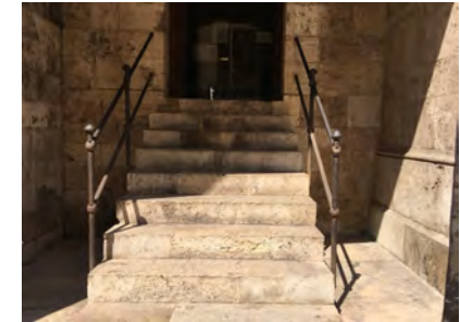
IMAGEN 4. Escalera 1 de acceso a la recepción con pasamanos doble a ambos lados
