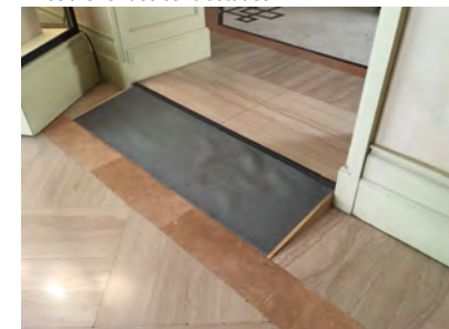
IMAGEN 12. Rampa para solucionar el desnivel en el itinerario de la segunda planta
