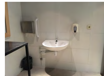
IMAGEN 35. Vista general del lavabo con espacio inferior para la aproximación
