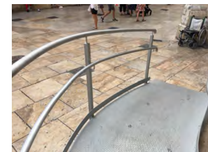
IMAGEN 8. Detalle de los pasamanos a doble altura y el zócalo
