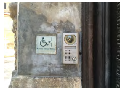
IMAGEN 2. Indicación y timbre de llamada en el acceso de usuarios de silla de ruedas
