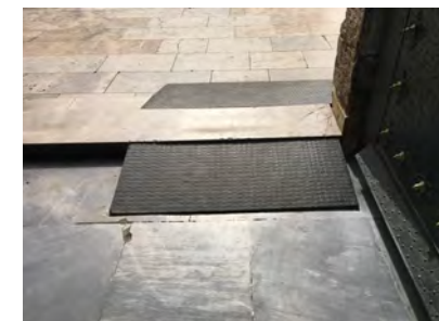
IMAGEN 4. Detalle de la rampa ubicada en el interior de la Basílica
