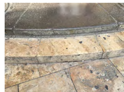
IMAGEN 2. Peldaños que dan acceso a la puerta de entrada
