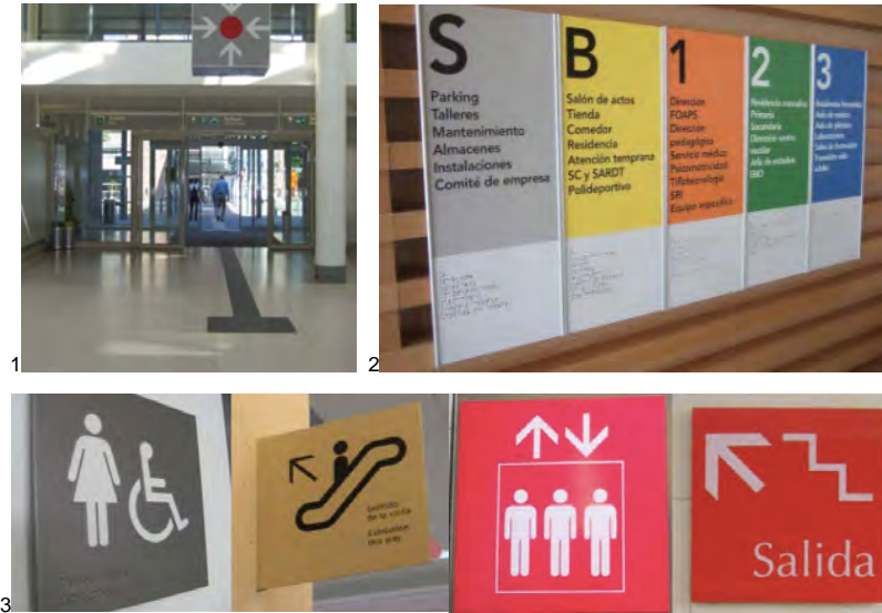
Fig. 73 Ejemplos de buenas prácticas de señalización: Pavimentación táctil, contrastes cromáticos, pictogramas normalizados y complementación de los textos en braille y altorrelieve (Fuente: 1- FUNDACIÓN ONCE, 2011. Manual de Accesibilidad para Técnicos Municipales. p.40, 2-3-PREDIF. Guía de buenas prácticas en Accesibilidad para los recursos turísticos de las Ciudades Patrimonio de la humanidad. p.75-76)
