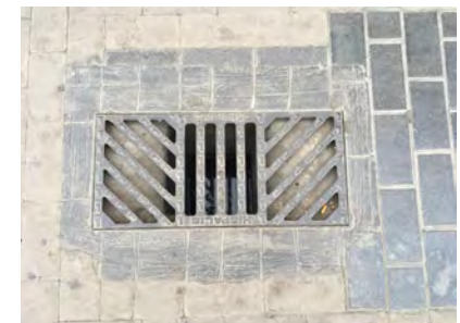
IMAGEN 15. La abertura de los huecos de rejilla es de hasta 0,04m
