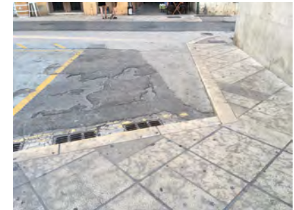
IMAGEN 1. La acera que conecta la plaza Décimo Junio Bruto con la calle Almodín se reduce a 1,35m
