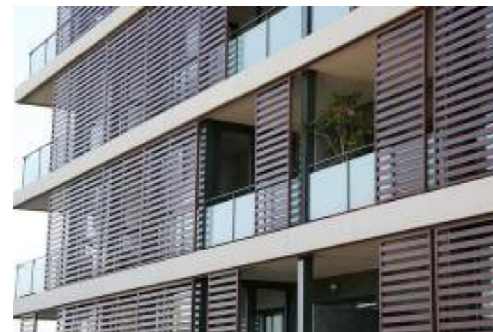
Ejemplo protección lamas de madera.
