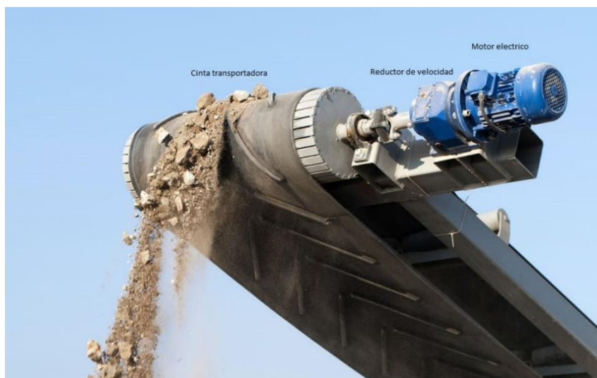
Fig. 2. Detalle del conjunto motor-reductor-cinta.
