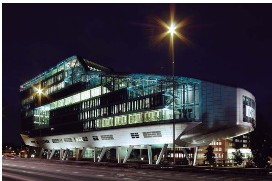
Figura 44. Exterior de la sede central del Banco ING. Página Oficial: MVSA ARCHITECTS. ING. < http://www.mvsa-architects.com/project/detail/4/ing-house > [Consulta: 8 de Diciembre del 2016].
