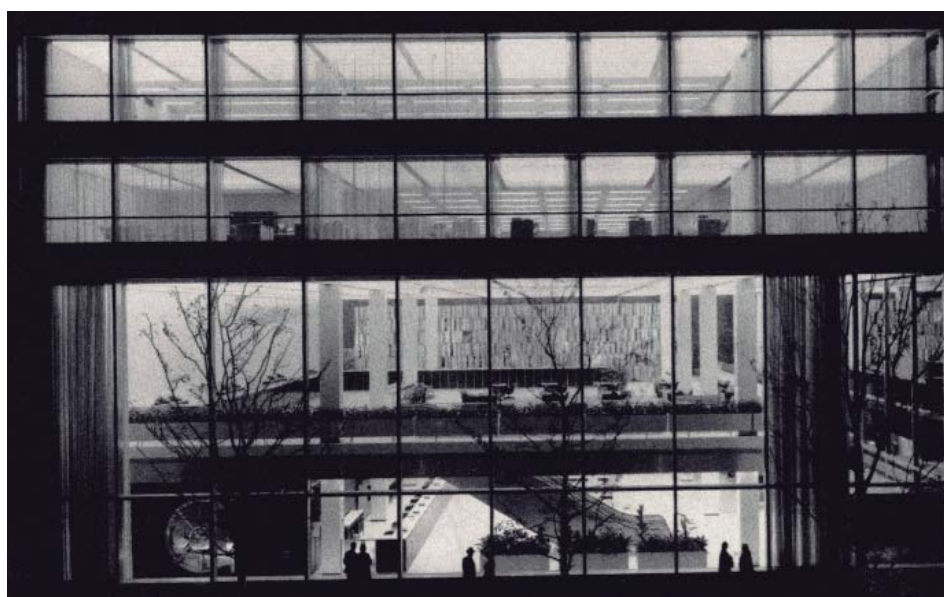
Figura 16. Fachada principal del Banco Manufacturero Hanover Trust Company. Nueva York-E. E. U. U. 1954 Arquitectos Skidmore, Owing y Merrill. Libro: Pevsner, N. (1979). Historia de las tipologías arquitectónicas . Editorial Gustavo Gili: Barcelona. Pág.256.
