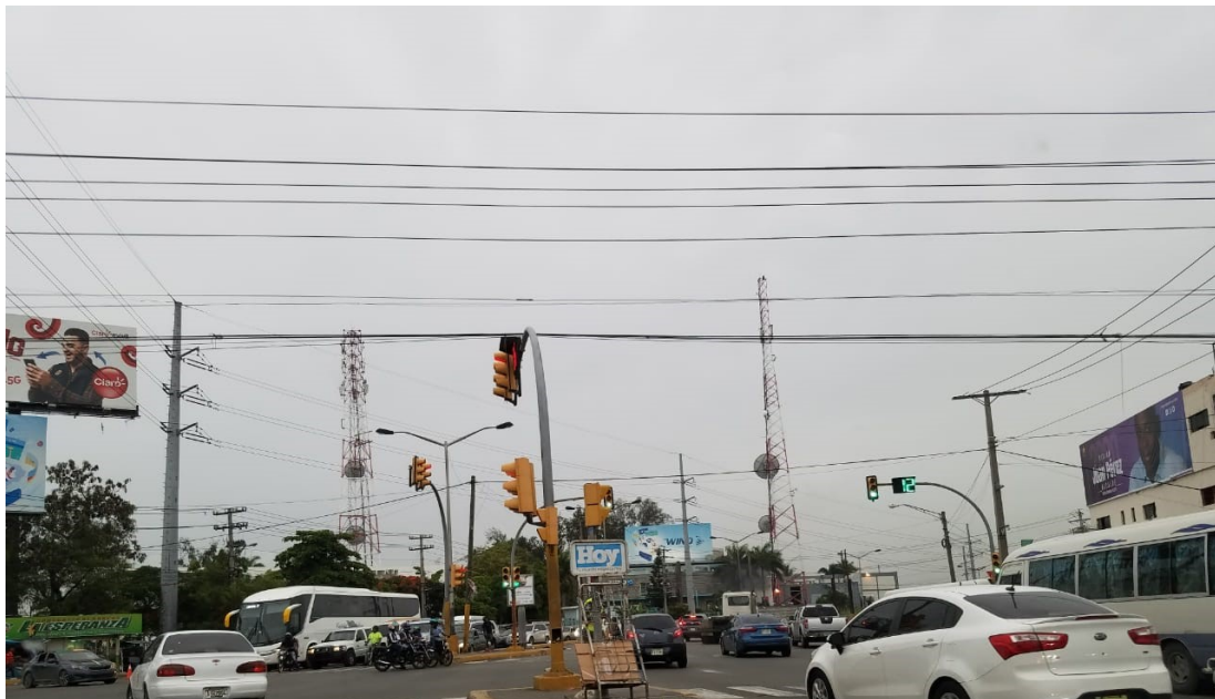
Figura 34. Problema existente en la intersección. Vista del acceso 2.
