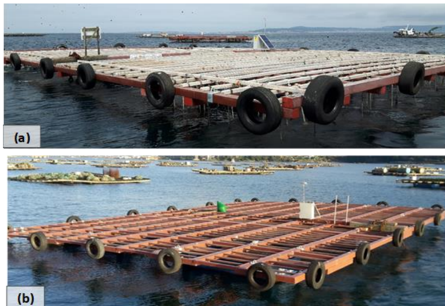
Figura 4.49. Imagen general de la BFM (a) y la BFP (b) instaladas en sus respectivos polígonos marinos con el sistema INESSCOM en funcionamiento.
