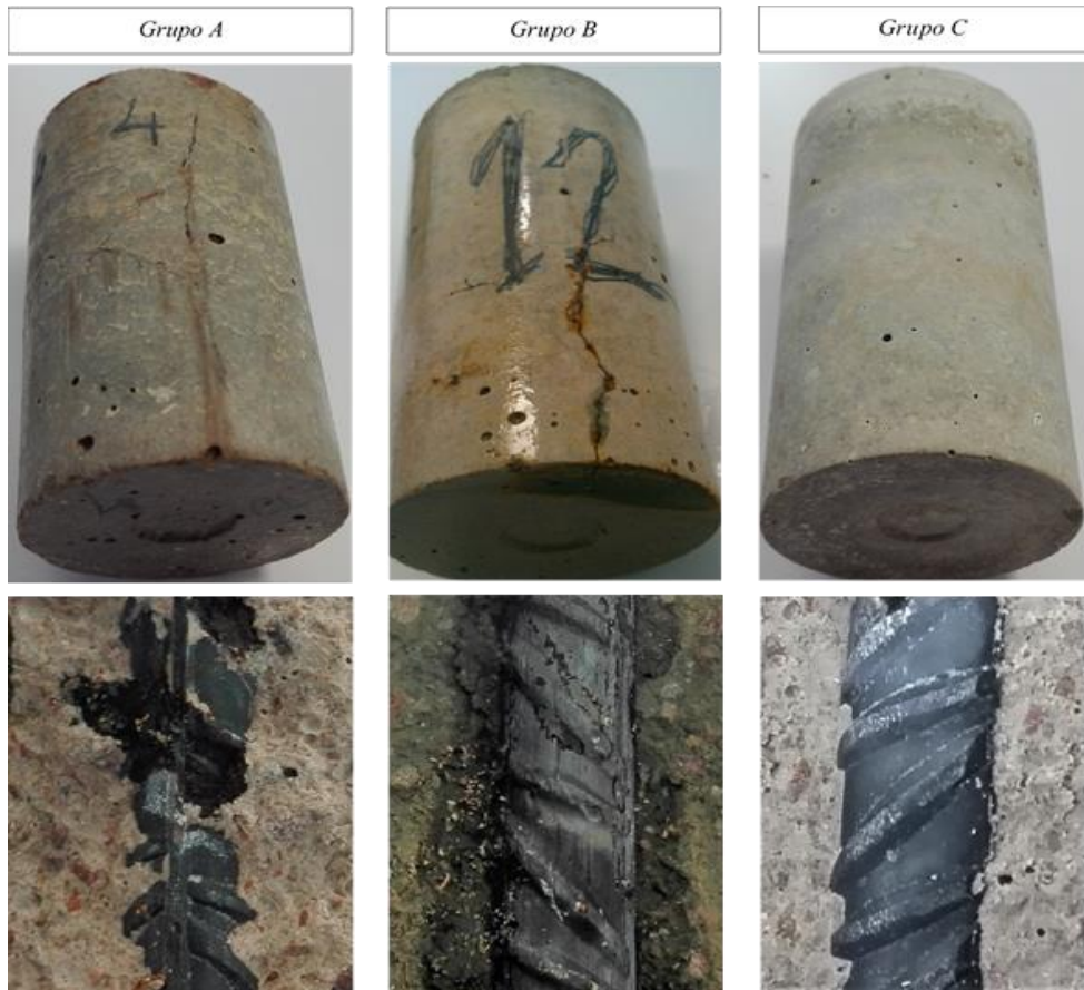
Figura 3.24. Testimonio gráfico de la inspección visual realizada sobre probetas de cada uno de los grupos estudiados (A, B y C). Inicialmente, se realiza una exploración en busca de signos de corrosión externos (imágenes superiores) y posteriormente se rompen las muestras para observar el estado de la superficie metálica de la armadura embebida (imágenes inferiores).
