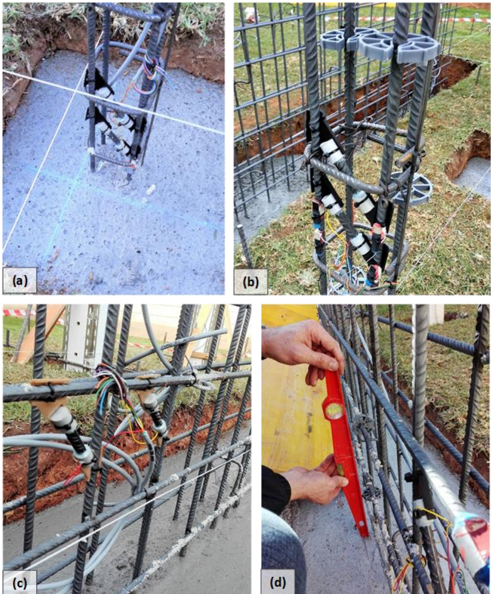
Figura 4.39. Fijación de los sensores a las armaduras de los pilares (a y b) y del muro (c) antes del encofrado (d).
