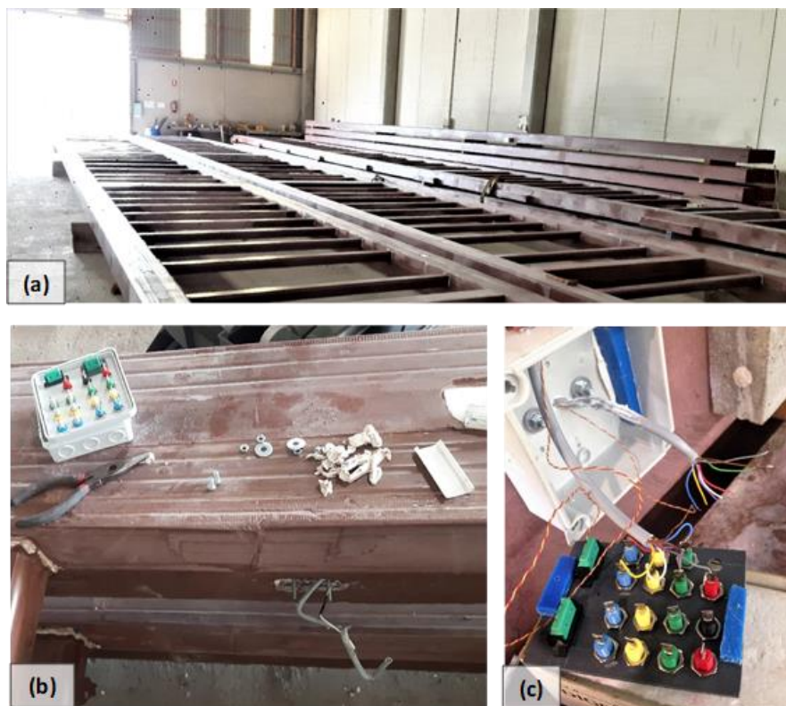
Figura 4.53. Acopio de las vigas de las bateas una vez desmoldadas (a) e instalación de la caja de conexiones en cada CP (b y c).
