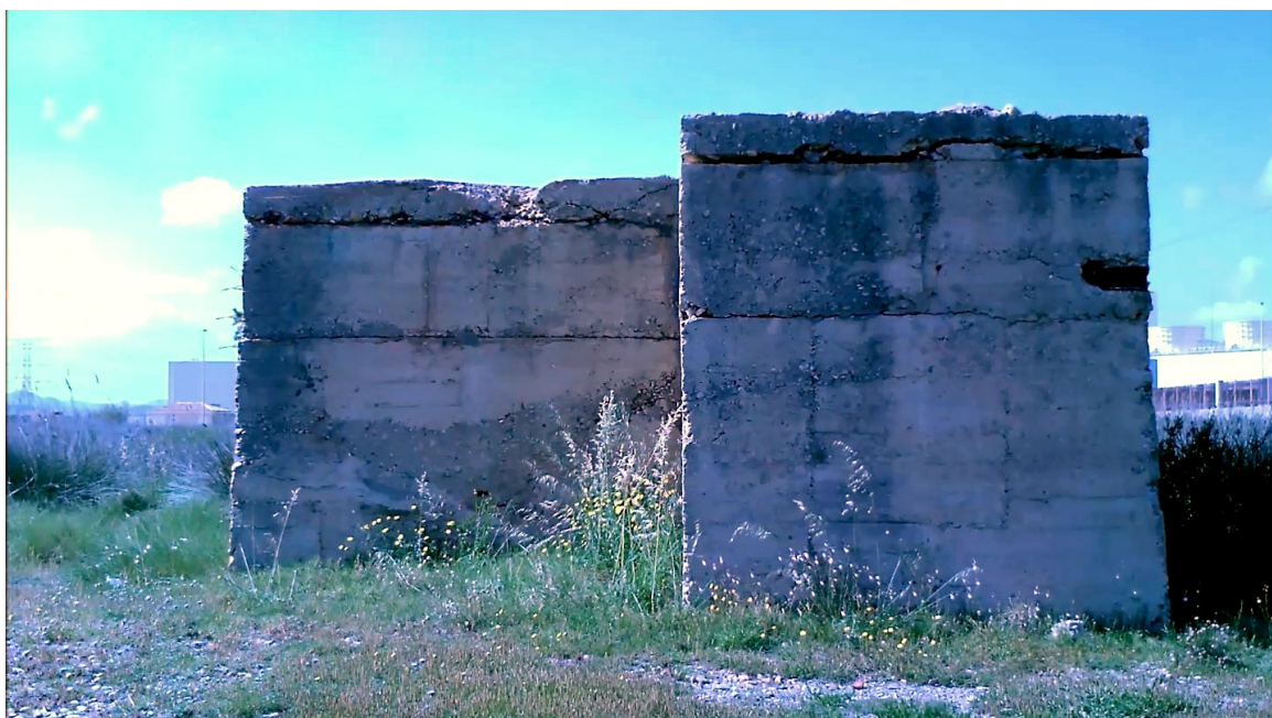
Búnker-refugio de la batería de costa del Grau Vell . 350
