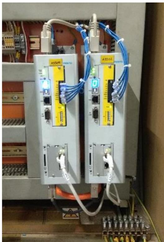
Ilustración 46. Instalación de las controladoras de motor, tanto del movimiento subida/bajada como giro en el armario eléctrico.
