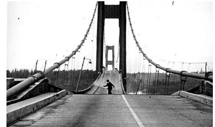
Figura 1. Colapso del puente de Tacoma.
