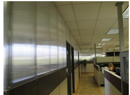
Ilustración 66.- Revestimiento Interior de policarbonato alveolar.
