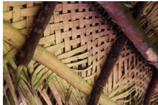
Ilustración 10. Utilización de la paja toquilla en Cubiertas
