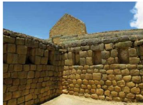
Ilustración 3.- Construcción en Piedra.
