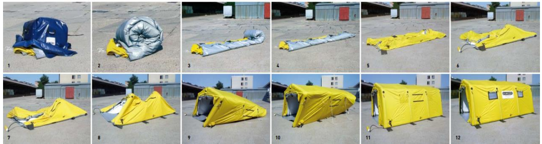
Ilustración 42. Proceso de Montaje de una Tienda Hinchable.
