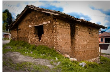
Ilustración 4.- Construcción en Adobe
