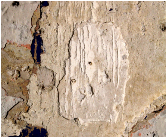
Figura 38. Laguna muro noroeste.
