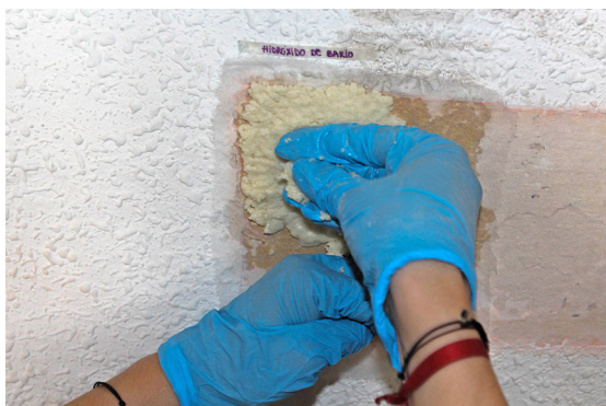
Figura 40. Aplicación empaco hidróxido de bario.
