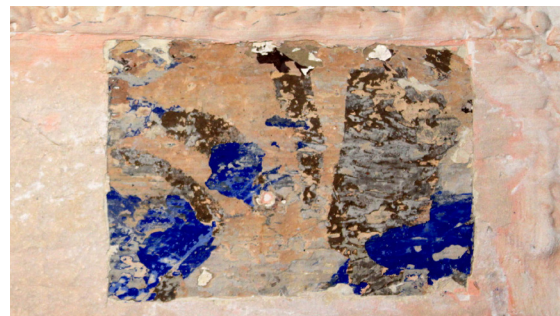
Figura 69. Preconsolidación con silicato de potasio.
