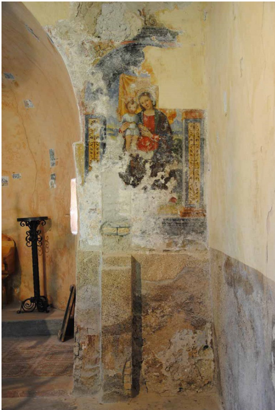
Figura 12. Catas realizadas en las pinturas murales al fresco encaladas de Iglesia de San Bernardo di Faedo, Faedo.
