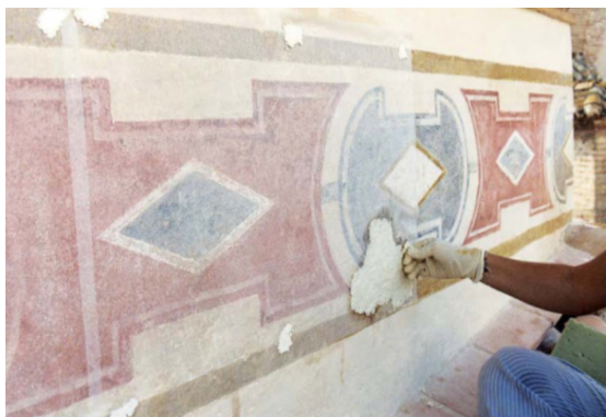
Figura 16. Consolidación con hidróxido de bario de las pinturas murales al fresco de la iglesia de San Roque de Oliva, Valencia.
