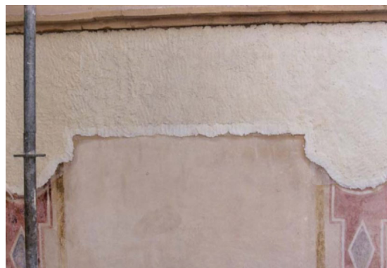
Figura 17. Consolidación con hidróxido de bario de las pinturas murales al fresco de la iglesia de San Roque de Oliva, Valencia.
