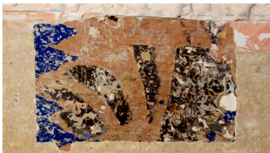
Figura 59. Preconsolidación con silicato de etilo.
