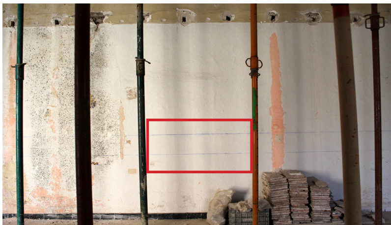
Figura 36. Área muro noroeste seleccionada para la apertura de catas y aplicación de consolidantes.
