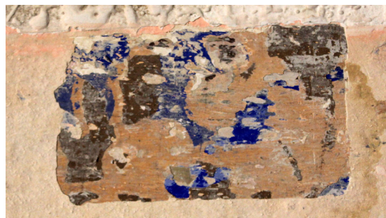
Figura 58. Preconsolidación con hidróxido de bario.
