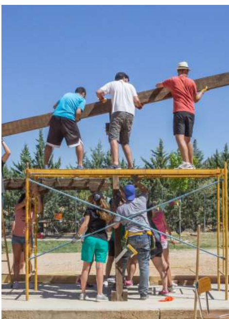
Imagen 44 / I Colocación de la viga III FWF 2015 / Fuente: Elaboración propia
