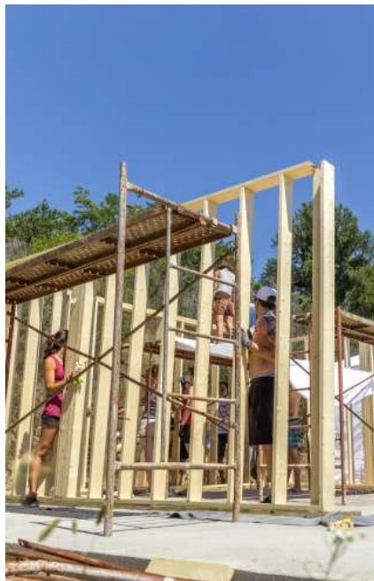
Imagen 47 / Estructura de la caseta IV FWF 2017 / Fuente: Elaboración propia
