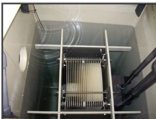
Figura 20. Disposición del Módulo de membranas BC10-10.
