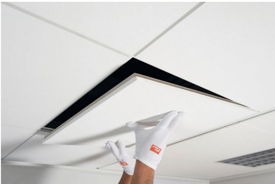
Ilustración 25: Techo falso para pasar cableado.
