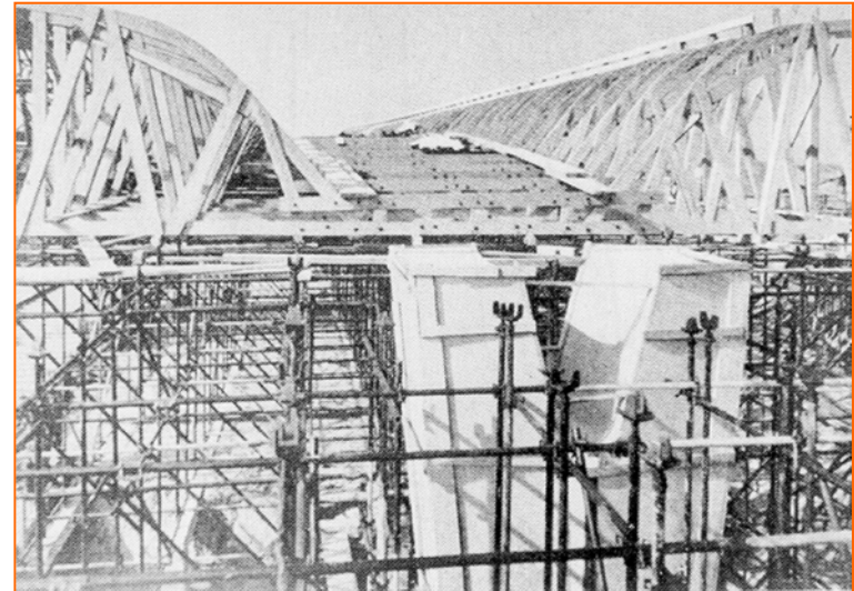
Andamiaje metálico y encofrado de madera
