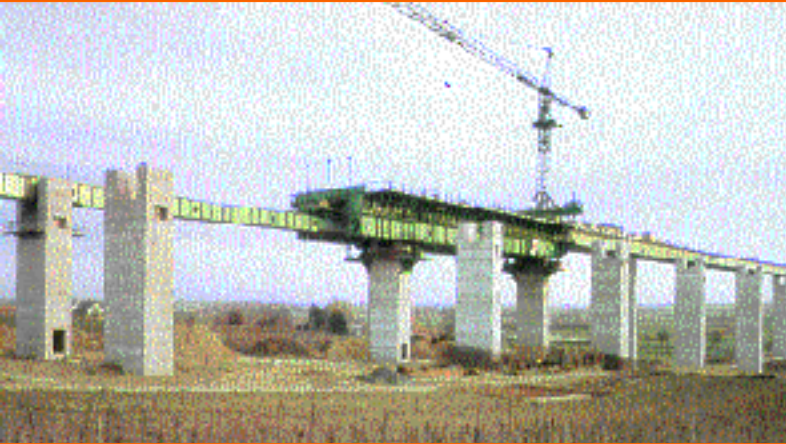
▪ Viaducto de Pfeddersheim , vanos de 45 y 50 m (Alemania, 1962. H. Wittfoht. Polensky & Zöllner)
