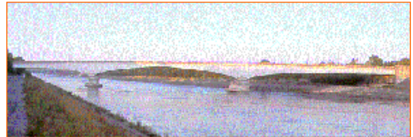
(2) Puente sobre el canal de Donzère-Mondragon. 1950. Vanos de 79.5+100+79.5 m. A. Caquot (HA)
