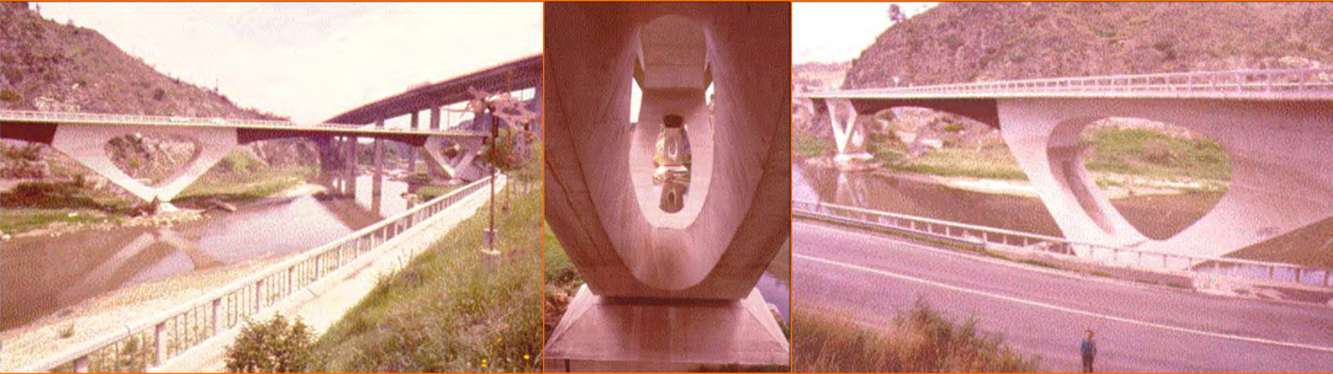
▪ Nou pont del Diable , sobre el río Llobregat en Martorell (1974, 100 m)
