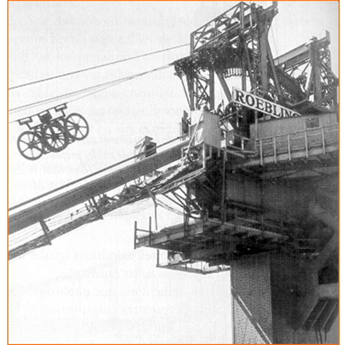
2) Paso de las poleas móviles por las sillas de las torres
