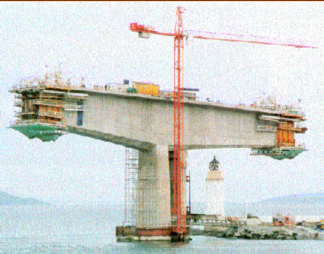
(a.1) Los carros móviles, ejemplo de carro tradicional: carros móviles del Skye bridge , construidos por PERI (Escocia, 1995, 250 m de luz. Miller-Dywidag)
