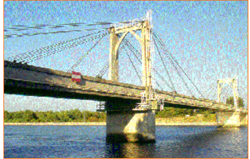
▪ Puente sobre el canal Donzère-Mondragon (A. Caquot, 1952, 81 m de luz, HA)
