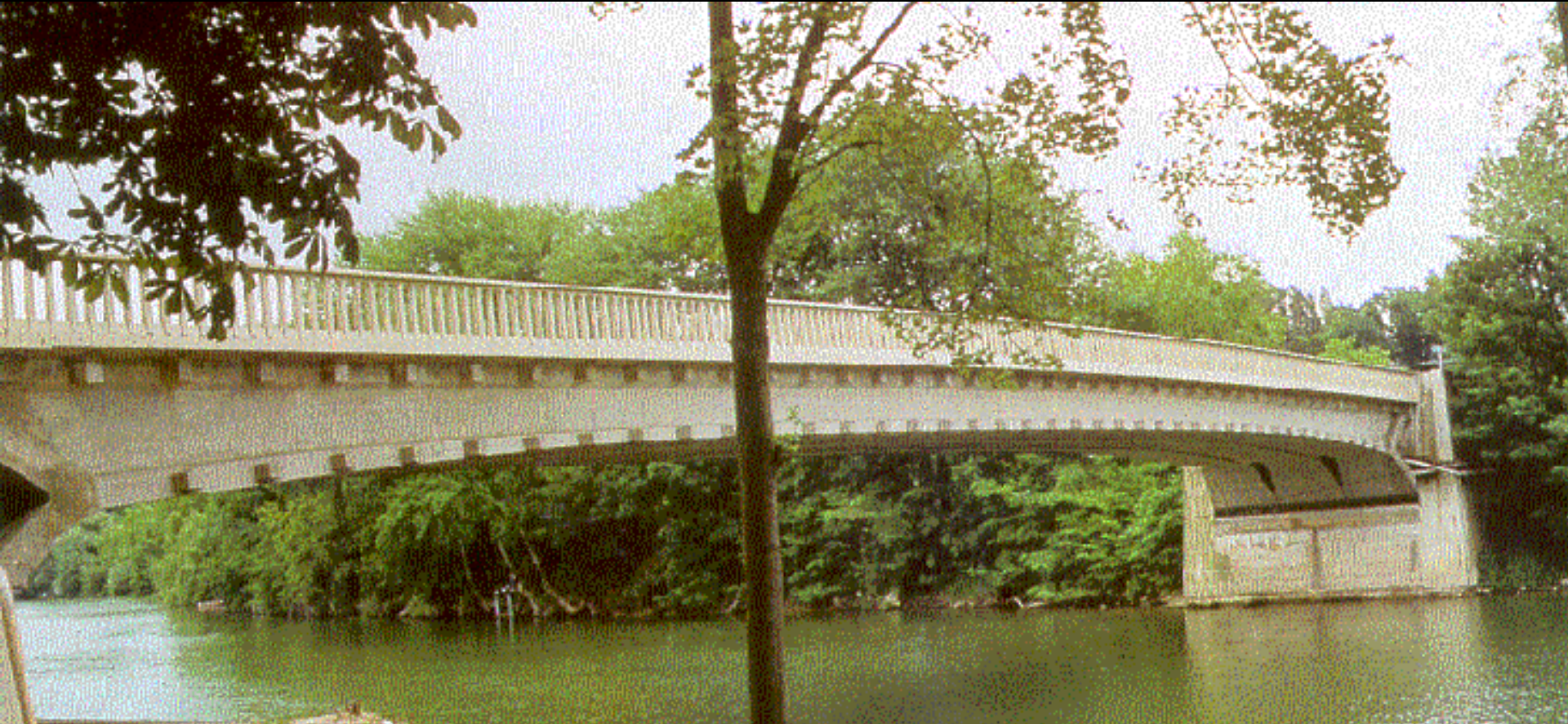
▪ El pont de Luzancy sobre el Marne (1941-1946, 55 m, E. Freyssinet)
