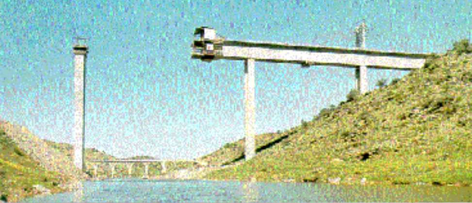
▪ Puente de Alconectar sobre el río Tajo, para carretera y ferrocarril (1967, luces de hasta 85 m. Dyckerhoff & Widmann)
