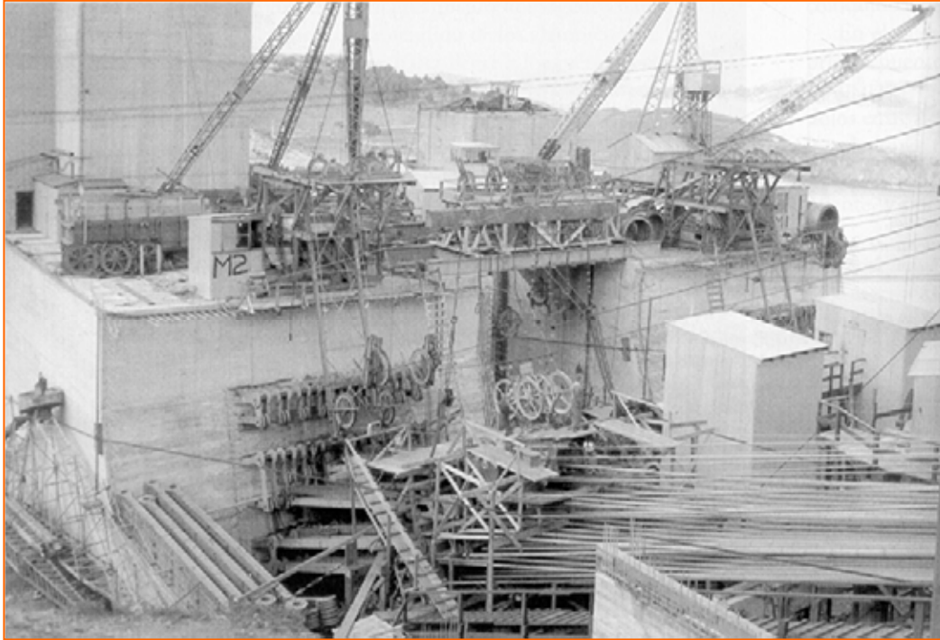
1) Macizo de anclaje e instalaciones de devanado hilo a hilo
