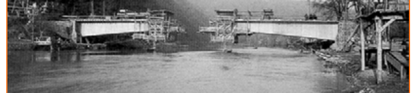
(4) Puente de Balduinstein. 1950. Un vano de 62 m. U. Finsterwalder (HP)
