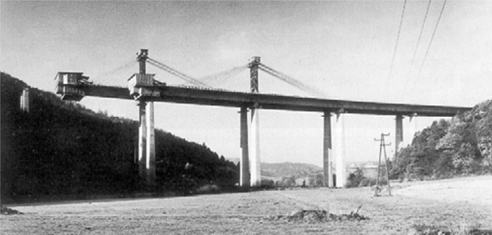
▪ Viaducto de Ambachtal (1968, luces de 68 m. Dyckerhoff & Widmann y Wayss & Freytag)
