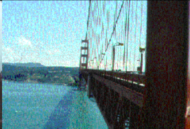
▪ Vista oblicua de la viga de rigidez
