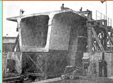
■Célula horizontal del Pont Aval en París
