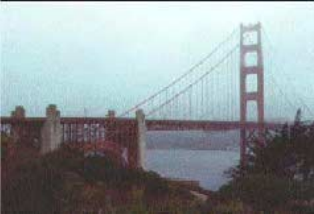
▪ Acceso al Golden Gate desde San Francisco (lado sur, Presidio)
