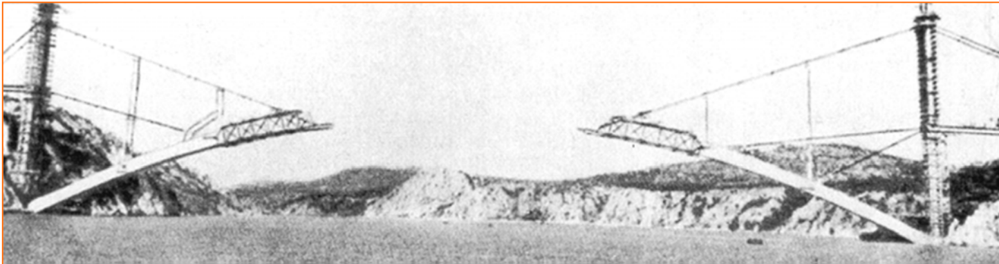
▪ Puente de Shibenik (1966, 246 m, antigua Yugoslavia): voladizos sucesivos atirantados a diferentes alturas
