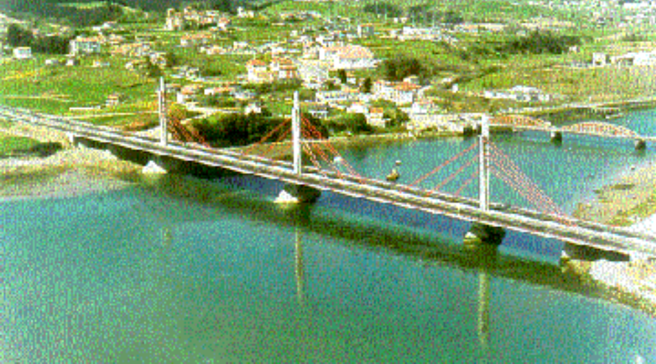
▪ Puente sobre la ría de Colindres , vanos de 50+2\times 125+50 m (1993, Proes)
