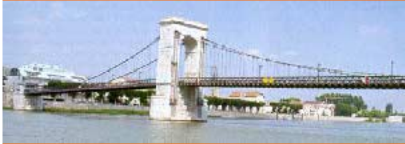
Segundo puente de Tournon-Tain L'Hermitage, sobre el ródano (Seguin, 1847, dos vanos de 89 m)
