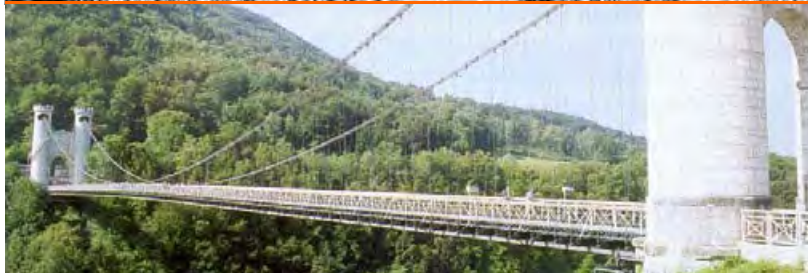
Pont de La Caille , o de Charles Albert sobre el barranco del río Usses (Belin, 1839, 182 m)
