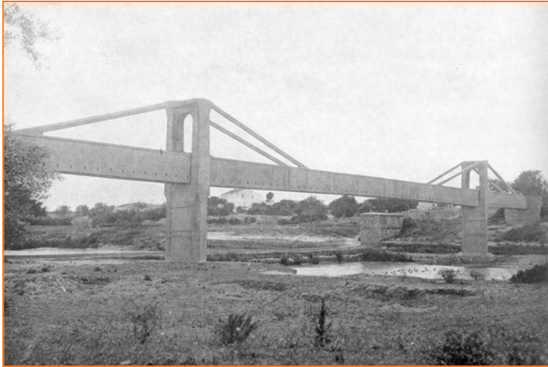
▪ Acueducto de Tempul , sobre el río Guadalete (E. Torroja, 1926, 58 m de luz, HA)
