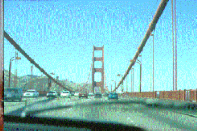
▪ El Golden Gate desde el tablero, vista de los cables y de las péndolas
