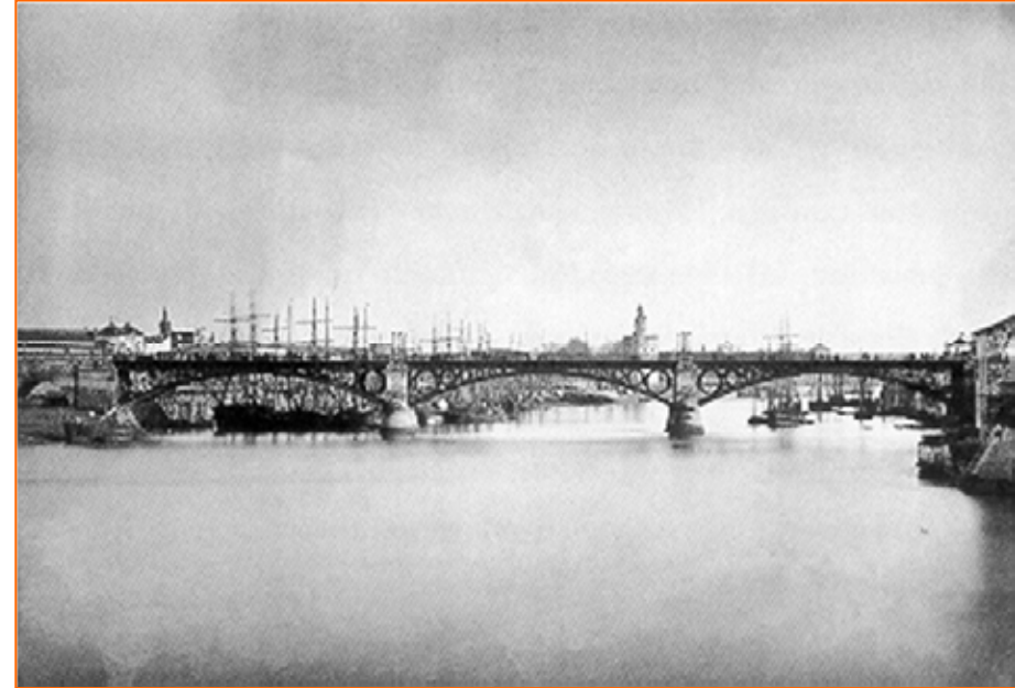
▪ Puente de Isabel II, o de Triana, en 1866 (fotografía de Jean Laurent)
