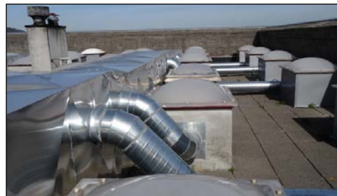
Fig 7. Disposición del sistema de ventilación de formaldehído en la azotea de la Fac. de Medicina.
