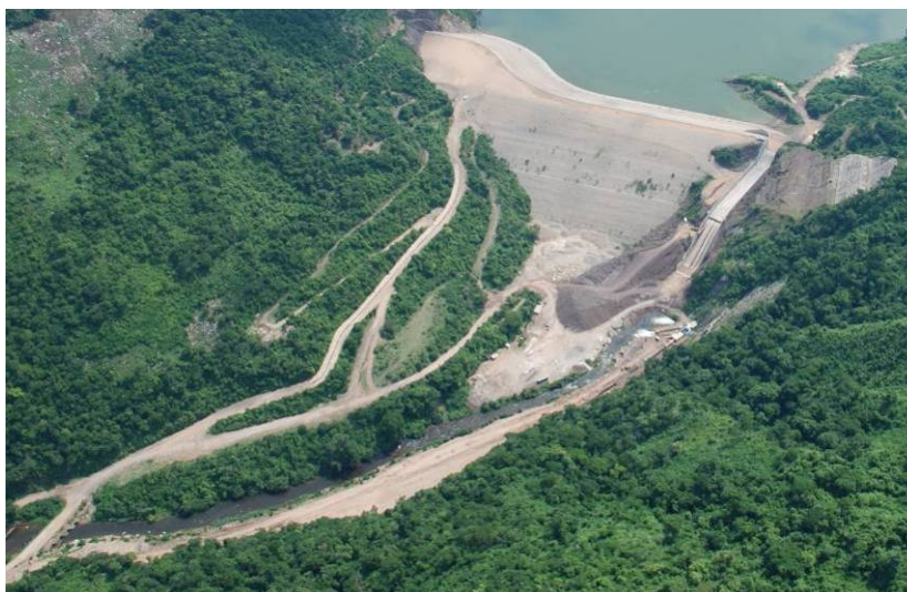
Figura 5.13. Vista aérea de la Presa y sus accesos
