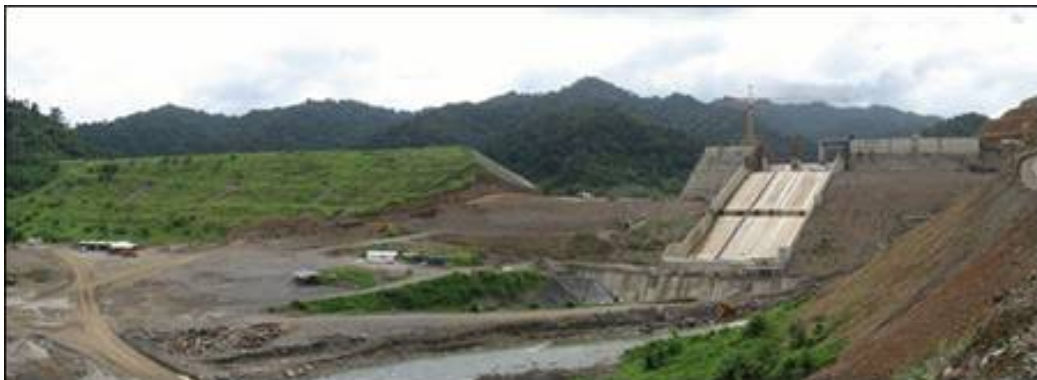
Figura 3.11. Vista de la presa El Guapo en proceso de reconstrucción
