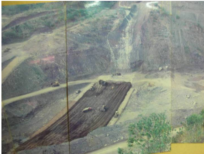
Figura 5.5. Fotografía tomada en los inicios de la construcción.
