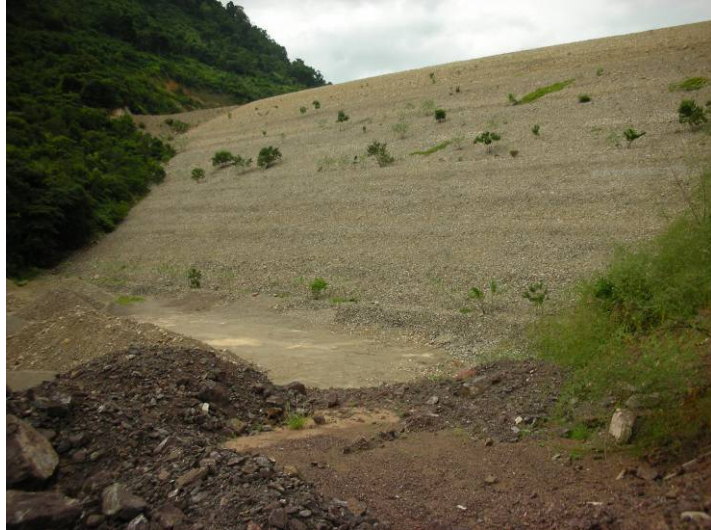
Figura 5.16. Aspecto del espaldón de aguas abajo
