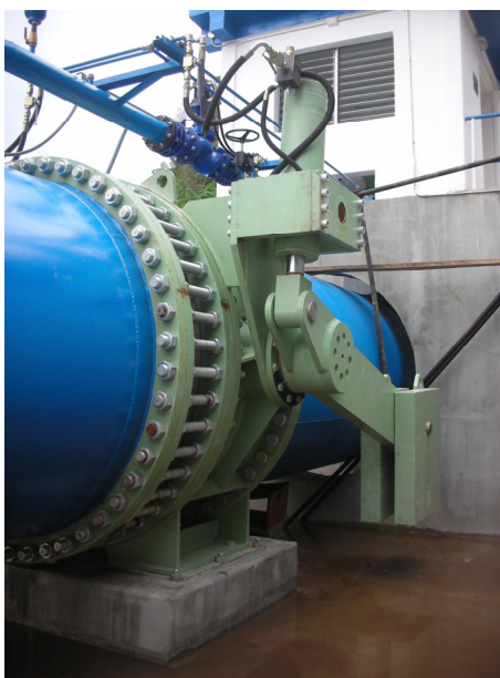
Figura 5.72. Válvula de regulación de tipo Mariposa Diámetro = 2,0 metros
