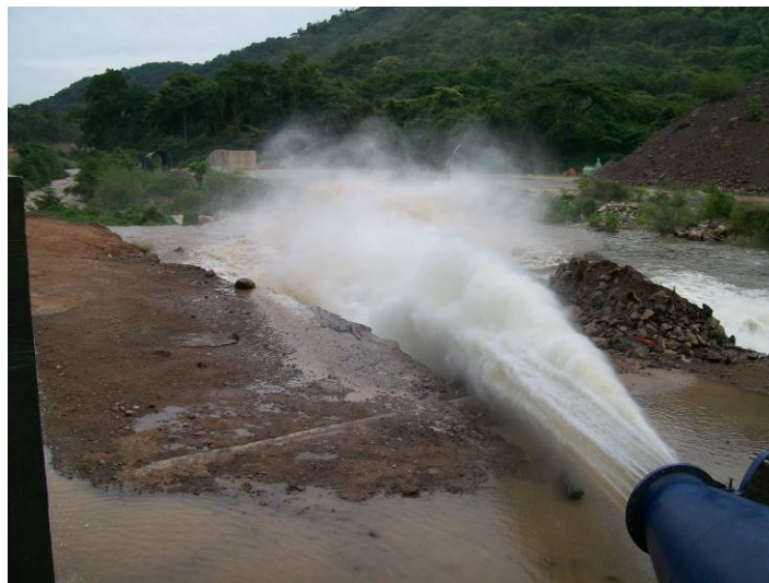
Figura 5.11. Descarga Adicional en operación
