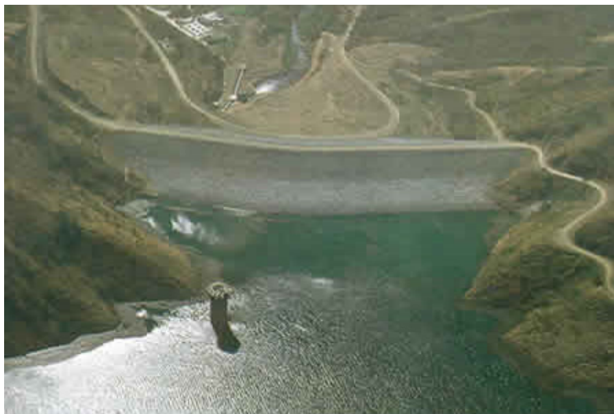
Figura 3.5. Presa de Camatagua, acueducto metropolitano.
