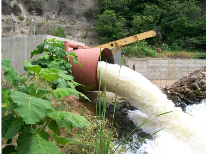
Figura 5.63. Salida de la tubería de descarga de emergencia
