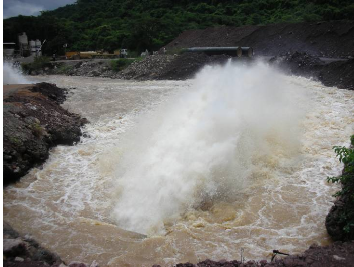
Figura 5.62. Descarga de fondo en condiciones actuales
