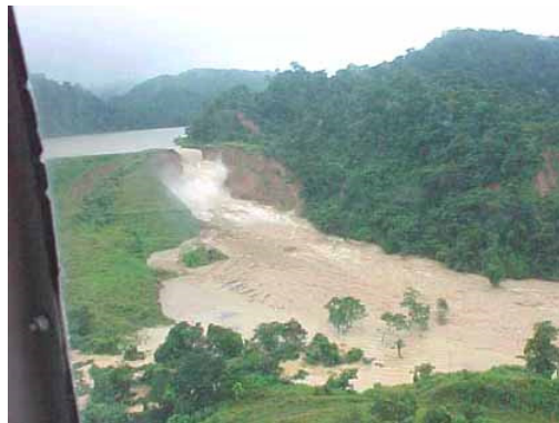
Figura 3.10. Vaciado del embalse a través de la brecha
