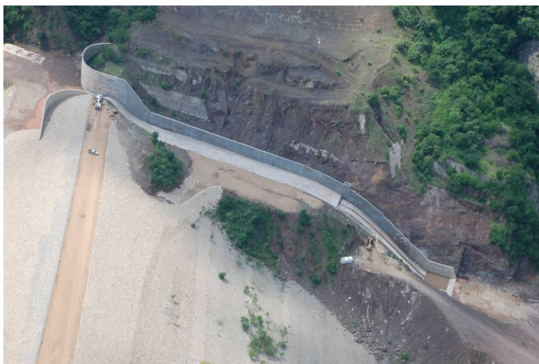
Figura 5.74. Acceso al aliviadero desde la coronación
