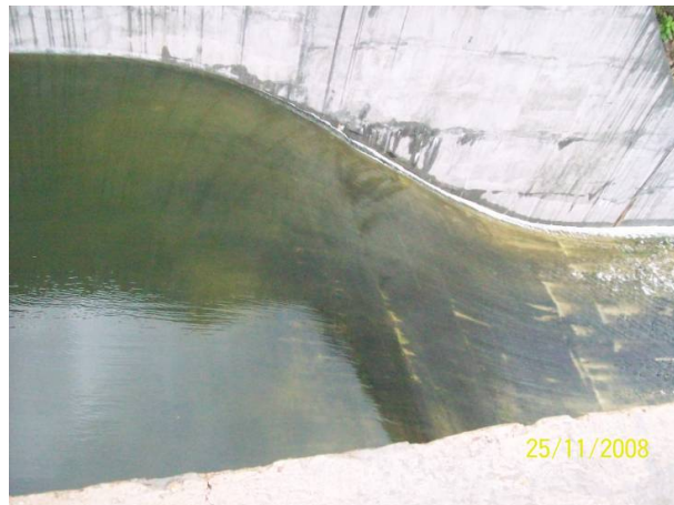
Figura 5.49. Flujo sobre el vertedero
