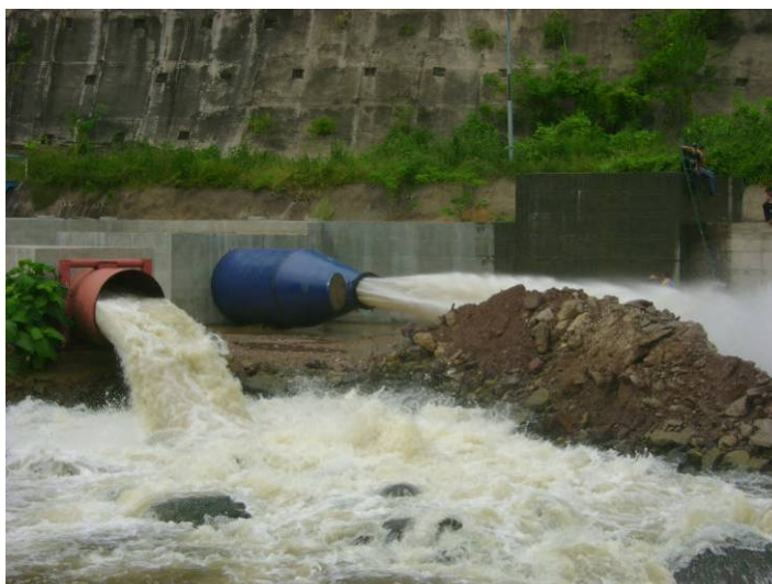
Figura 5.65. Descargas de Emergencia y Adicional, Dic. 2009
