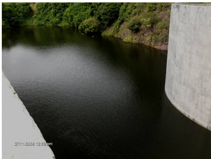
Figura 5.32. Aproximación del flujo a la embocadura
