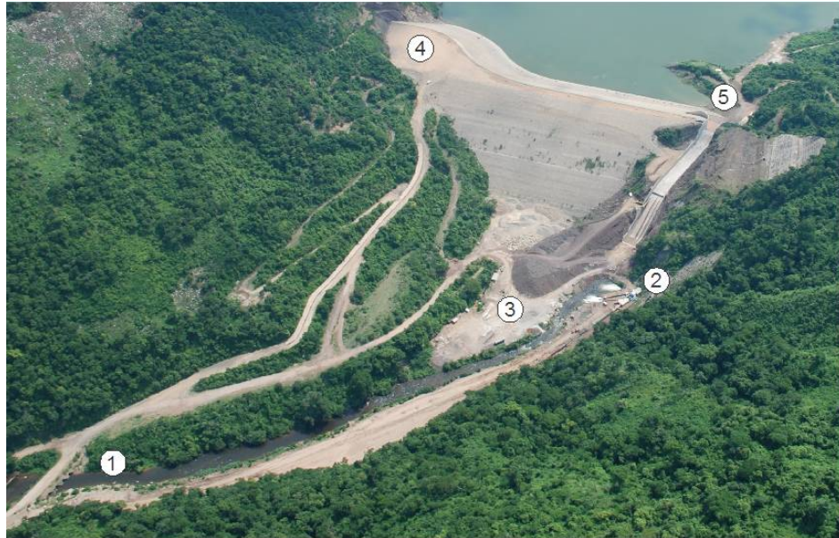
Figura 5.73. Vista aérea de la vialidad
