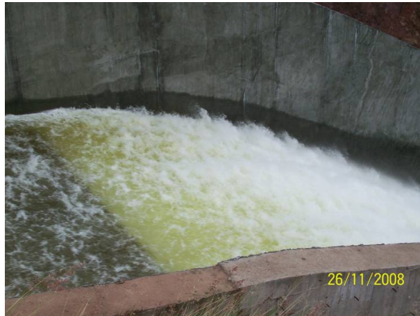
Figura 5.55. Aireador en funcionamiento (MINAMB, Nov. 2008)
