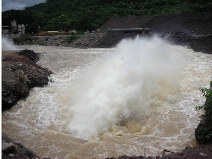
Figura 5.8. Descarga de fondo en condiciones actuales
