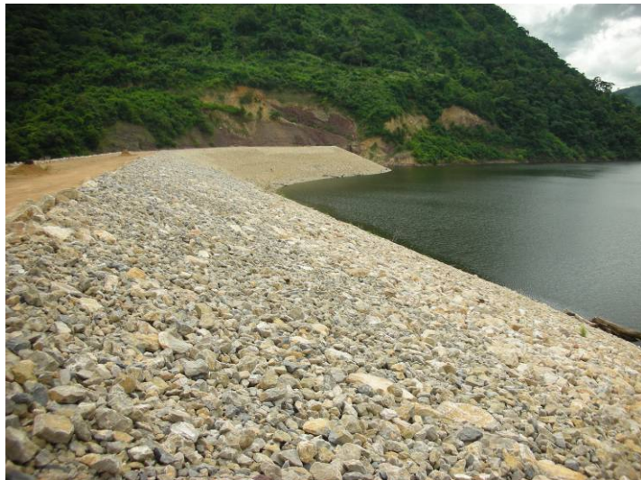
Figura 5.17. Aspecto del espaldón de aguas arriba.
