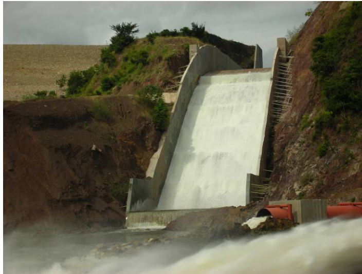
Figura 5.22. Vista frontal del aliviadero
