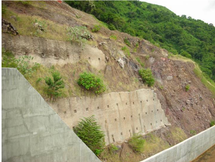
Figura 5.14. Aspecto del estribo izquierdo.
