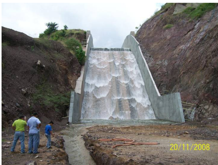
Figura 5.66. Estanque disipador al inicio del alivio
