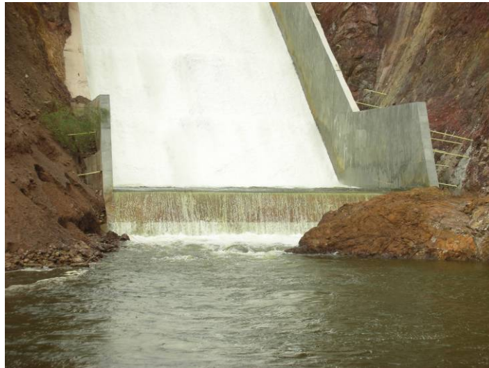
Figura 5.68. Estado final del estanque disipador
