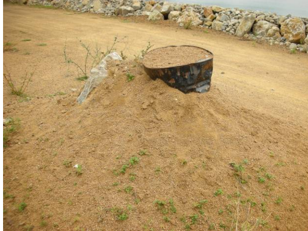
Figura 5.18. Protección de los cables de piezómetros
