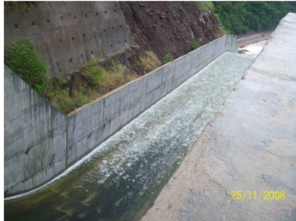
Figura 5.50. Canal de baja pendiente (MINAMB, Nov. 2008)
