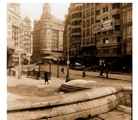
Figura 79. Fotografía del remate de la fuente principal.
