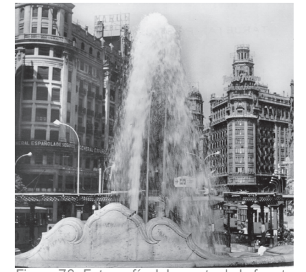
Figura 78. Fotografía del remate de la fuente principal.
