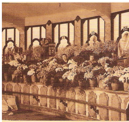
Figura 21. Puestos de las floristas en el sótano de la obra.
