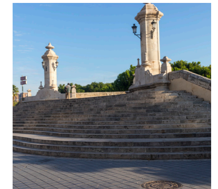
Figura 54. Fotografía del puente del mar, Valencia. 2018
