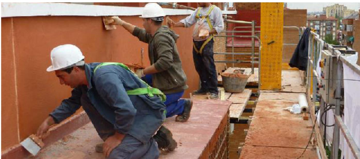
Figura 6.2- Mantenimiento de muro.
