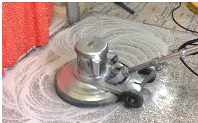
Figura 5.21- Tratado de piso. Pulido con máquina.
