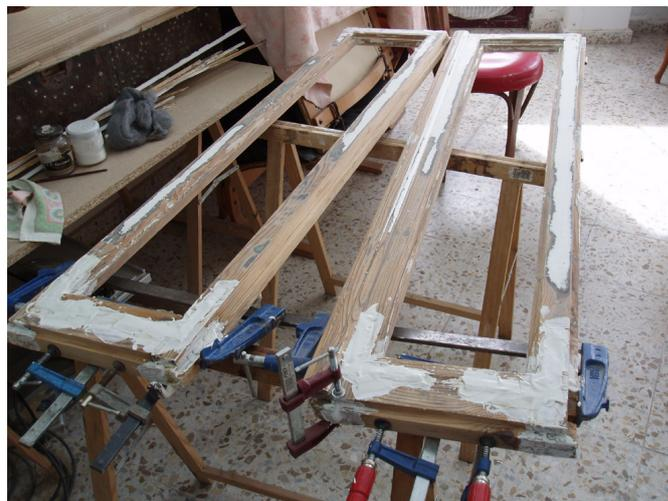
Figura 5.18- Ejemplo masillado en elementos de madera.
