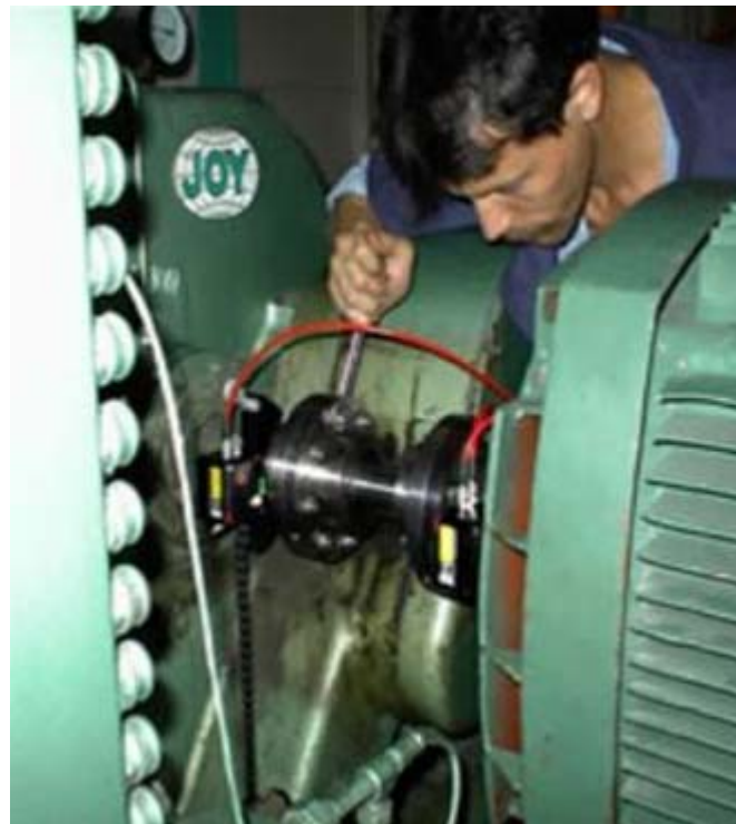
Figura 47: Detalle de una operación de mantenimiento
