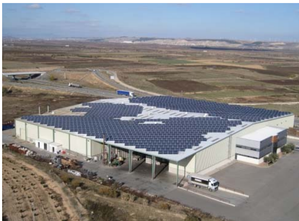
Figura 31: Naves industriales de la fabrica de mecanizado
