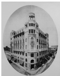
Edificio Baquero. CCSD.1928. Hormigón Armado. Fuente AGN.
