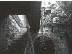
4. ESCALERA PATIO INTERIOR
