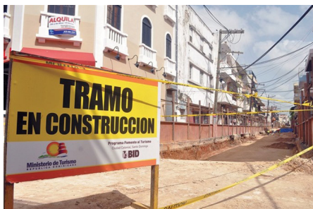
Construcciones en la CCSD. Fuente - Listín Diario.
