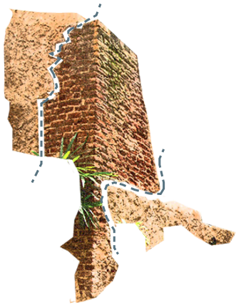
Algunos muros de tapia del inmueble estaban "reforzados" con ladrillo en varios puntos. Fuente Propia.
