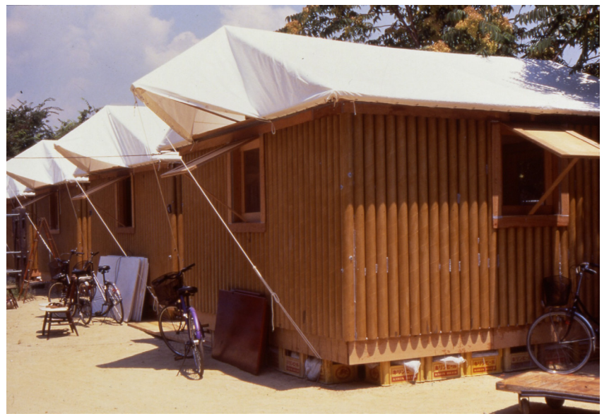
[Fig.30] Casas de Tubos de cartón - Kobe, Japón, 1995
