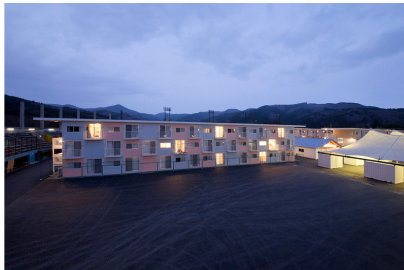
[Fig.32] Barrio de vivienda temporal construido con contenedores de barco. Onagawa. Japón.
