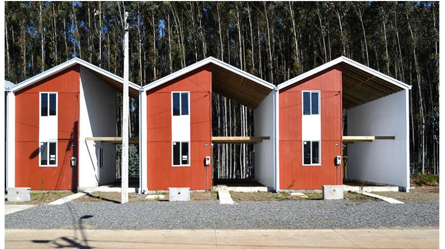
[Fig.37] Imagen de viviendas de reconstrucción en Constitución, Chile.
