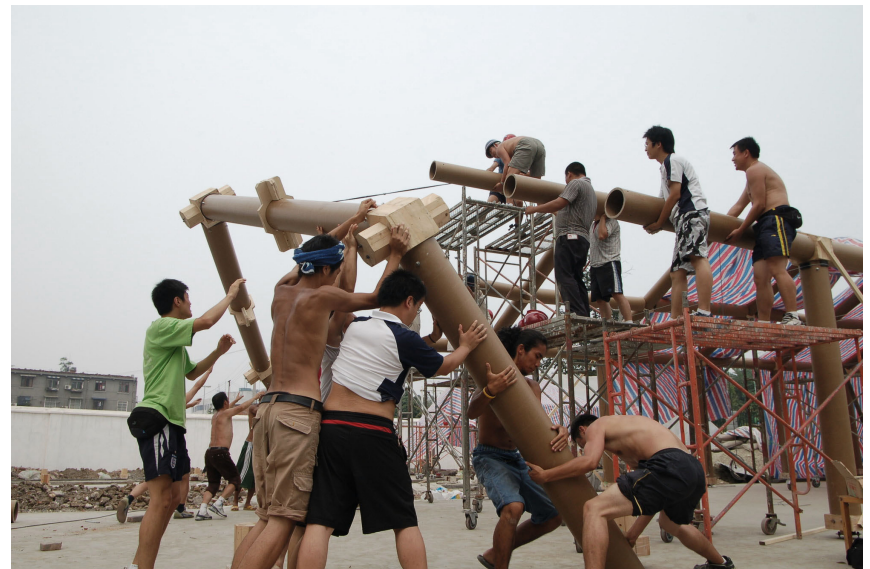
[Fig.20] Construcción de Escuela temporal Huailin.
