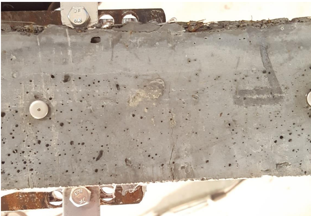
Fig 95.- Fisuras producidas en el ensayo realizado. (Fuente Propia)
