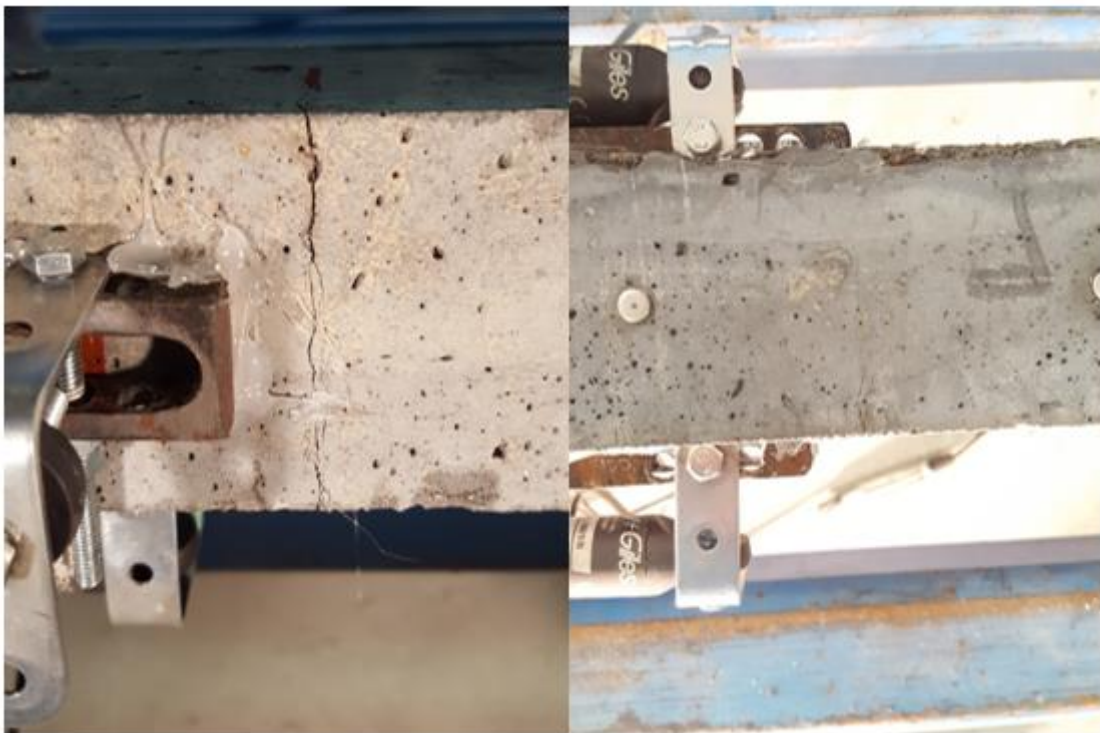
Fig 57.- Fisuras producidas en el ensayo. (Fuente Propia)
