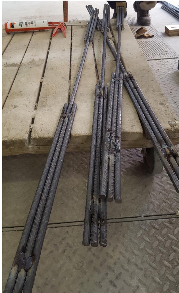
Fig 63.- Refuerzos dispuestos a la varilla de refuerzo del tirante. (Fuente Propia)
