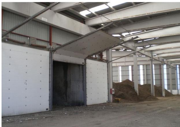
Figura 40. Sistema cerrado de compostaje en túneles. Fuente: maestrocompostador.es
