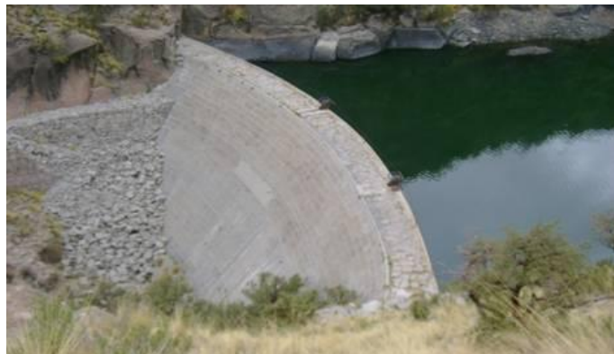
Figura 7: Presa arco-gravedad Cayara en el municipio de Yocalla, Potosí. Fuente: google imágenes.
