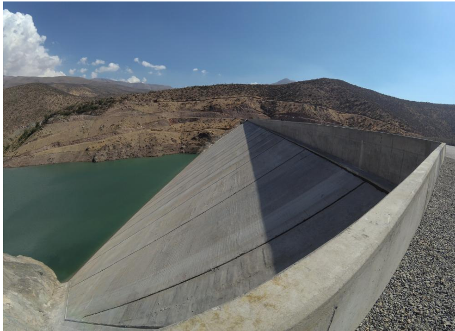
Figura 25: Fotografía del material que conforma el talud de aguas arriba. Fuente: fotografías realizadas durante la visita.
