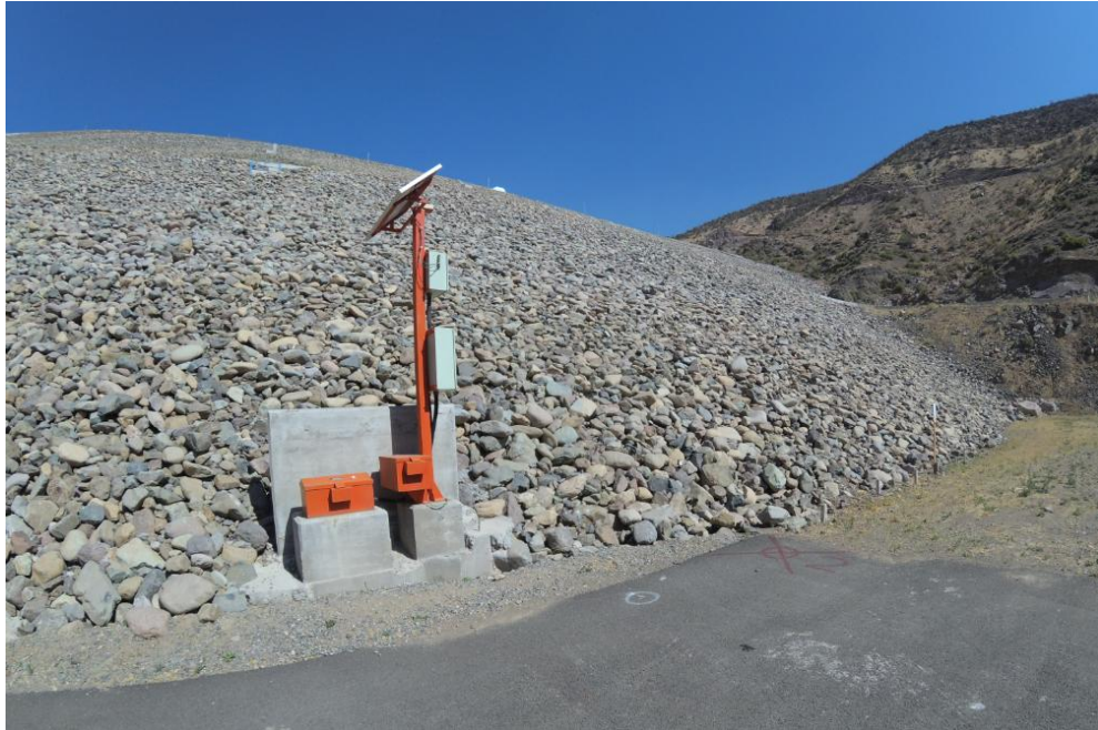
Figura 24: Fotografía del material que conforma el talud de aguas abajo. Fuente: fotografías realizadas durante la visita.
