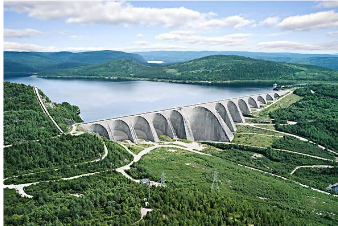
Figura 6: Presa Hidroeléctrica de Bóvedas Múltiples en Quebec, Canadá. Fuente: google imágenes.
