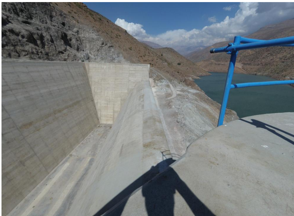
Figura 26: Fotografía evacuador de crecidas (1). Fuente: fotografías realizadas durante la visita.
