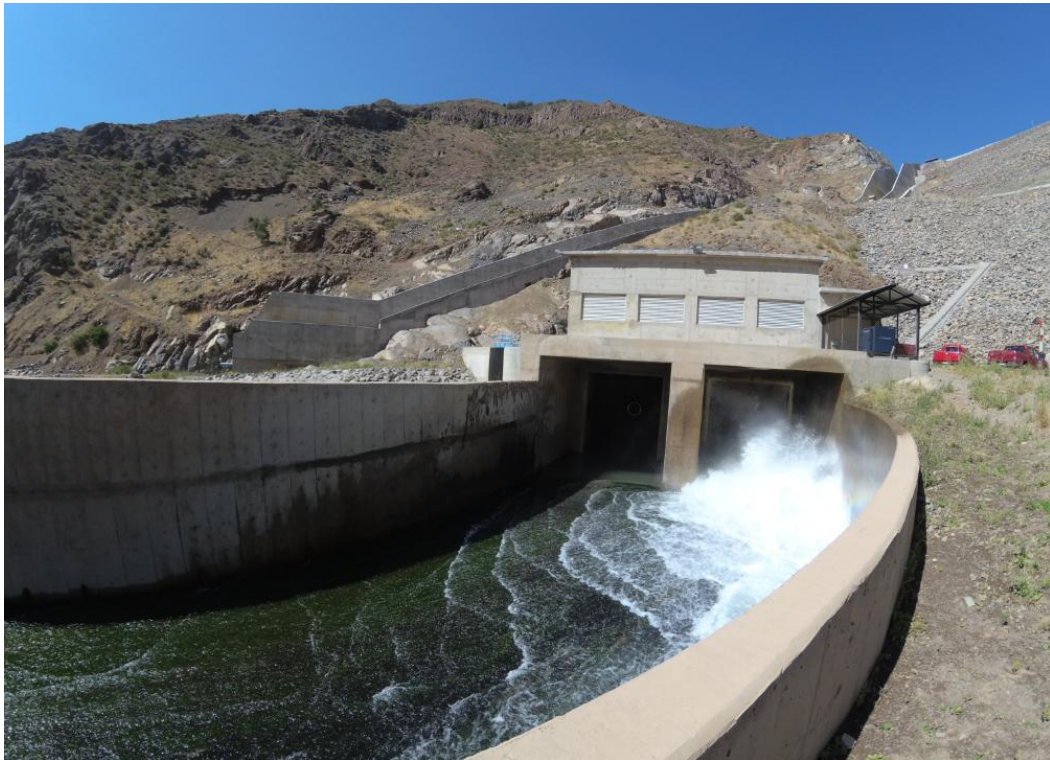
Figura 29: Fotografía túnel de desvío (2). Fuente: fotografías realizadas durante la visita.
