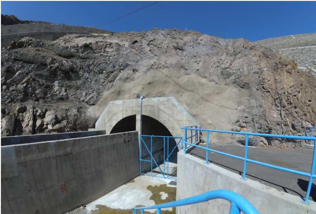
Figura 28: Fotografía túnel de desvío (1). Fuente: fotografías realizadas durante la visita.
