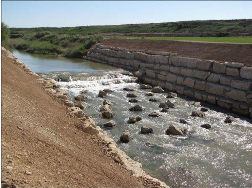
Figura 120. Ejemplo de disipador de energía natural. Fuente: CHEBRO
