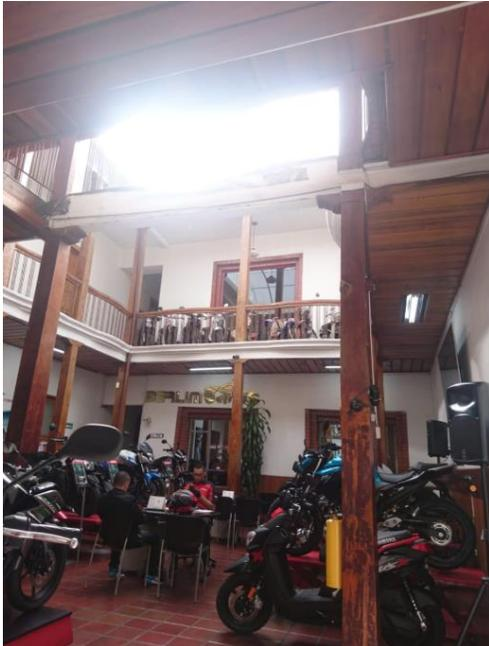
Figura 47 Sobre cargas causados por motos en entrepiso de segunda planta, Berlimotos, Carrera 28 No 18-45. Foto tomada por el autor.
