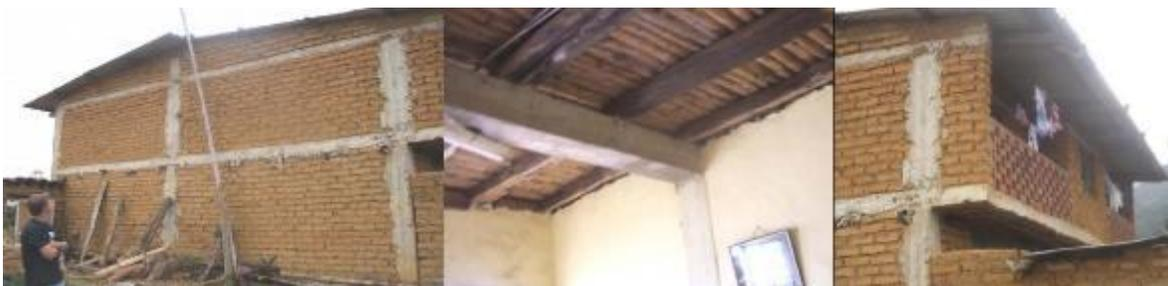
Figura 24 Sistema de confinamiento mediante vigas y columnas de concreto reforzado- Morropón, Piura. FUENTE: (San Bartolomé Ramos, 2014).
