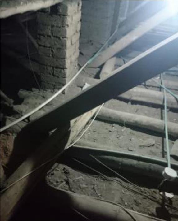
*Figura 76 Par apoyado directamente sobre el tirante, Cubierta, Casa Zarama. Foto tomada por el autor.*
