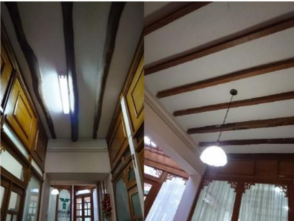
*Figura 67 Sistema de entepiso con viga rolliza, Primera planta, Casa Zarama. Foto tomada por el autor.*
