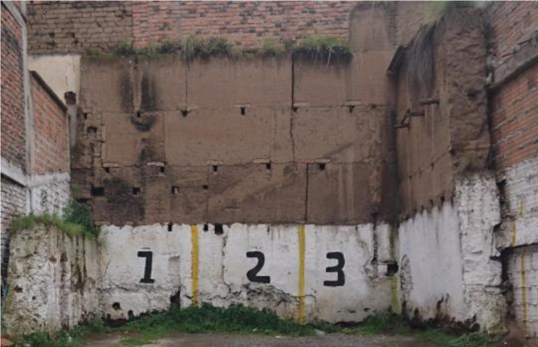
Figura 52 Muro de tapia, grieta vertical bajo junta del bloque superior, Parqueadero Calle 17 No 28. Foto tomada por el autor.
