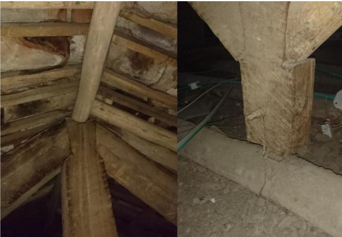
Figura 75 Unión en boca de pescado: pendolón -cumbreira; Izquierda. Unión tipo espiga con refuerzo con alambre: pendolón - tirante. Derecha, Cubierta, Casa Zarama. Foto tomada por el autor.
