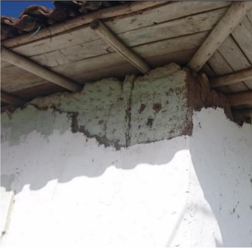
*Figura 64 Picado del muro de tapia. Nariño, Nariño. Foto tomada por el autor.*
