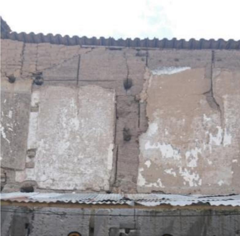
*Figura 54 Refuerzo horizontal con madera rolliza. Parqueadero Carrera 24 No 21. Foto tomada por el autor.*
