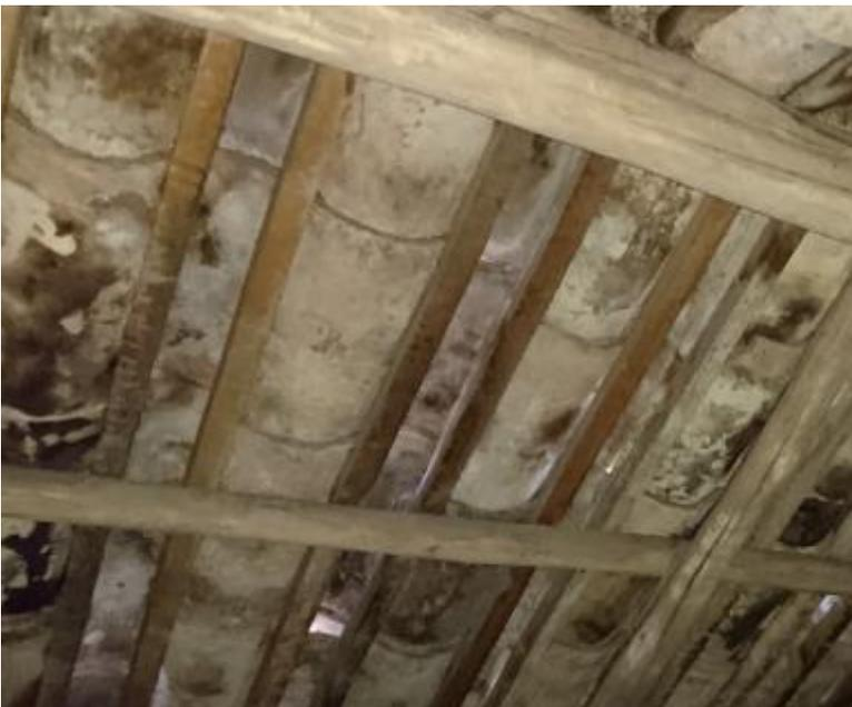
*Figura 81 Separación de los listones dependiendo a la posición de la teja, Cubierta, Casa Zarama. Foto tomada por el autor.*
