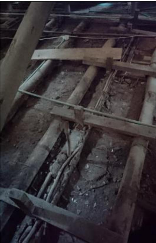
Figura 60 Terminación y anclaje del muro de bahareque con los tirantes. Foto tomada por el autor.
