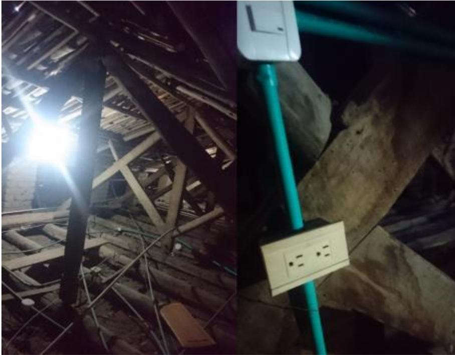
*Figura 89 Instalaciones eléctricas para mantenimiento, soberado (Luces, toma corriente e interruptor), Cubierta, Casa Zarama. Foto tomada por el autor.*
