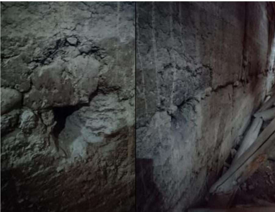
*Figura 51 Disposición de adobe dentro del tapial. Posición cabeza (Izquierda) / Posición parámetro (Derecha). Foto tomada por el autor.*
