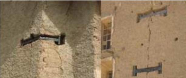
Figura 26 Refuerzo con tensores de madera. Esquina con "llaves", muros con "grapas", Sucre - Bolivia. FUENTE: (Peñaranda Orías, 2011).
