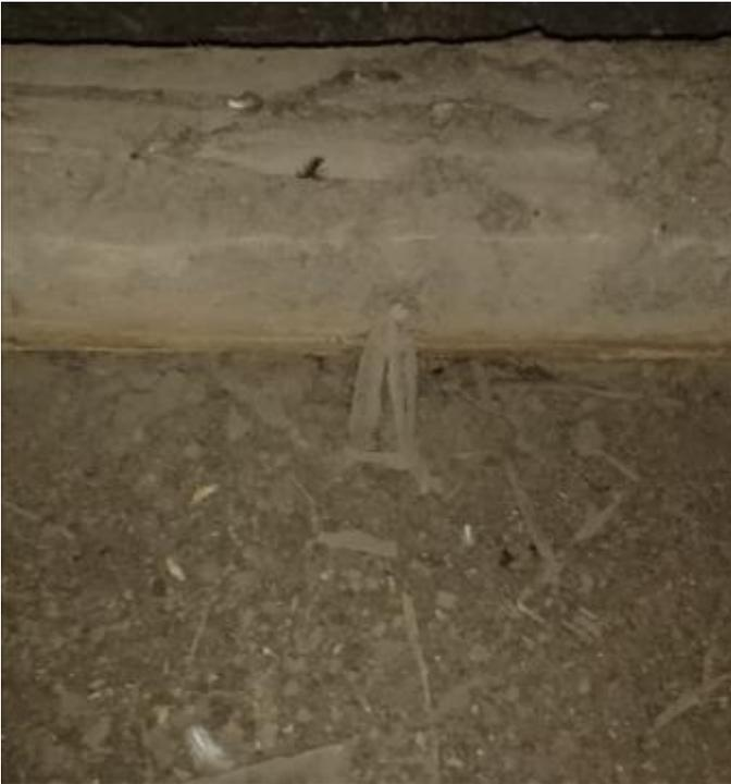
*Figura 98 Detalle amarre en cabestro, sostenida con una puntilla clavada al tirante, Cubierta, Casa Zarama. Foto tomada por el autor.*
