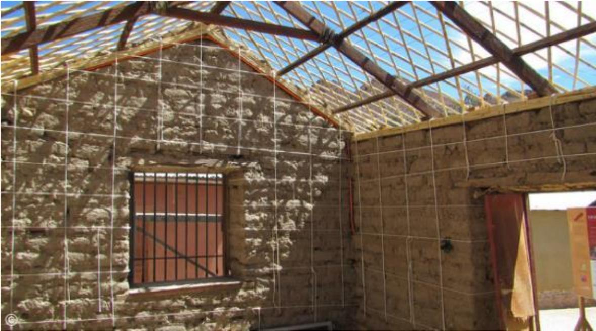
Figura 20 Sistema de drizas para el reforzamiento estructural de una edificación de adobe – Belén, Chile. FUENTE: (Giribas, 2017).
