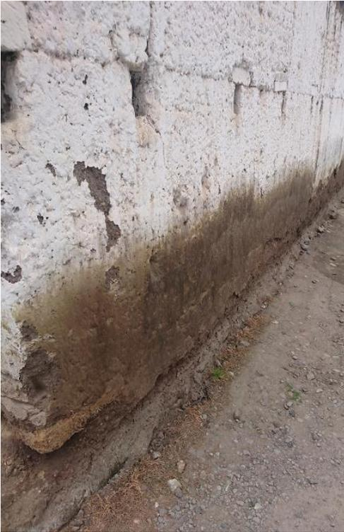
*Figura 48 Humedad basal de muro de tapia. Parqueadero Carrera 24 No 21. Foto tomada por el autor.*
