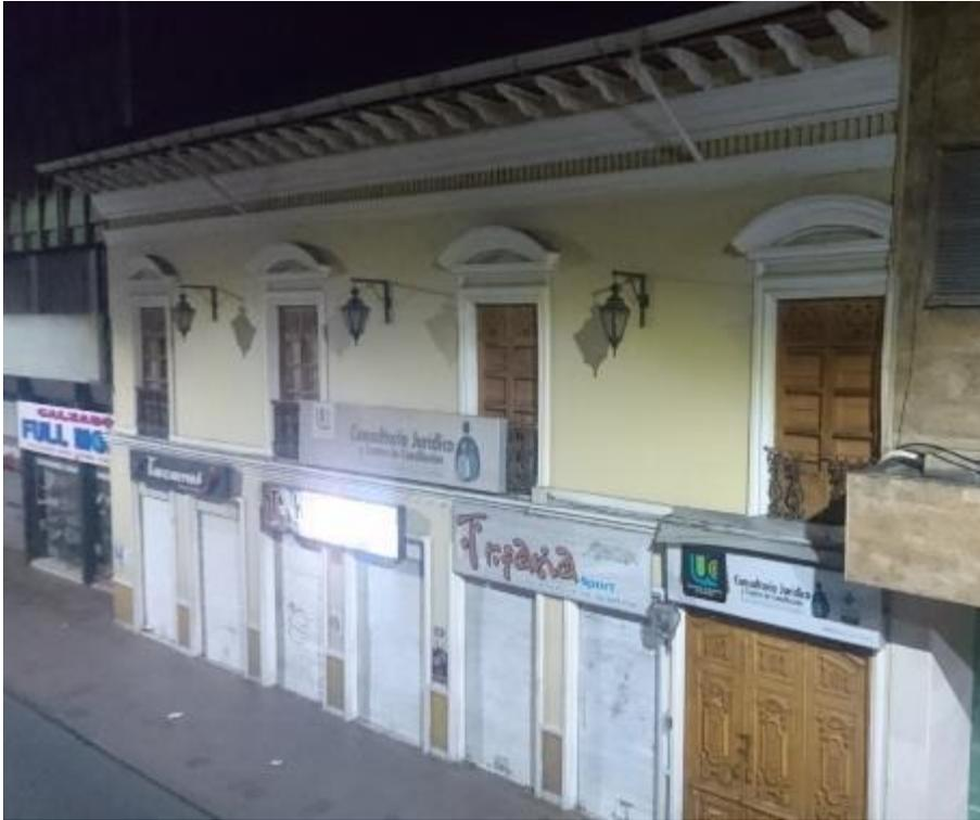
Figura 46 Ausencia de junta sísmica entre la edificación en tapia y las construcciones de rigidez y alturas distintas, Frente la Casa Zarama, Calle 18 No 23. Foto tomada por el autor.
