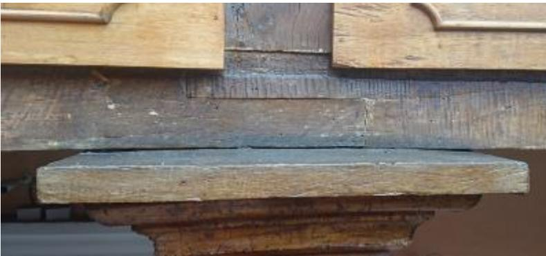
Figura 73 Ensamble a media madera viga de carga, Casa Navarrete, Calle 17 No 24. Foto tomada por el autor.
