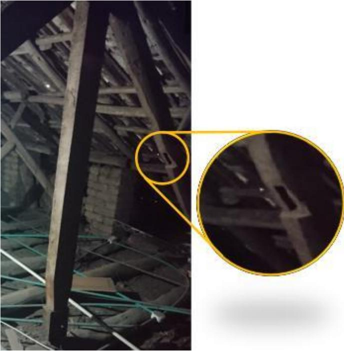
*Figura 78 Detalle unión en espiga Par – Tornapunta, Cubierta, Casa Zarama. Foto tomada por el autor.*
