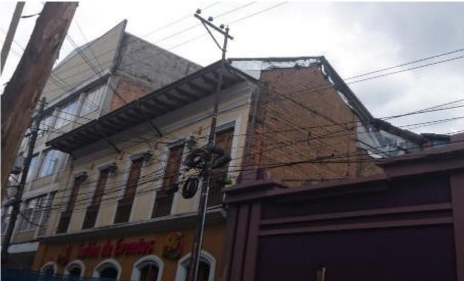
Figura 88 Protección de coronación de muros, mediante láminas de zinc, Salón de eventos Iraka, Calle 17 No 26. Foto tomada por el autor.
