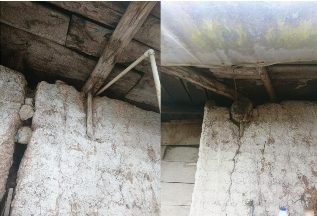
Figura 108 Sistema de arriostamiento mediante cuñas de madera en los extremos externos de los tirantes, Casa campesina, Nariño. Foto tomada por el autor.
