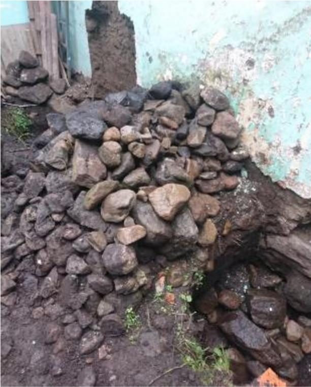
Figura 44 Roca utilizada para la construcción de cimentación, Calle 10 No 25 – 10. Foto tomada por el autor.
