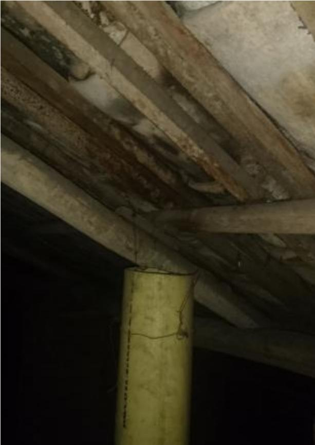
*Figura 90 Deterioro en los listones debido a los vapores expulsados por la tubería de Re-ventilación, Cubierta, Casa Zarama. Foto tomada por el autor.*
