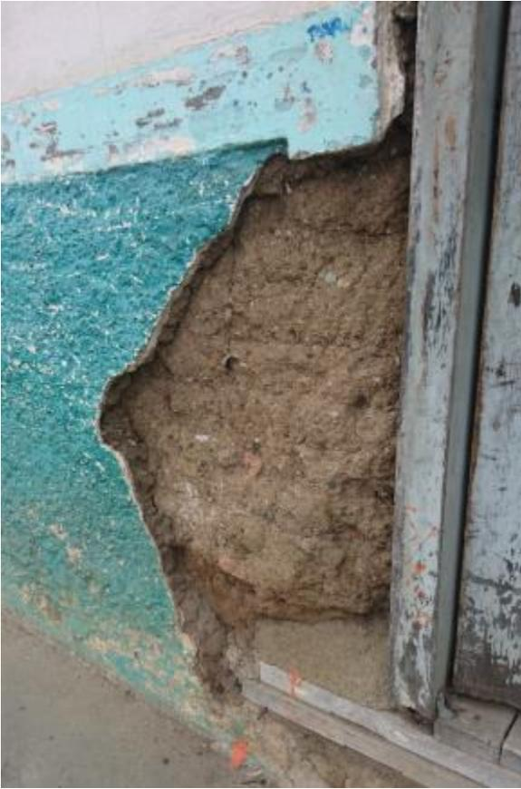
*Figura 63 Sócalo en barro y recubrimiento de pañete de cal, Nariño, Nariño. Foto tomada por el autor.*
