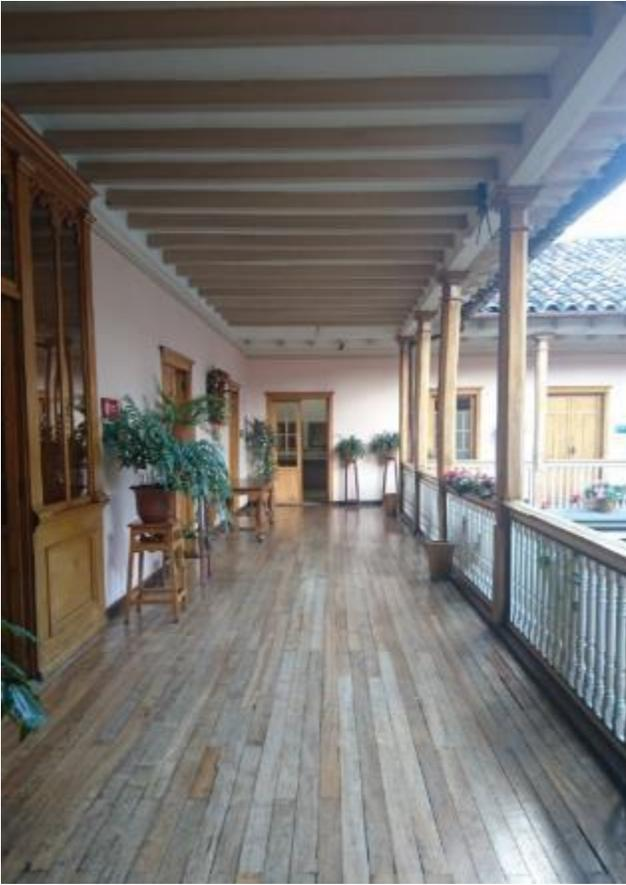
Figura 102 Cielo raso sobre viga canecillo, Pasillos segunda planta, Casa Zarama. Foto tomada por el autor.
