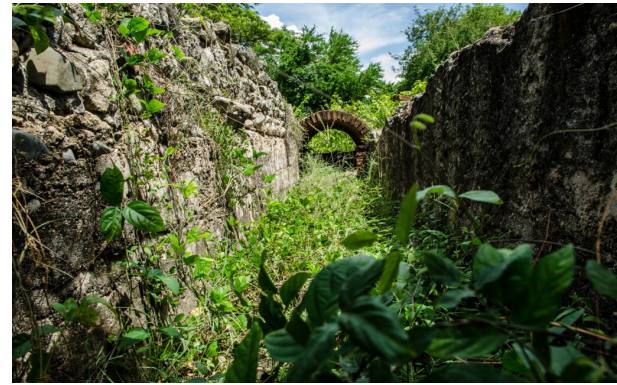
Fig.92 Ruinas acueducto del ingenio Diego Caballero. Fuente: (Cuny, 2018)
