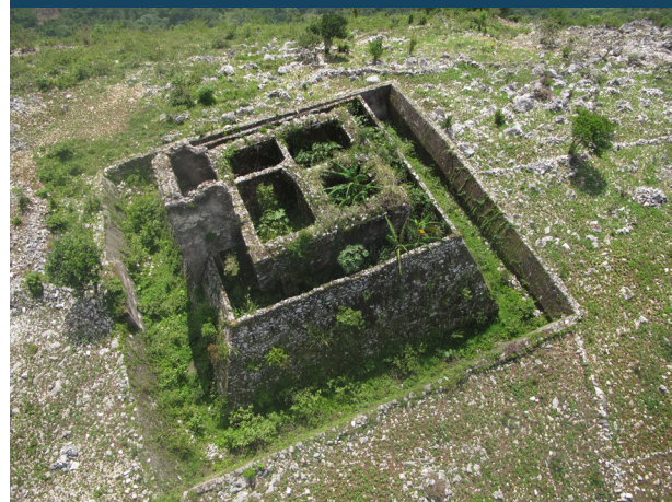
Fig.83 Edificios Les Ramiers. Fuente: Ficha Parc national historique – Citadelle, Sans Souci, Ramiers. (UNESCO, 1982)
