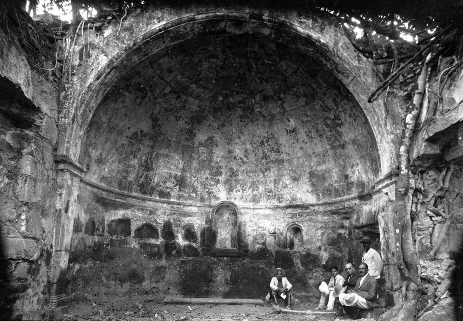
Fig.32 Fotografía de la cúpula de la capilla de Santa Ana de Engombe antes de ser intervenida. Fuente: (MCRD, 2014)
