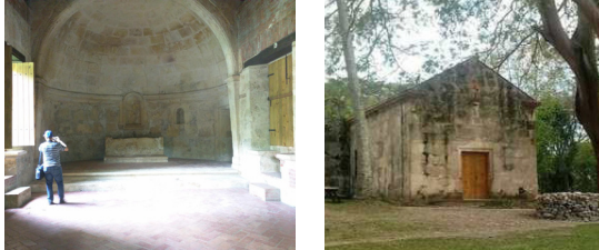
Fig.42 Capilla Santa Ana. Fotografía: Elaboración propia, 2016.
