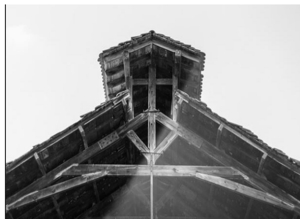
Fig.45 Fotografías del techo de la casa de purga del ingenio de Boca de Nigua. Fuente: (Caba, Darwin, 2014).
