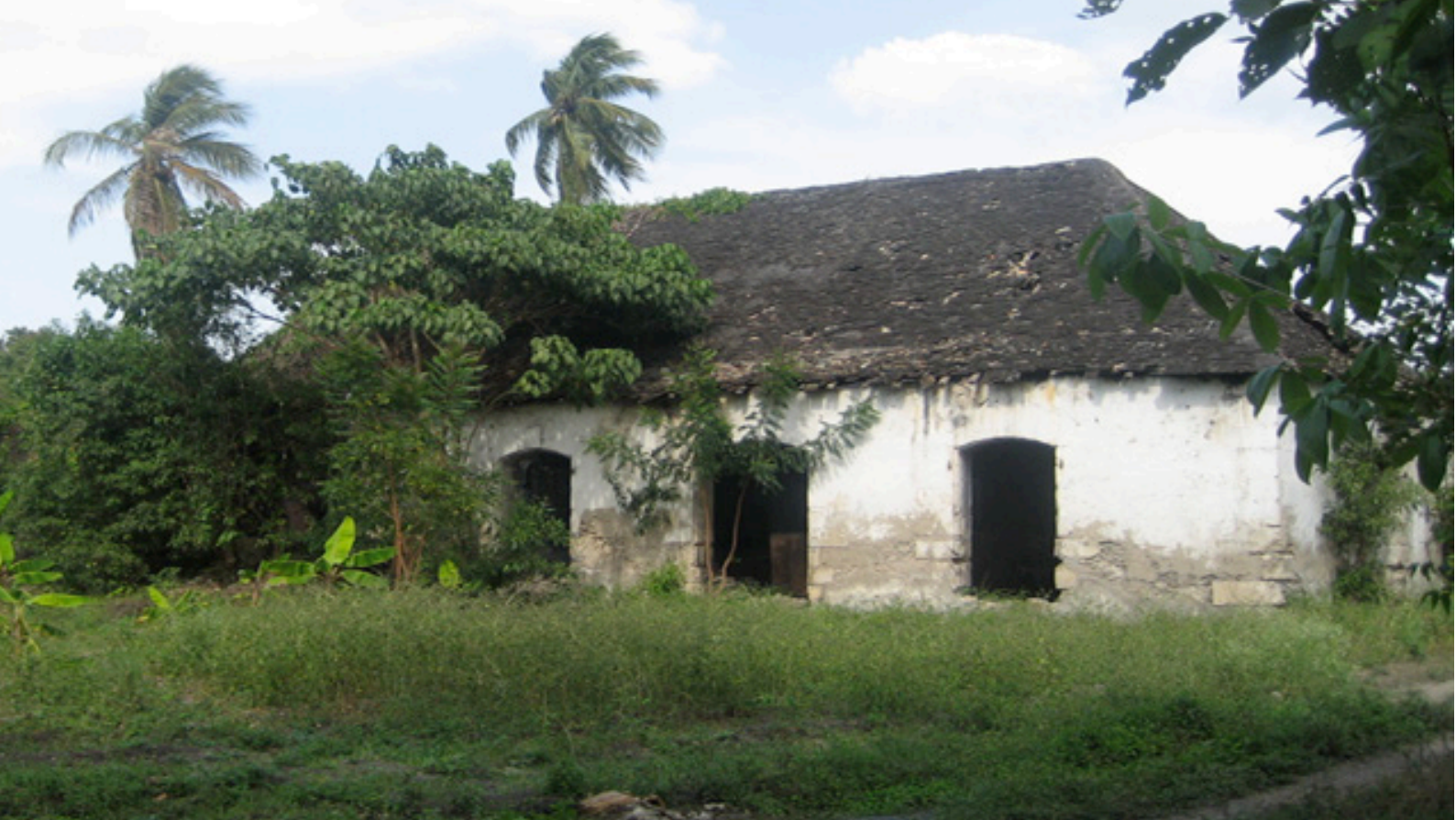
Fig.88 Ruinas de la casa de purga del ingenio Guillon en Haití. Fuente: (ISPAN, 2018)
