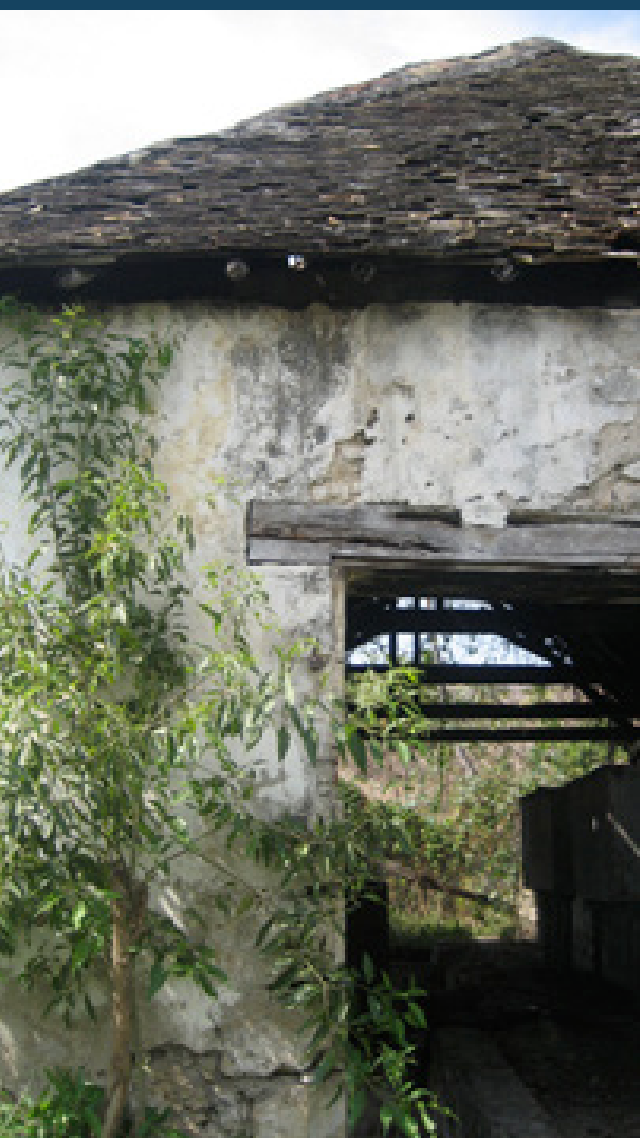
Fig.47 Ruinas del Ingenio de Guillon en Haití. Fuente: (ISPAN, 2018). Se puede apreciar la estructura original de las cubiertas y los detalles constructivos del tratamiento del tejamaní (que es una combinación del adobe, la cana y la madera) como medio de recubrimiento típico utilizado durante el auge de la Colonia en el Caribe.
