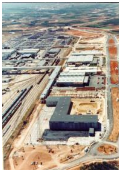
Figura 41. Fotografía Parque de Proveedores
