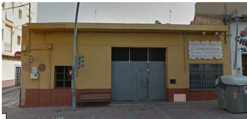
Fig.:3. Carpintería metálica S.Tortajada
