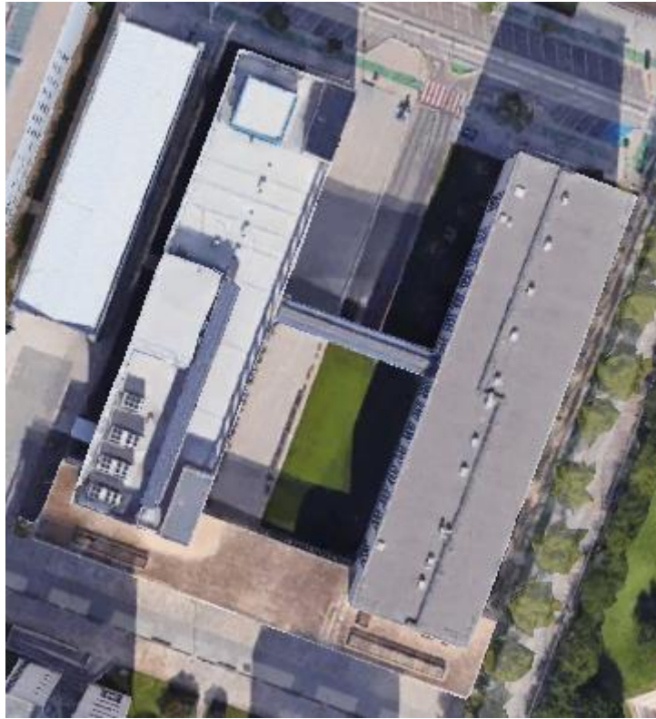
Ilustración 5. Vista aérea de la Escuela Técnica Superior de Ingeniería del Diseño.
