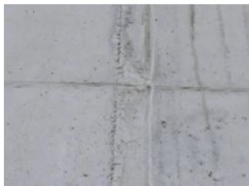
Figura 40 Juntas de construcción [13].
