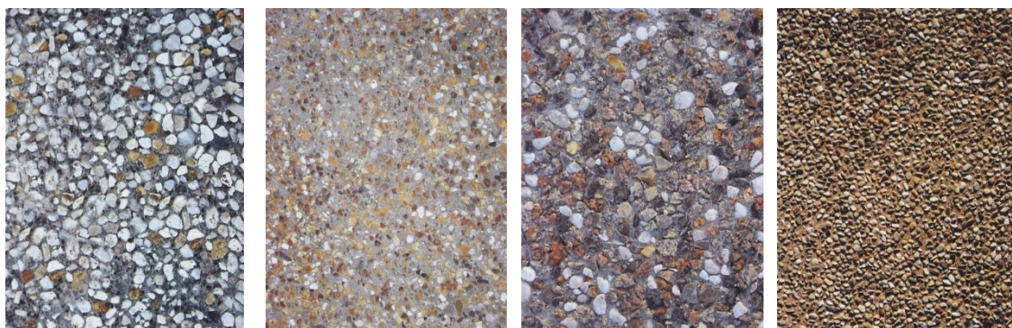
Figura 6 Hormigón visto con árido expuesto [21].
