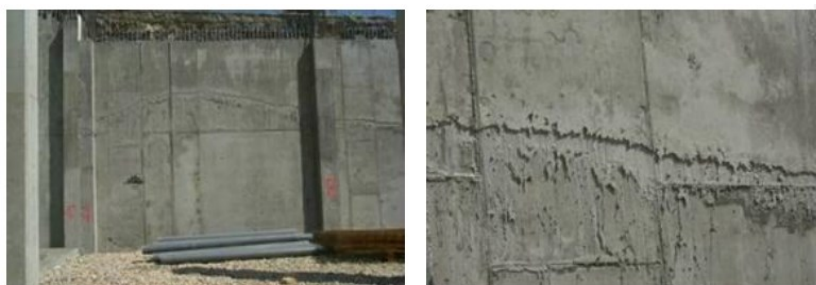
Figura 10 Formación de juntas frías [13].
