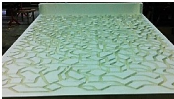
Figura 27 Encofrado de silicón [39].
