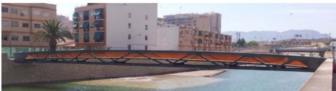
Figura 22 Pasarela Barranco de las ovejas en Alicante [35].
