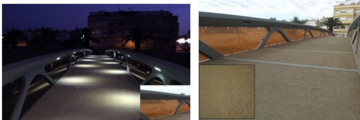
Figura 23 Acabado de la pasarela Barranco de las ovejas en Alicante [35].
