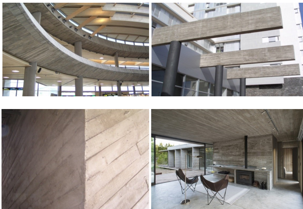
Figura 14 Acabado del hormigón con superficie encofrante de madera [21].
