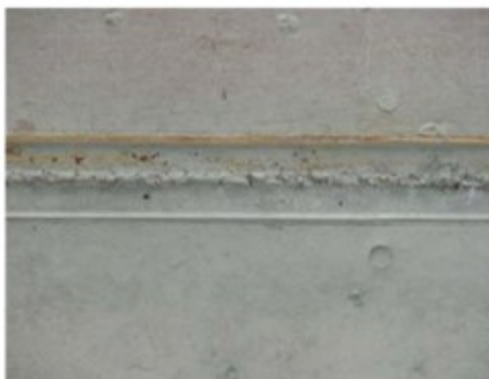
Figura 39 Juntas de paneles de encofrado [13].
