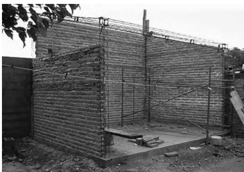
Figura 18. Cerramiento con ladrillo prefabricado con plástico reciclado y cerramiento con ladrillo prefabricado con plástico reciclado con revoco.
