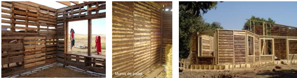
Figura 35. Cerramiento de palés.
