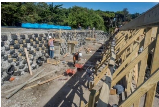
Figura 5. Construcción de los muros para una escuela sostenible en Buenos Aires, Argentina.
