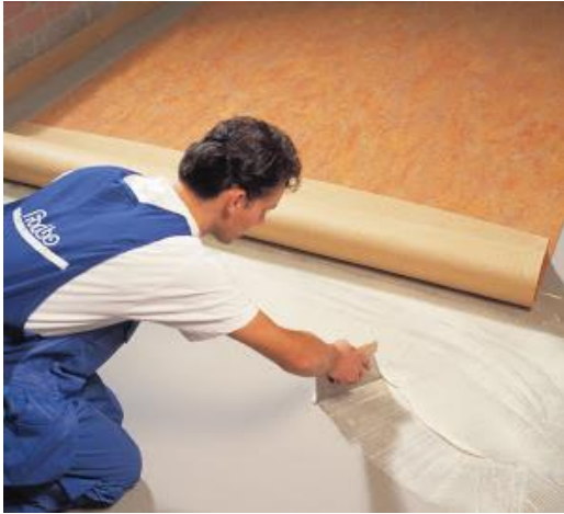
Figura 19. Forbo. Instalador de forbo aplicando adhesivo en Marmoleum.
