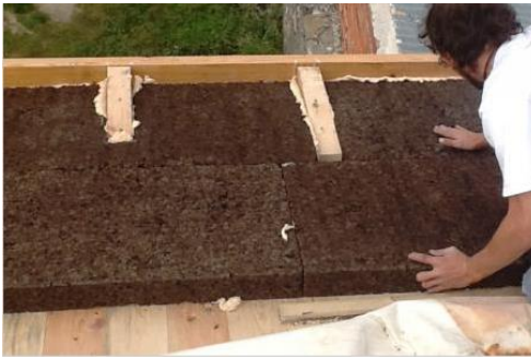
Figura 58. Instalación de los paneles de corcho.
