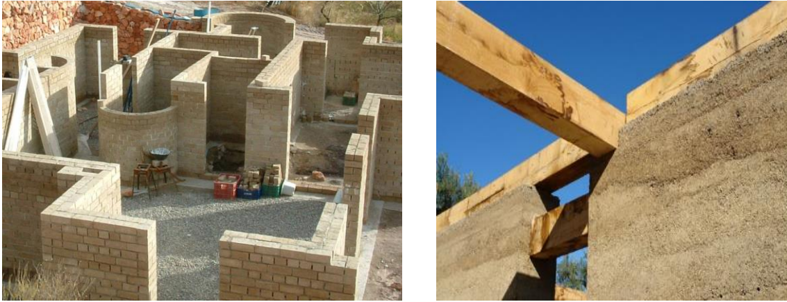
Figura 42. Construcción de una vivienda unifamiliar.
