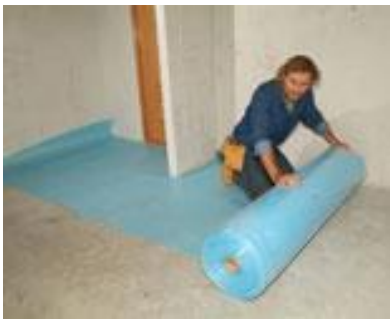
Figura 38. Extensión de las tiras de polietileno.
