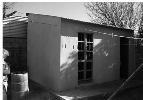
Figura 18. Cerramiento con ladrillo prefabricado con plástico reciclado y cerramiento con ladrillo prefabricado con plástico reciclado con revoco.
