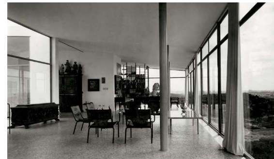
Fig. F3.02. Vista interior Casa de Vidrio. (1951)
