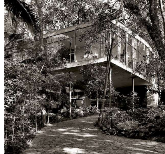
Fig. F3.01. Vista exterior Casa de Vidrio. (1951)
