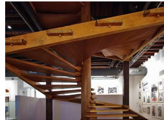
Fig. F3.31. Imagen en detalle del desarrollo de la escalera
