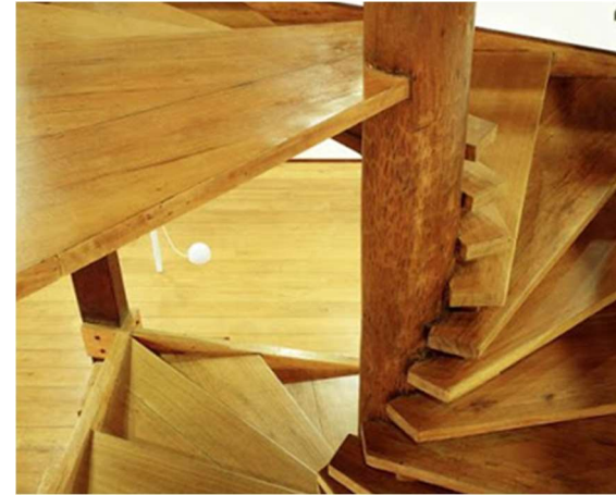
Fig. F3.32. Peldaños escalera helicoidal
