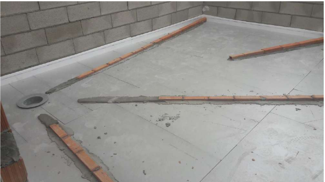
IMAGEN 62: Formación de pendientes y colocación cazoleta
