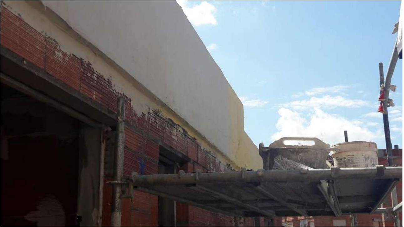
IMAGEN 79: Comienzo de los trabajos del monocapa.
