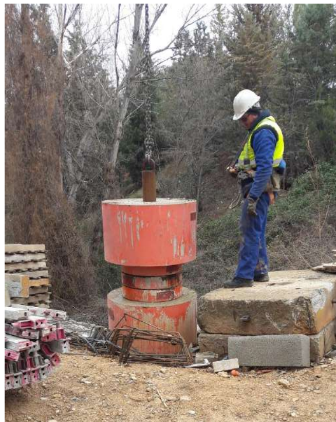
IMAGEN 15: Inspección de un técnico para comprobar que la grúa funciona perfectamente.
