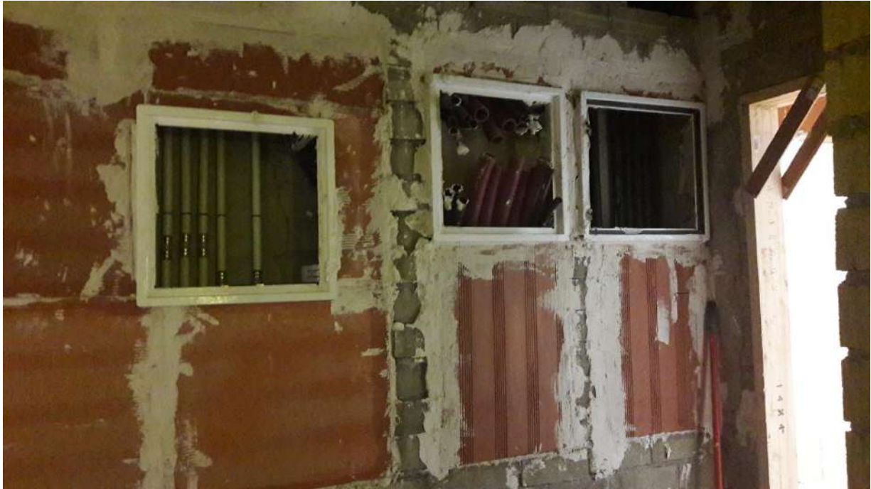
IMAGEN 64: Cuadro de agua, telecomunicaciones y electricidad:
