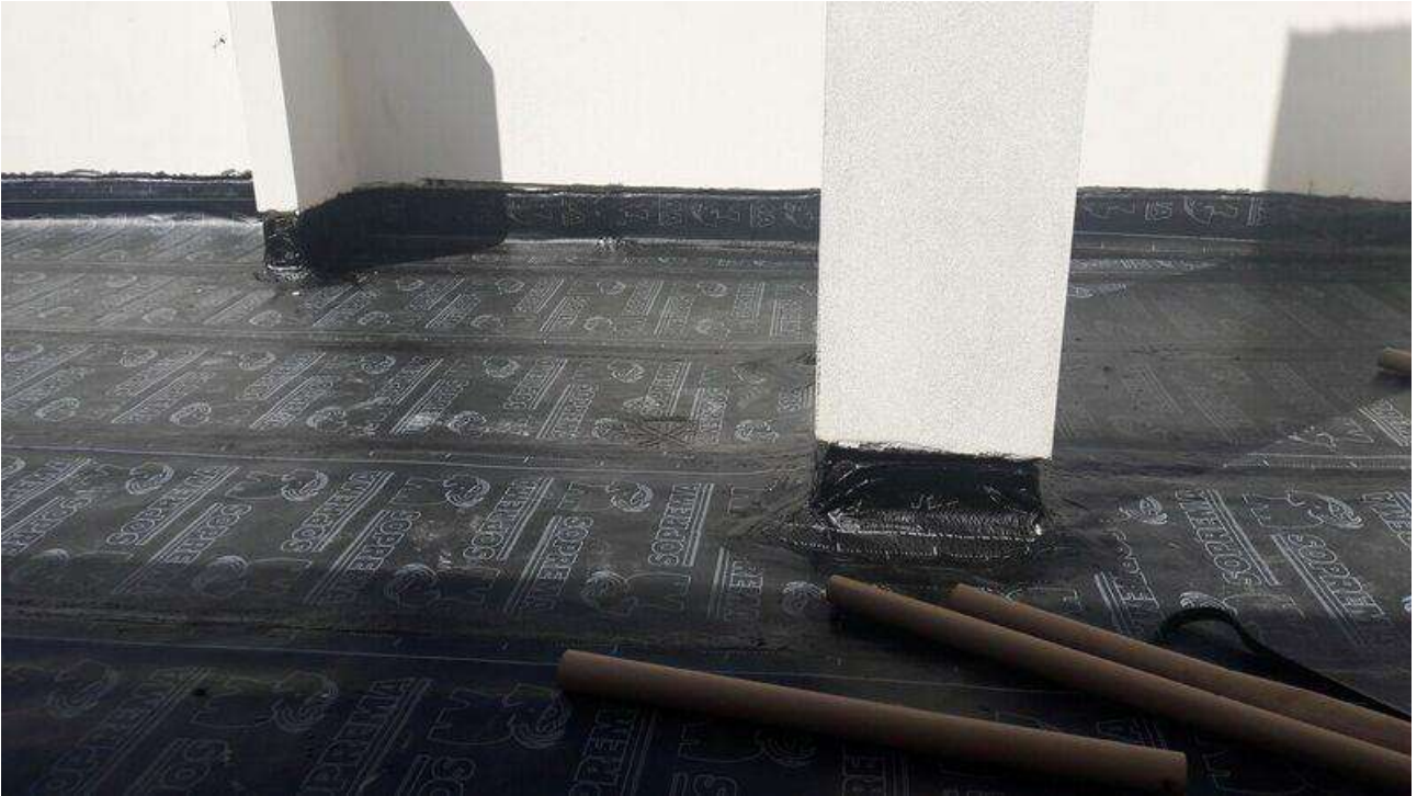
IMAGEN 102: Colocación de la tela asfáltica.
