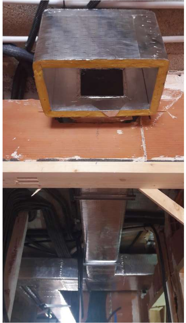
IMAGEN 96: Instalación del aire acondicionado planta 1º
