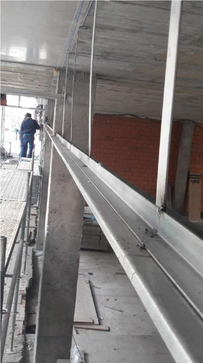
IMAGEN 33: Colocación angular de fachada
