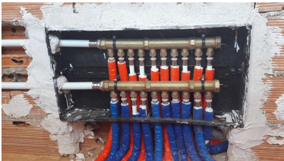
IMAGEN 99: Colocación de la calefacción la cual será mediante radiadores
