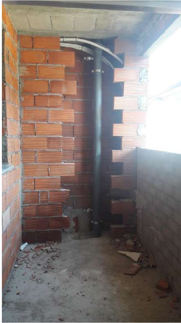
IMAGEN 42: Colocación de las bajantes en la terraza de la fachada posterior
