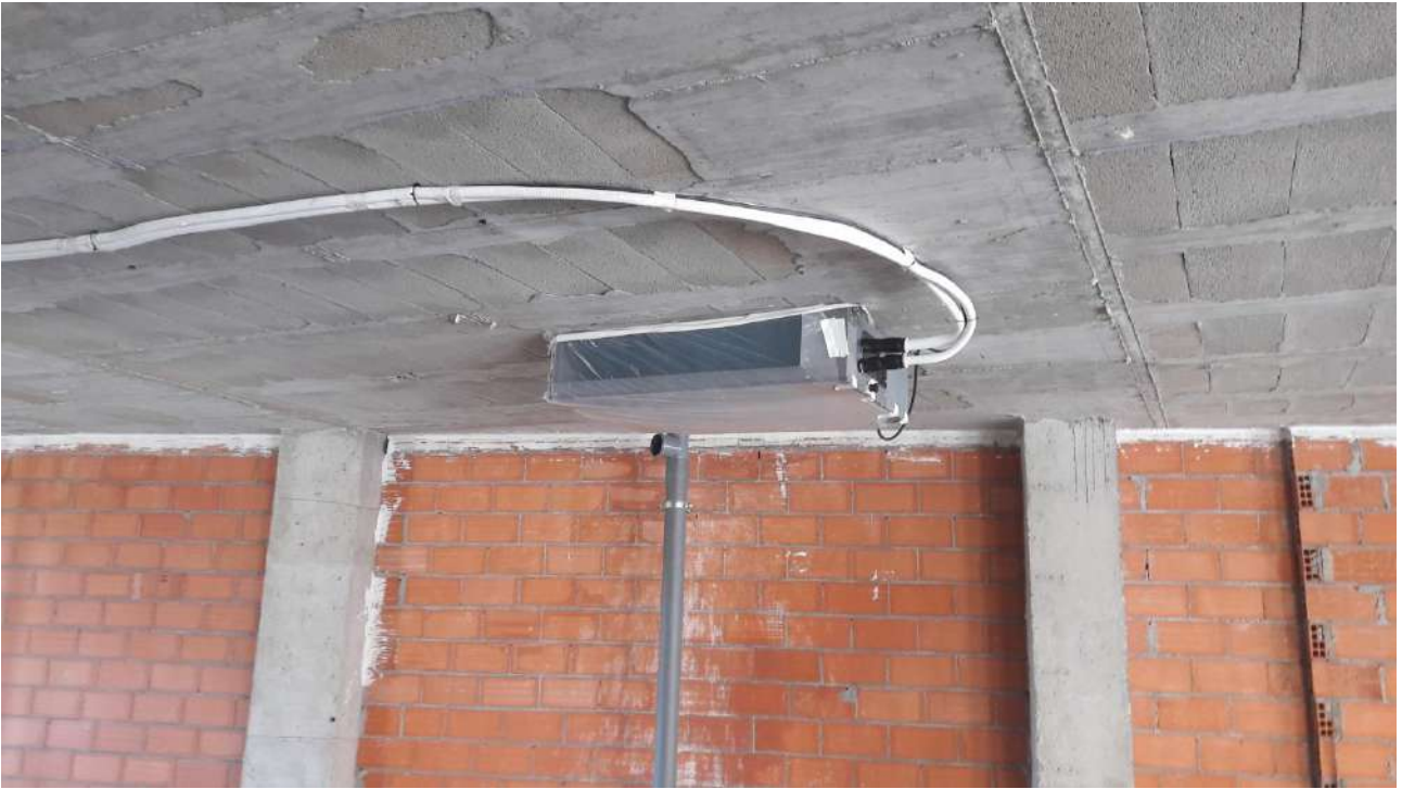
IMAGEN 40: Colocación del aire acondicionado
