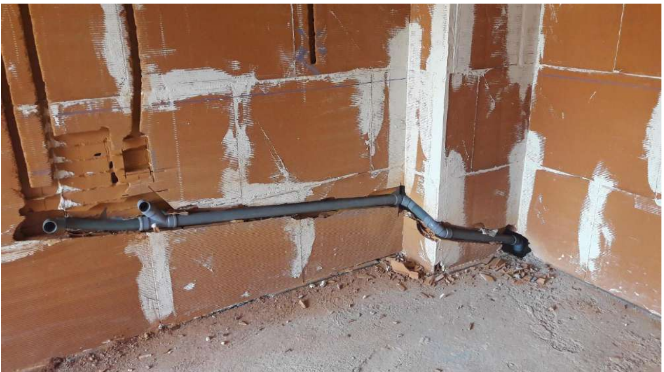
IMAGEN 91: Trabajos de fontanería
