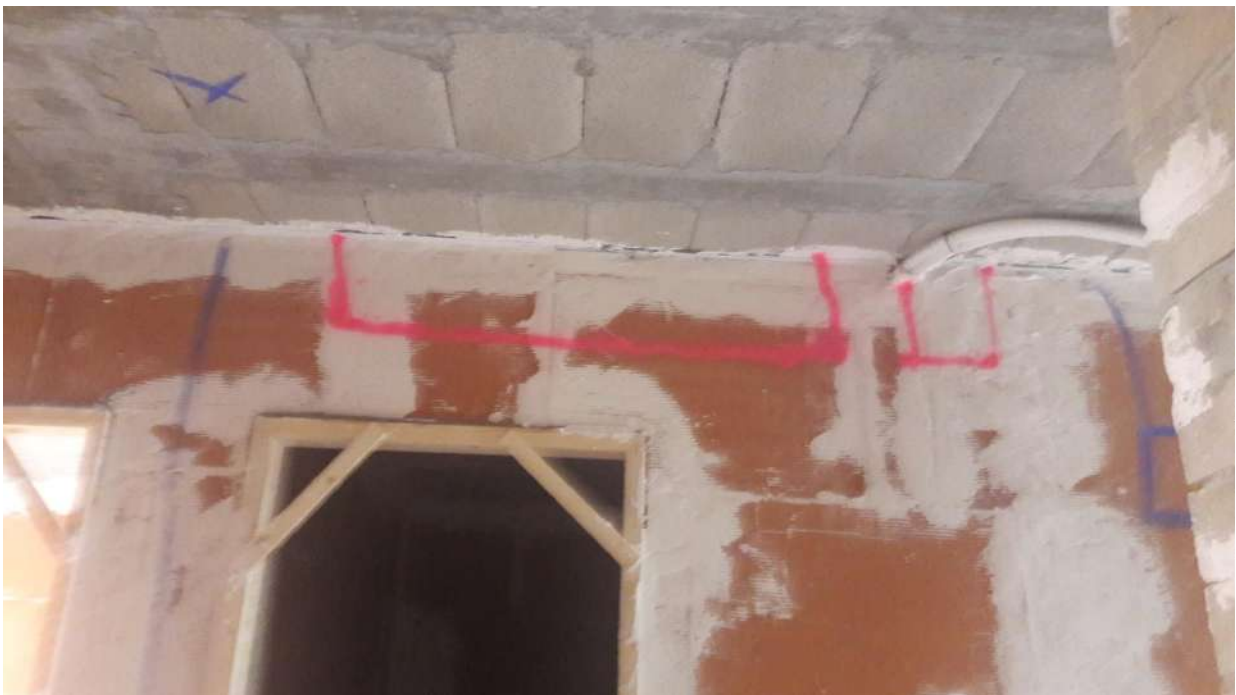
IMAGEN 70: Replanteo donde estarán las rejillas para el aire acondicionado (el hall)
