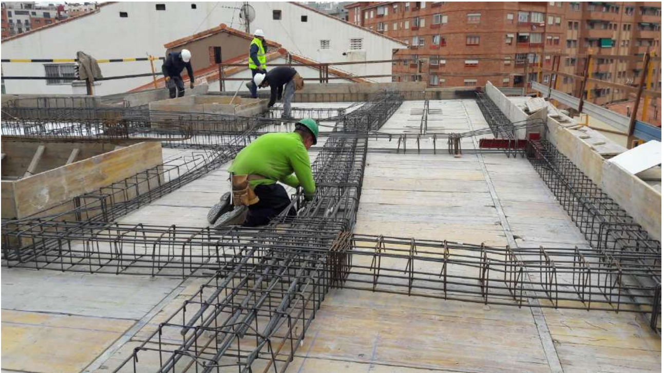
IMAGEN 7: Montaje ferralla del último forjado.
