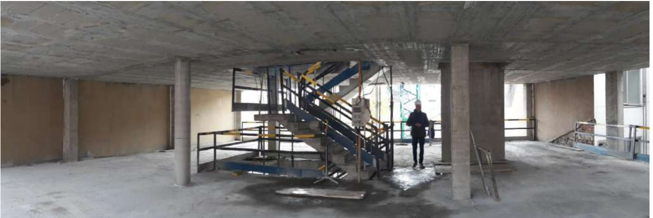
IMAGEN 16: Limpieza del escombro generado por el desencofrado de las plantas
