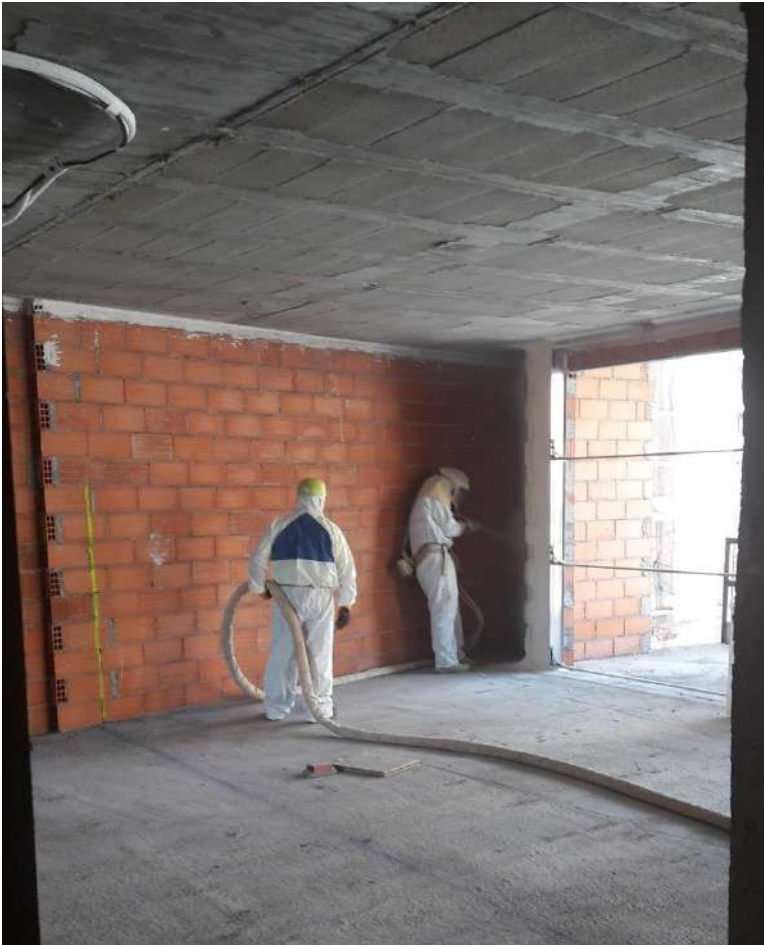
IMAGEN 43: Proyección del poliuretano con buen uso de los EPIS proyectado.
