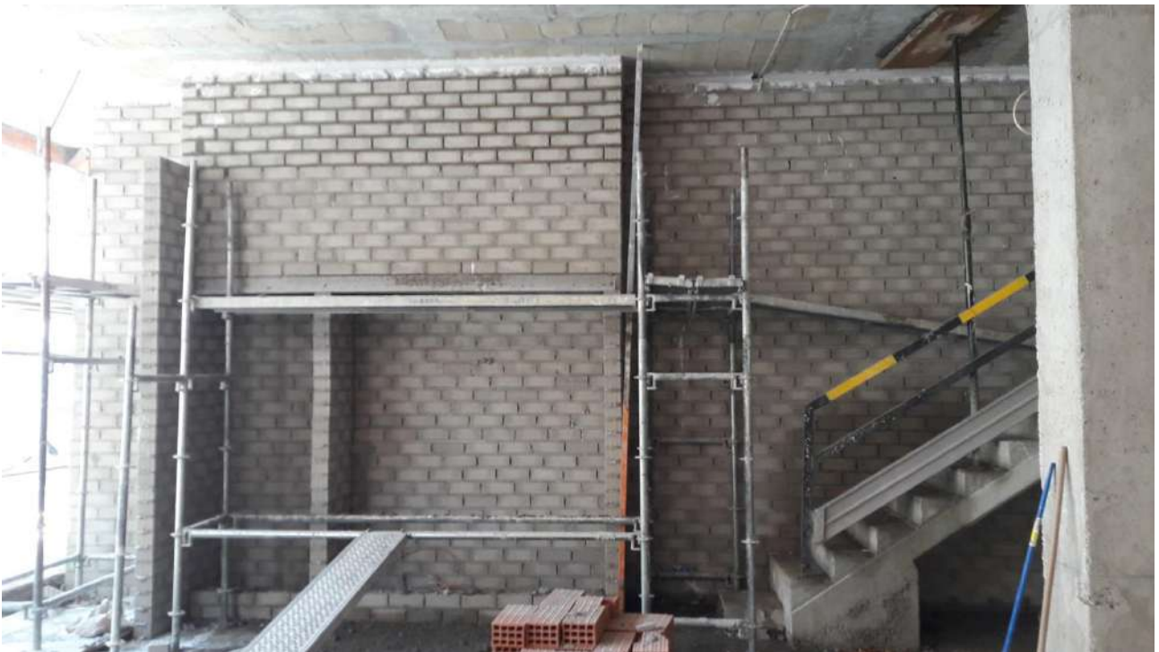
IMAGEN 37: Trabajos de albañilería en planta baja
