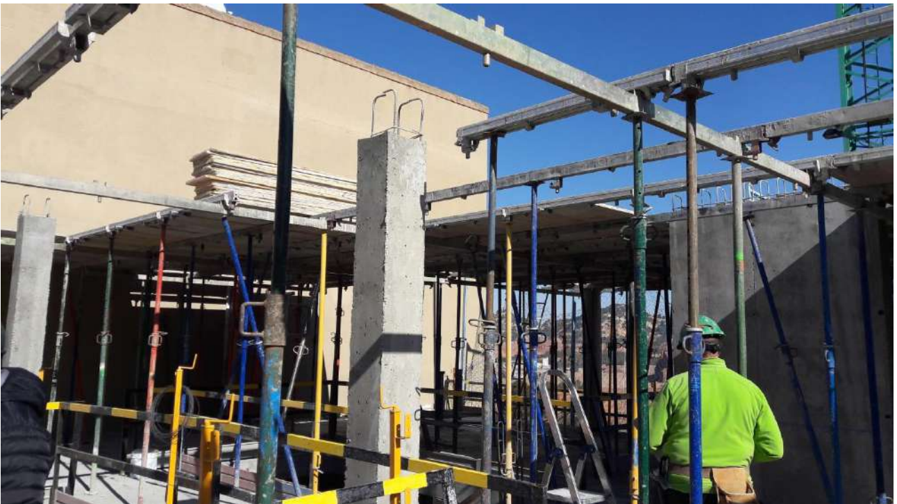
IMAGEN 3: Encofrado del último forjado.
