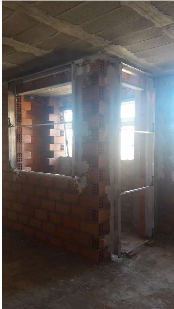
IMAGEN 35: Carpintería interior (puertas y ventanas)
