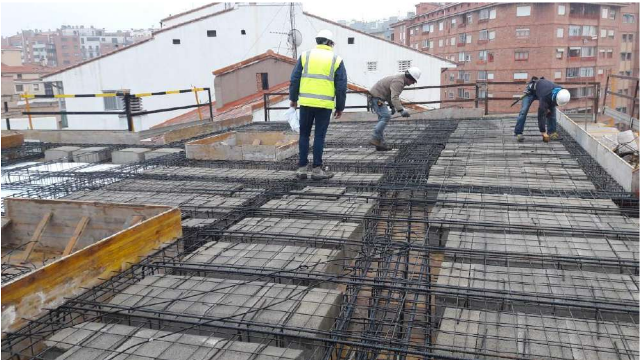
IMAGEN 8: Colocación de bovedillas, positivos y negativos.
