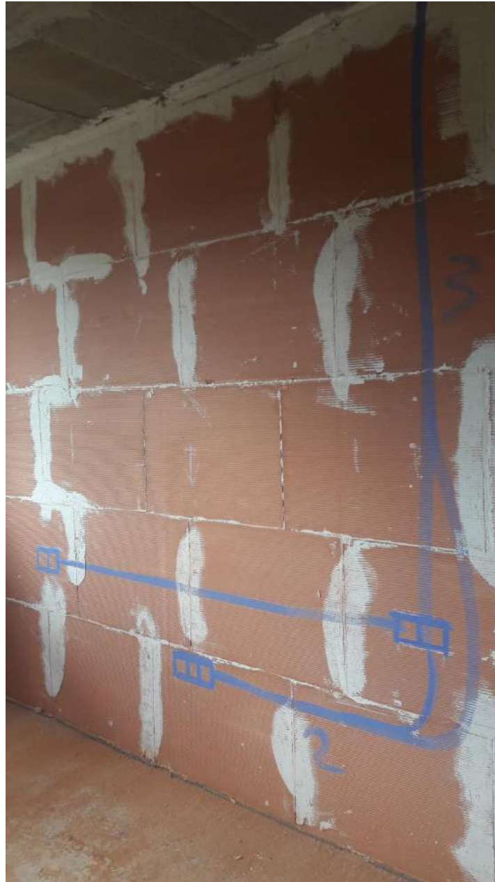
IMAGEN 67: Replanteo instalaciones
