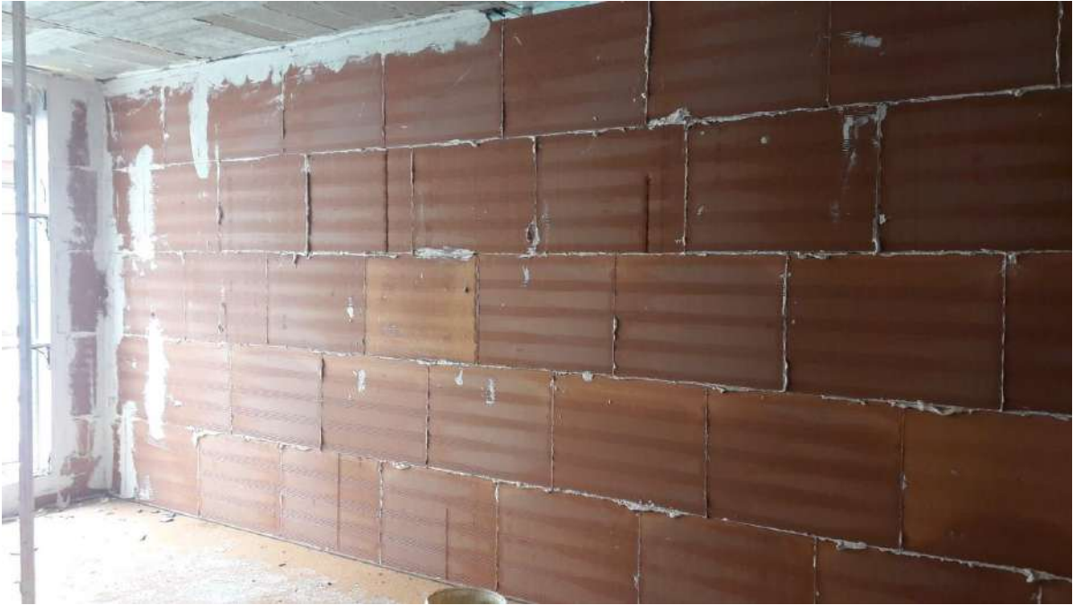
IMAGEN 53: Ejecución de la tabiquería interior
