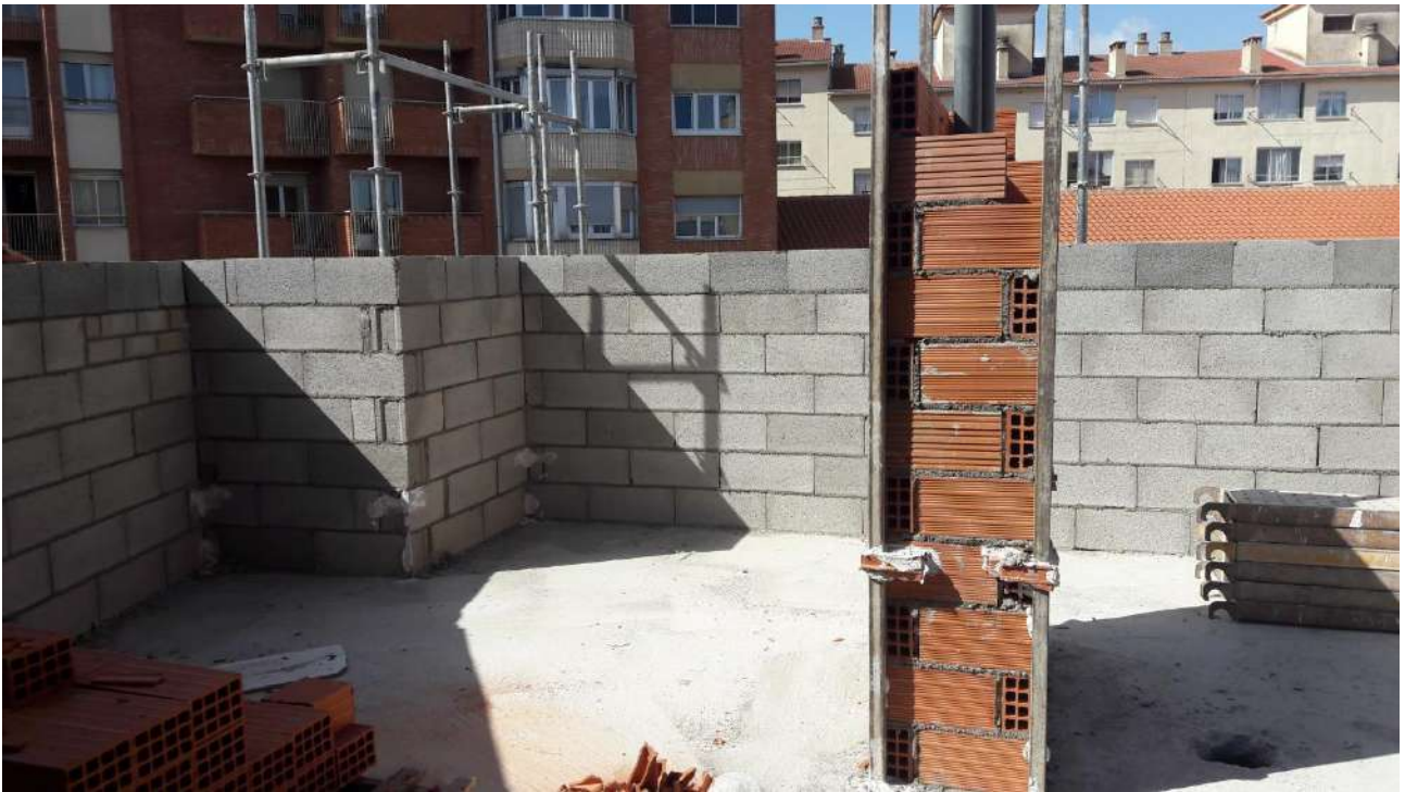
IMAGEN 49: Trabajo en fachada principal
