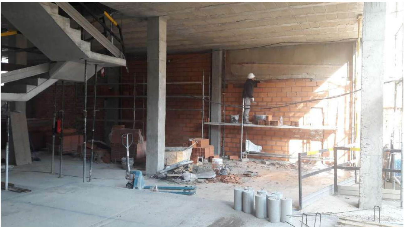
IMAGEN 24: Ejecución de las medianeras en planta baja
