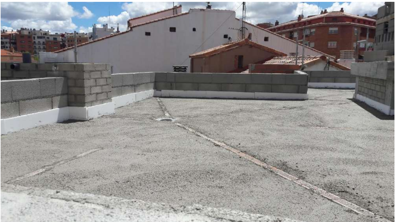
IMAGEN 60: Pendiente de las cubiertas
