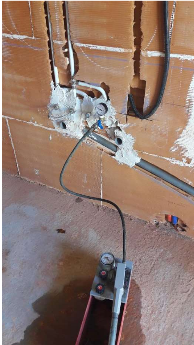
IMAGEN 106: Prueba de presión de las tuberías para ver si hay alguna fuga.
