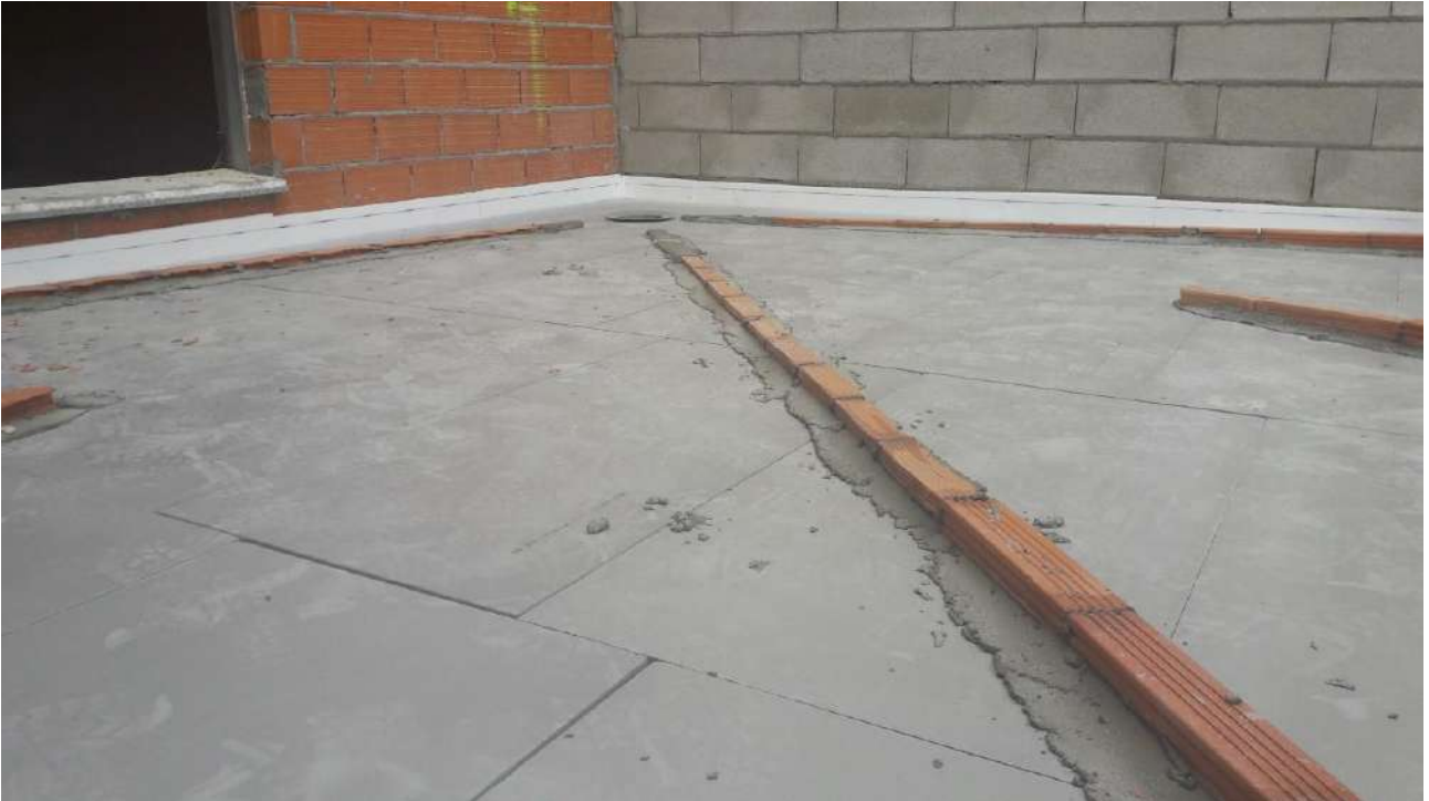
IMAGEN 62: Pendientes de la cubierta
