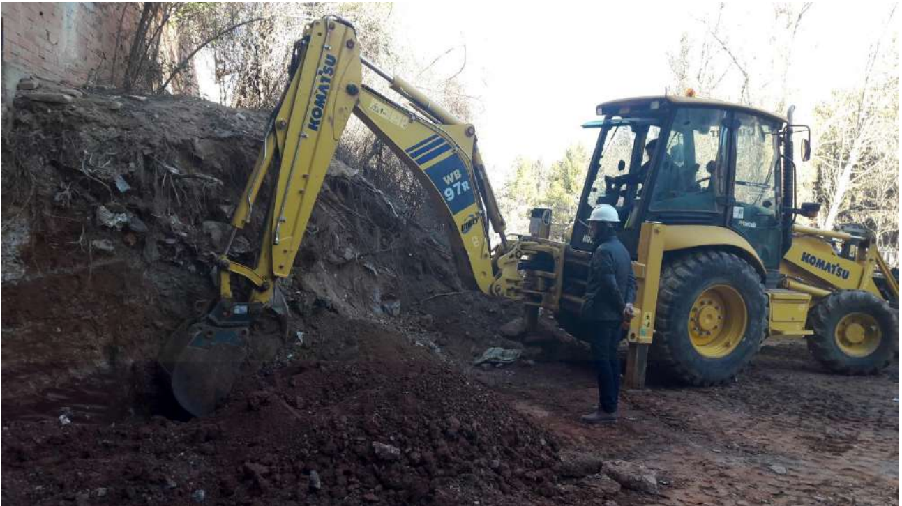
IMAGEN 4: Apertura de zanja corrida para la cimentación de muro.
