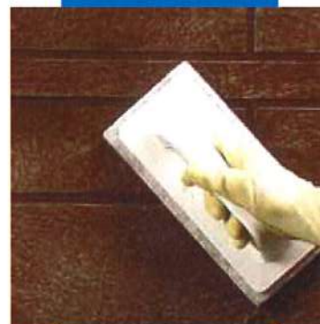
Limpieza de las juntas con Scotch-Brite® (con el producto parcialmente endurecido)
