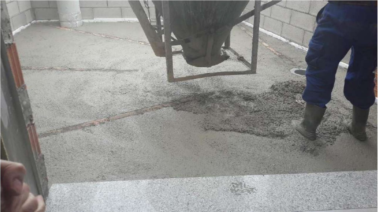
IMAGEN 63: Hormigonado de las pendientes de la cubierta
