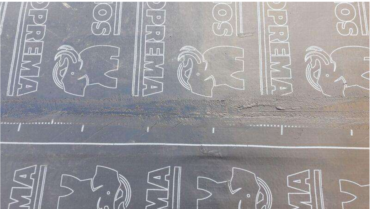
IMAGEN 103 a: Unión de las telas asfálticas con soplete.
