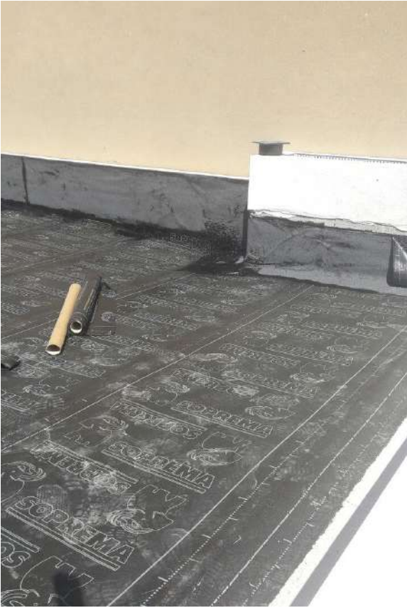
IMAGEN 108: Ejecución de la tela asfáltica en la cubierta
