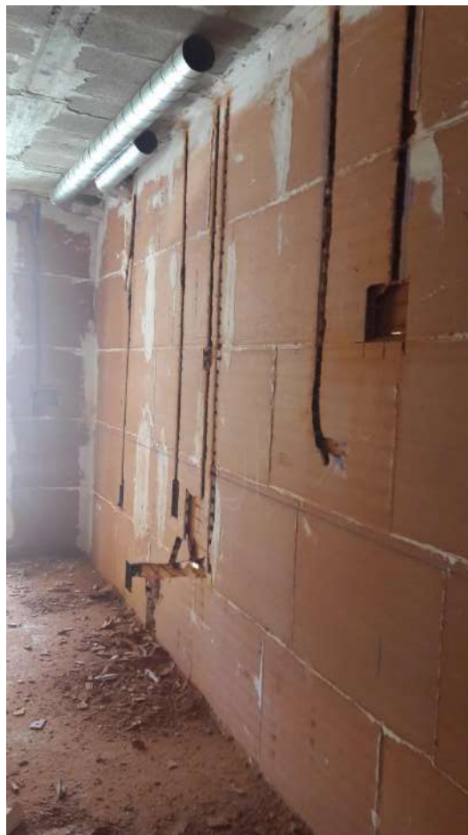
IMAGEN 77: Ejecución de las rozas en la planta 1º.
