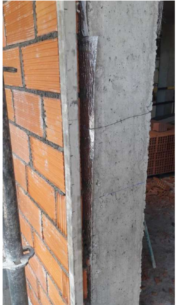
IMAGEN 27: Correcto aislamiento del pilar
