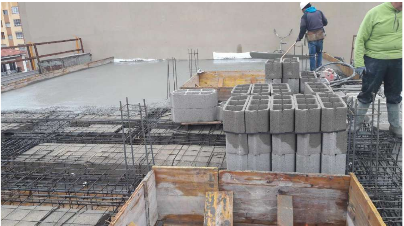
IMAGEN 11: Vibrado del hormigón
