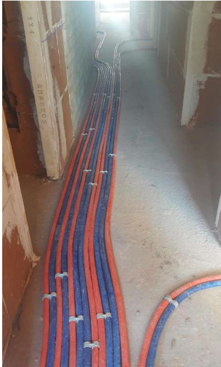
IMAGEN 100: Colocación de la calefacción en viviendas
