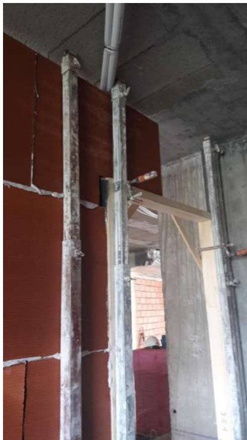
IMAGEN 54: Tabicado del cabecero de las puertas en forma de pistola.
