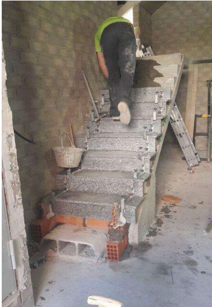
IMAGEN 101: Colocación de los peldaños de la escalera.
