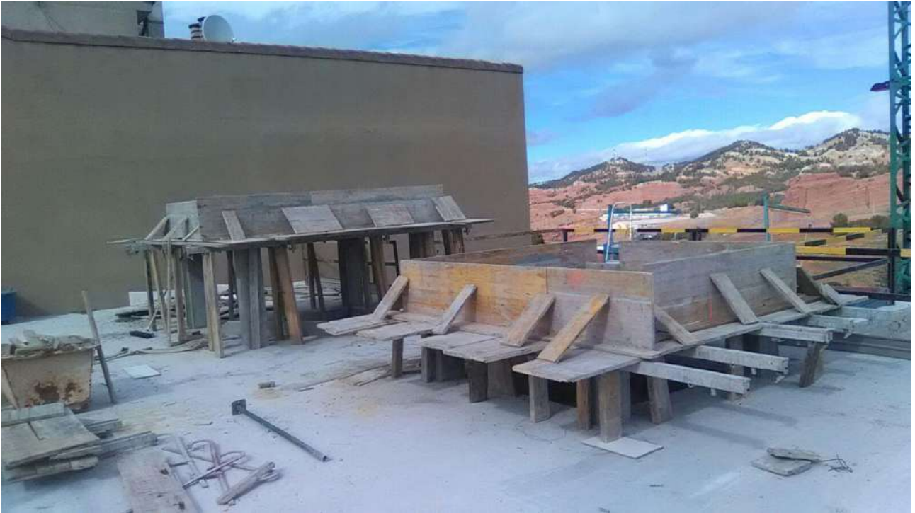
IMAGEN 14: Encofrado y colocación de las armaduras para el posterior hormigonado
