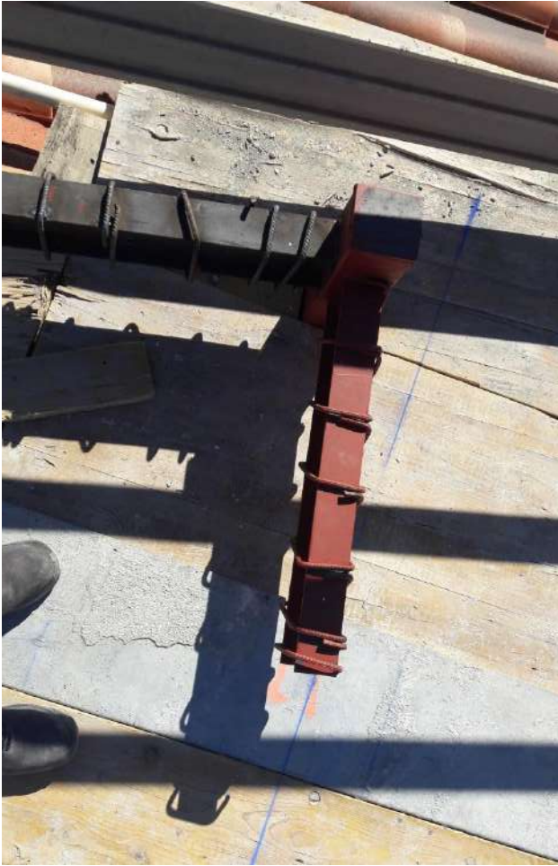
IMAGEN 6: Anclaje estructura metálica forjado de hormigón armado mal ejecutado
