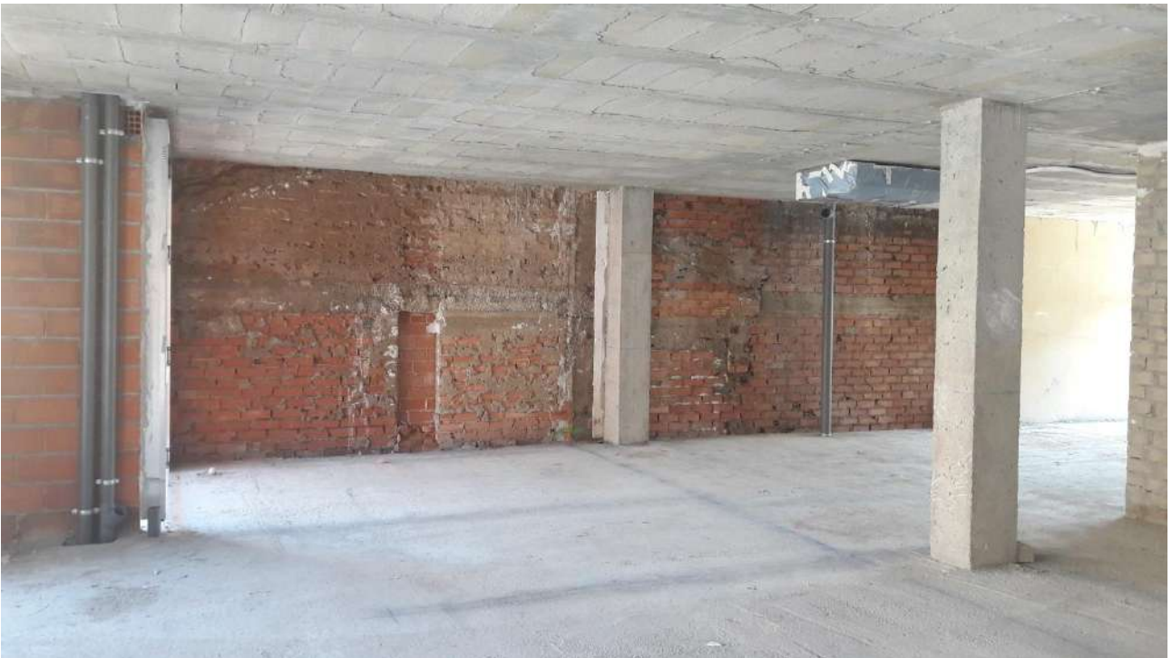
IMAGEN 41: Colocación de las bajantes
