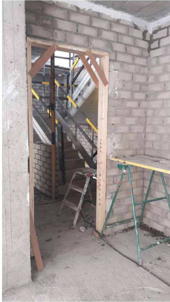
IMAGEN 22: Ejecución de huecos y dinteles
