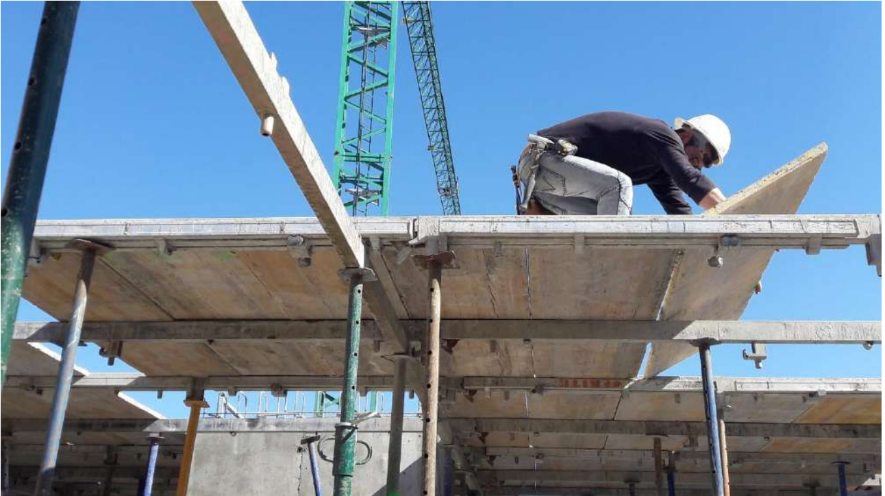
IMAGEN 2: Encofrado del último forjado.
