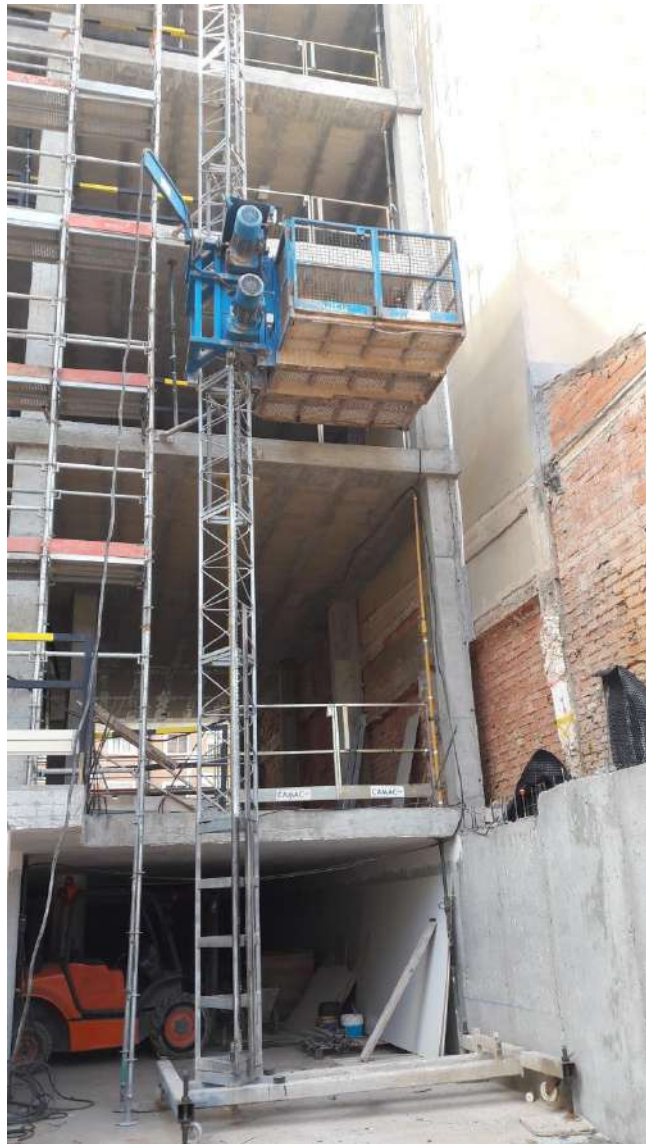
IMAGEN 17: Montaje del montacargas
