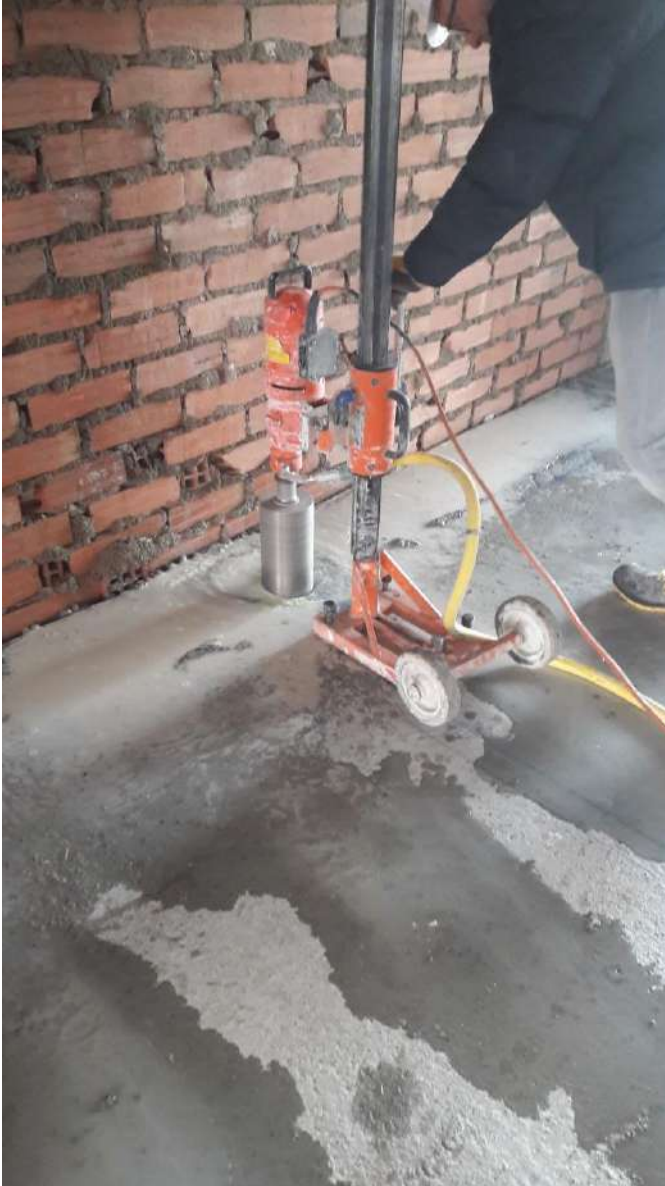
IMAGEN 38: Uso de la máquina perforadora
