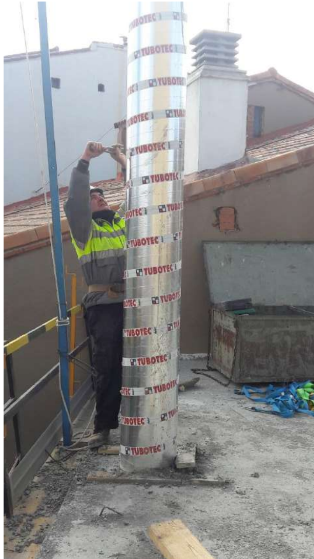
IMAGEN 1: Peón quitando el cable del encofrado del pilar redondo sin guantes = Corte
