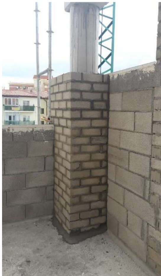
IMAGEN 66: Trabajos de media caña.
