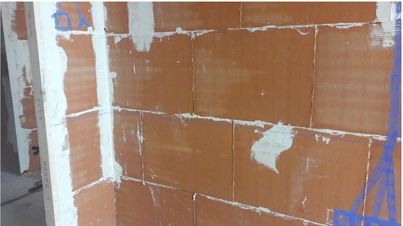
IMAGEN 75: Replanteo de los niveles.
