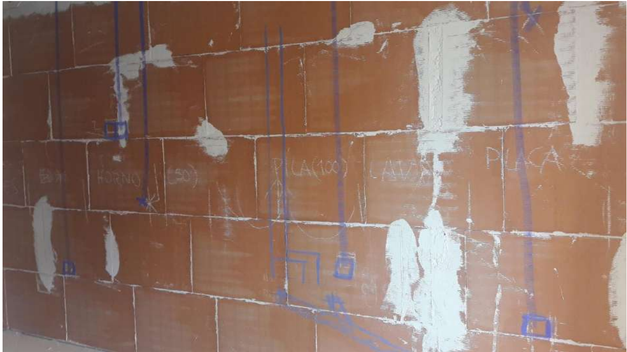
IMAGEN 69: Replanteo de la cocina
