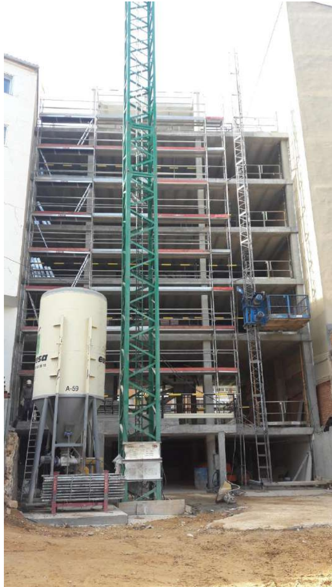
IMAGEN 19: Colocación del andamio
