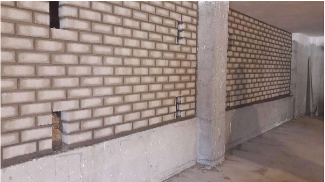
IMAGEN 23: Ejecución de la medianera en planta sótano
