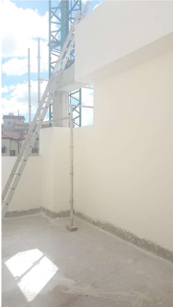
IMAGEN 95: Buen acabado del monocapa en el pilar.
