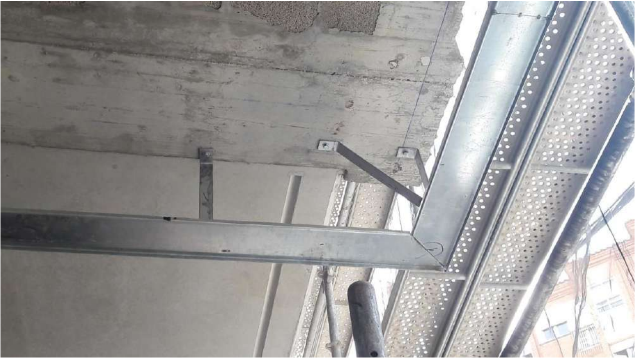
IMAGEN 28: Ejecución del cuelgue de la fachada
