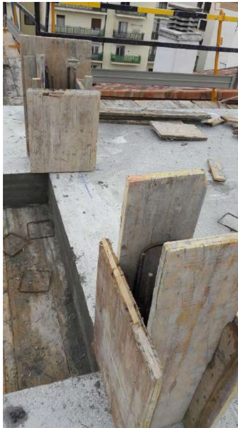
IMAGEN 12: Encofrado de los pilares para la planta torreón
