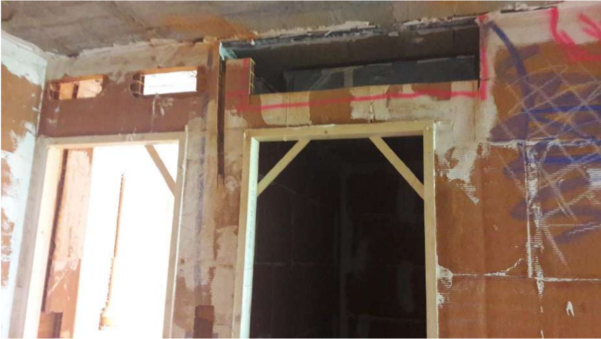
IMAGEN 76: Ejecución de las rozas en la planta 1º
