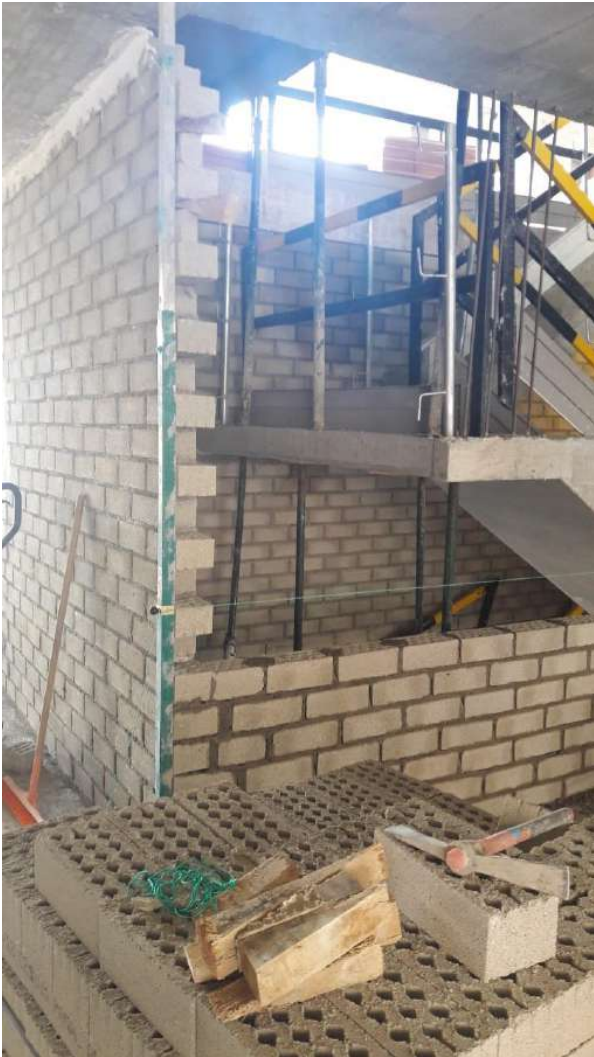
IMAGEN 20: Buena traba de la tabiquería de las zonas comunes (escaleras y ascensor)
