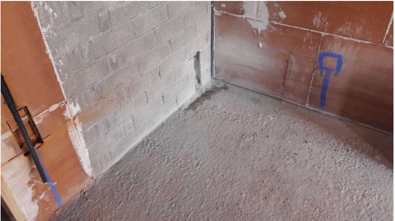
IMAGEN 90: Buena ejecución picando un poco el pavimento para que pasen los conductos donde hay un cruce de ellos.
