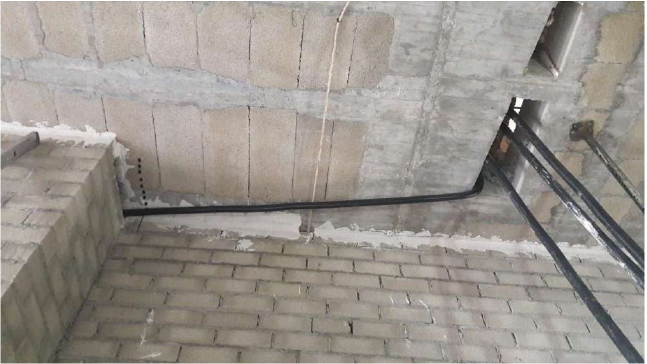
IMAGEN 56: Instalación de electricidad, teleco y agua.
