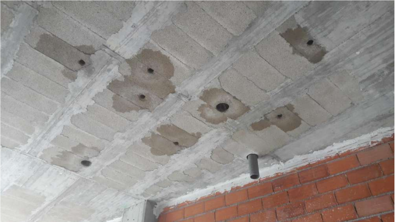
IMAGEN 74: Orificios en el forjado de los baños con una máquina perforadora.
