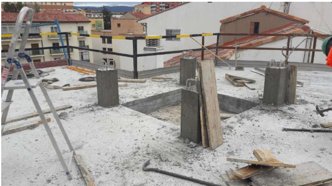
IMAGEN 13: Hormigonado de los pilares para la planta torreón.
