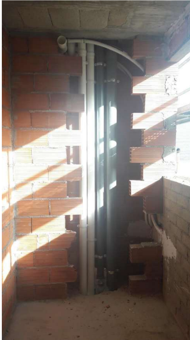
IMAGEN 48: Colocación de bajantes en la galería de la fachada posterior.
