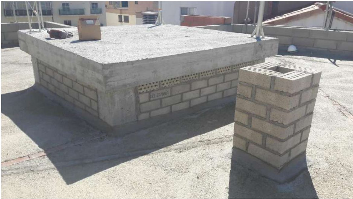
IMAGEN 66: Trabajos de media caña.
