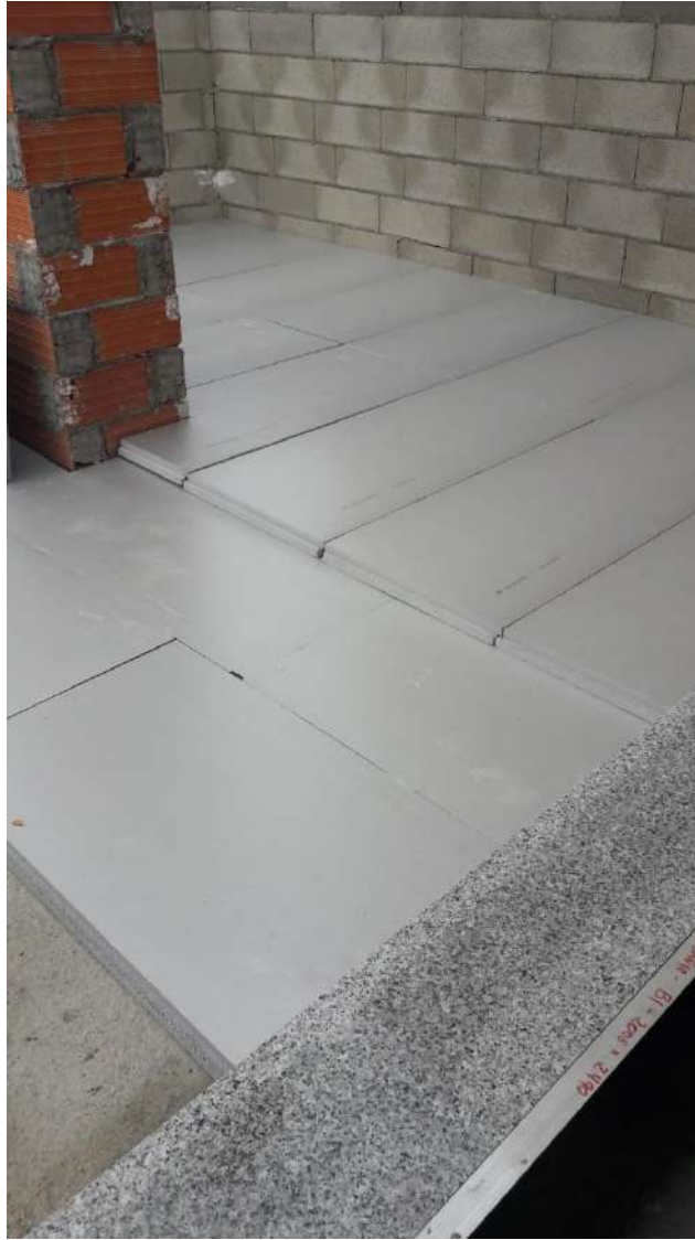
IMAGEN 55: Doble aislamiento de 5 cm en las cubiertas
