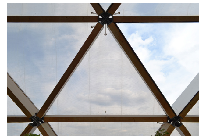
Fig. 4.6 Cojines de ETFE con dispositivo para inflado. Imagen propia.
