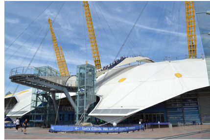
Fig. 3.1 Envoltente de PES-PVC en el Millennium Dome, Londres. Imagen propia.
