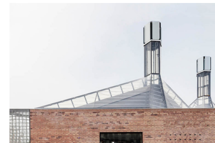
Fig. 3.4 Chimenea de membranas de ETFE en Cristalleries Planell. HARquitectes. Imagen de HARquitectes.
