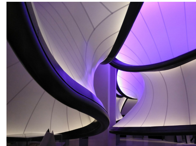
Fig. 5.17 Soldaduras en piezas de membranas de PES-PVC. Imagen propia.
