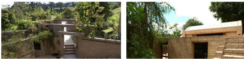
Imagen 27 - Dcha. Fotografía desde la cubierta hacia los patios. Izda. Fotografía del patio trasero.
