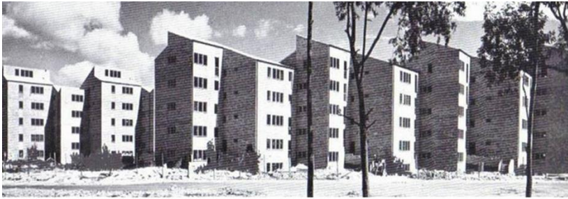
Imagen 10 - Espacios libres entre las edificaciones antes de ser fraccionados.
