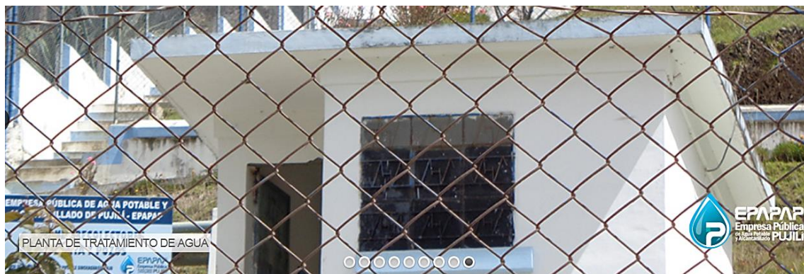
Figura 6 Planta de tratamiento de potabilización (fuente: EPAPAP).
