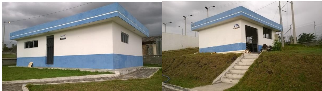
Figura 7 Tanque de almacenamiento.
