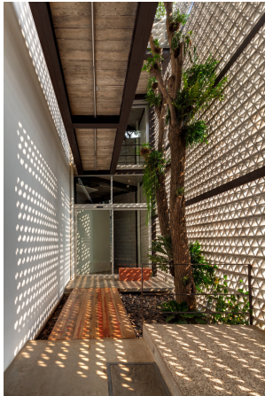
Imágen 41. Celosía de hormigón que cubre la fachada original
