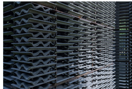
Imágen 46. Detalle de la celosía de hormigón
