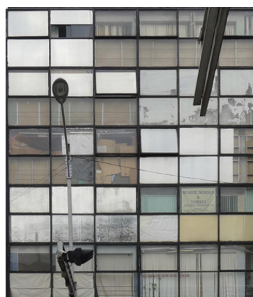
Imágen 51. Detalle de la fachada
