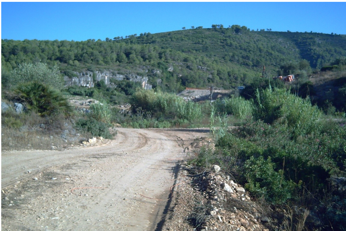
Foto 7. Obras de construcción de un azud, en el rio Vernissa.
