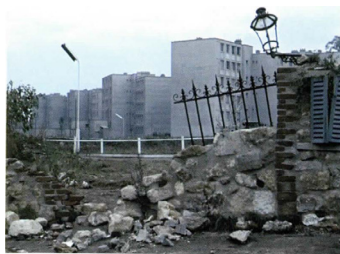
Fig. 121. Fotograma de la película Mon Oncle . Muro divisorio destruido.
