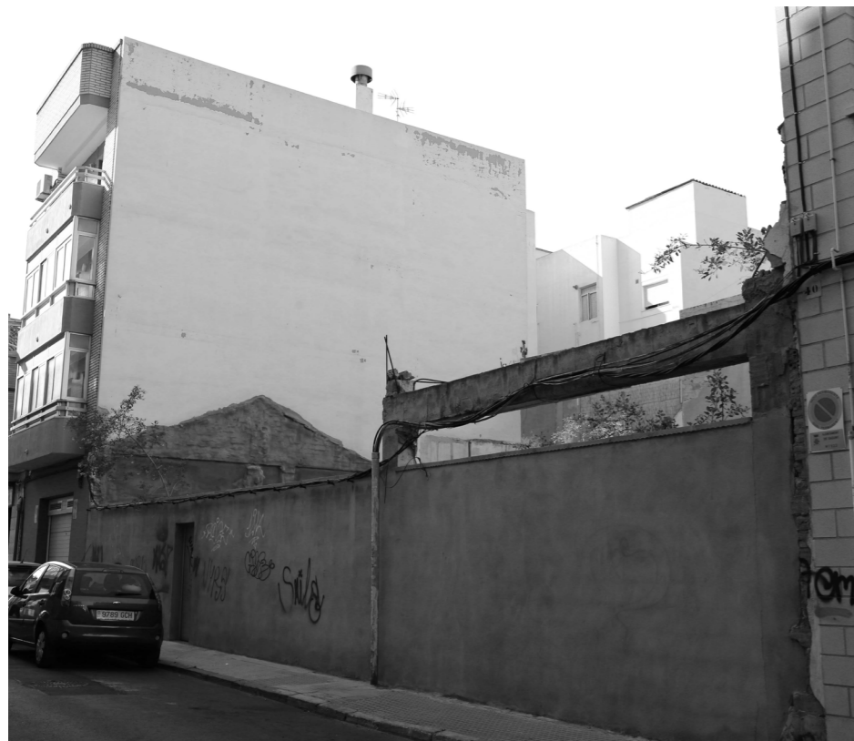
Solar en ruina sin edificación
