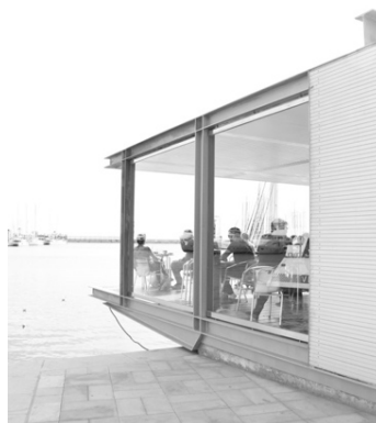
Imagen 9. Vista lateral del edificio. Fuente: fotografía propia.
