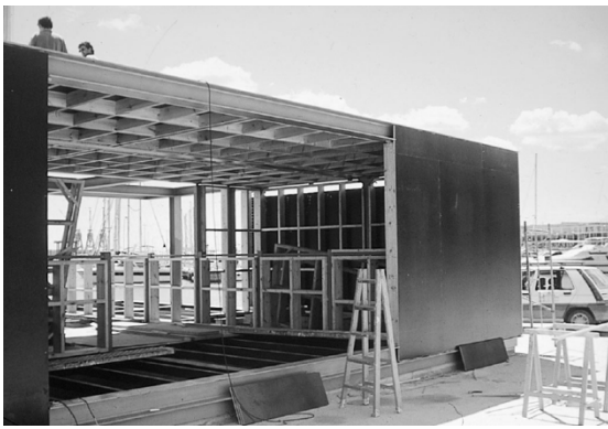
Imagen 10,11 y 12. Proceso de ejecución de la obra. Fuente: Construyendo barcos (2005). Alicante: Papeles de arquitectura, D.L. p. 73.
