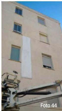
2.- Reparación mediante mortero.
