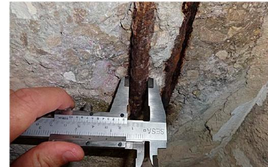
Control de la corrosión de la armadura del pilar.
