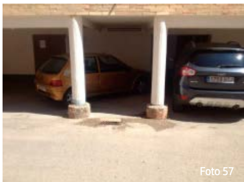
3.- Detalle de los pilares en mal estado. A&G Proyectos y Desarrollo. Perellonet. 2013.
