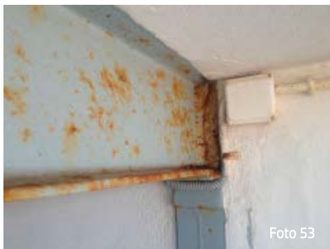
1.- Detalle de las vigas en mal estado. A&G Proyectos y Desarrollo. Perellonet. 2013.
