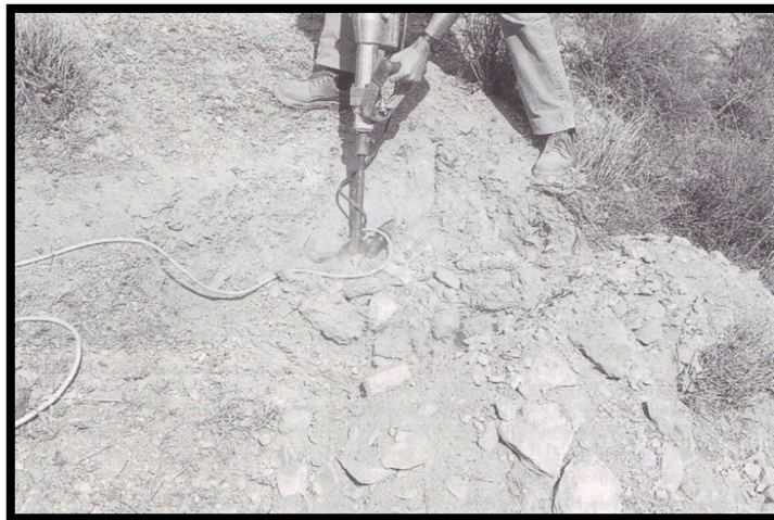
Ilustración 2: Detalle de ejecución de ahoyado manual mediante pico eléctrico. Fuente: LOPEZ CARDENAS DE LLANO, F. (Coord.)(1998). “Restauración hidrológico forestal de cuencas y control de la erosión.Ingeniería Medioambiental”.
