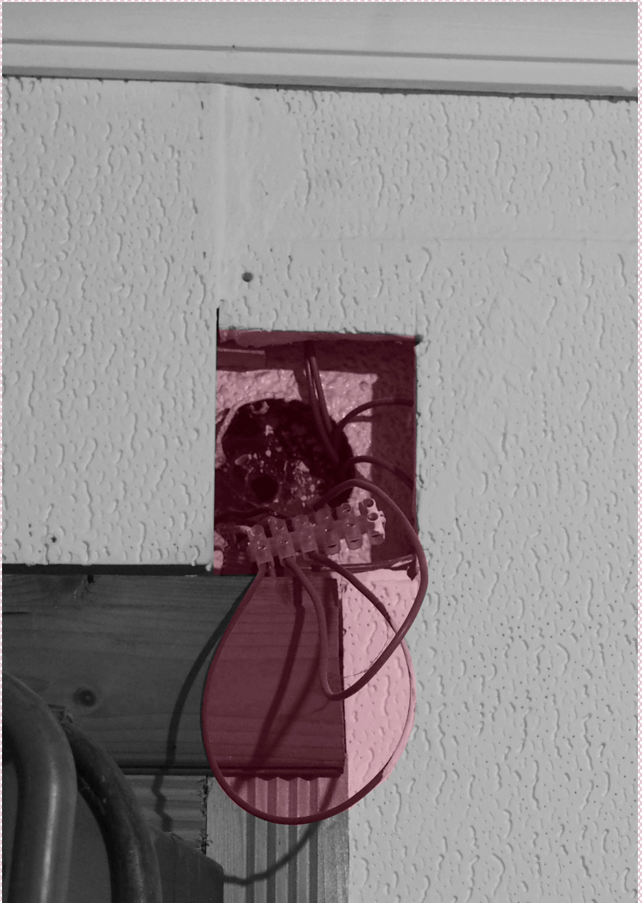
Figura 28. _ 3.4 Cableado en el salón
