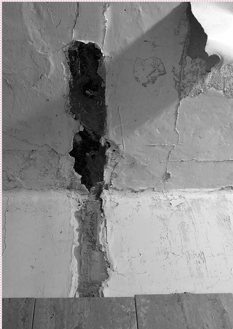
Figura 20. _1.1 Vigueta con aluminosis en la cocina
