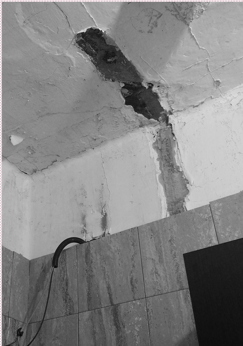
Figura 19. _1.1 Vigueta con aluminosis en la cocina
