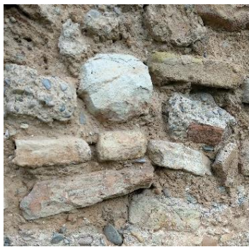
Figura 13. Detalle de muro de mampostería de la Alquería del Moro. Fuente propia.
