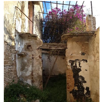
Figura 24. Detalle porche oeste de La Alquería del Moro. Fuente propia.
