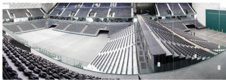
Fig. 21. Interior del Navarra Arena. Graderíos retráctiles que dividen el espacio en una pista central y un frontón.
