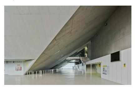
Fig. 24. Corredor del Gran Canaria Arena. Apréciese el gran recipiente de hormigón en el que se encuentra la pista central.
