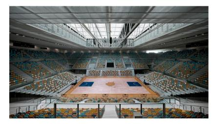
Fig. 25. Pista central del Gran Canaria Arena. Apréciese los graderíos retráctiles en el anillo inferior, así como el lucernario que ilumina el interior.
